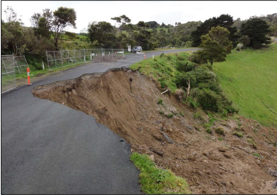
Resim 2.1. Zeminlerde açılmış şevlerde gözlenen kavisli-dönel kayma [10]
