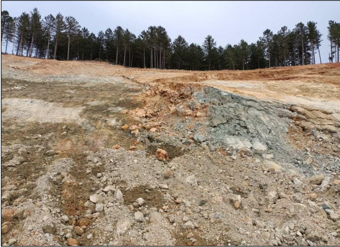
Resim 4.3. Kütle hareketlerinin ve su sızıntılarının da gözlemlendiği suya doymuş şev
