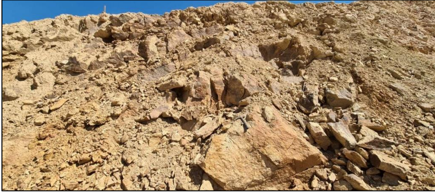
Resim 6.14. Tamamen ayrılmış kaya kütlmesine ait fotoğraflar (2)
