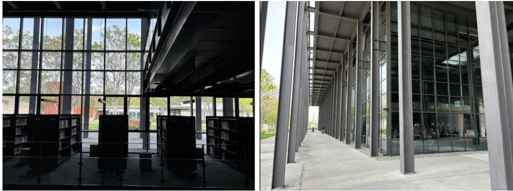
Şekil 38: Abdullah Gül Üniversitesi Kütüphanesi Cephesi
