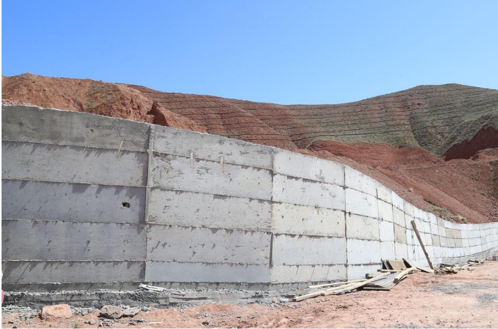
Şekil 18. Betonarme istinat duvarı (URL-4, 2024)
