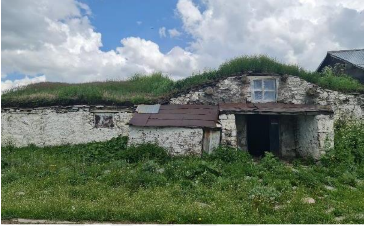
Resim 4. 11. atısı toprak rtl hayvan barınak yapısı (17.06.2023)
