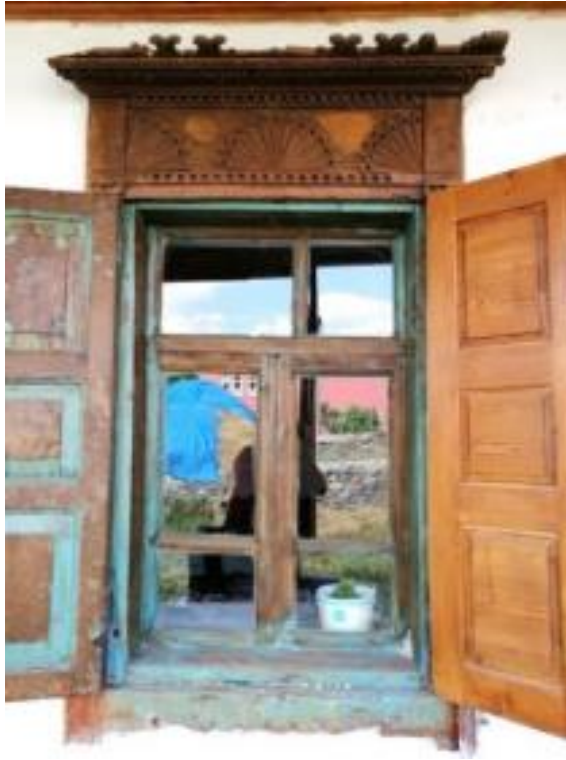
Resim 4. 8. Ahşap pencere ve dış kapaklarının (stavni) görünüşü (Orhan, 2021)
