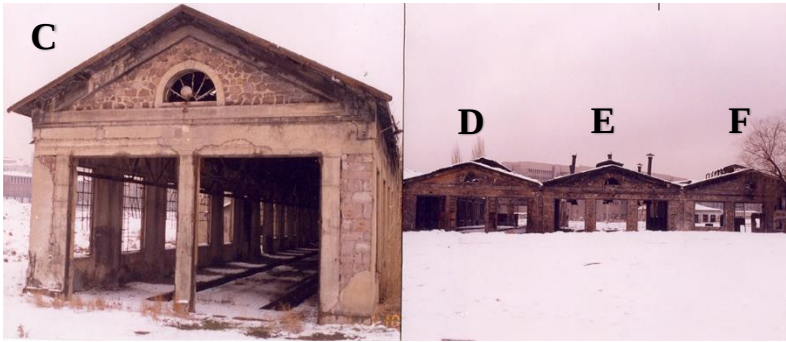
Şekil 3.1. Cer Atölyeleri (Fotoğraf Uygur Mimarlık sitesinden alınmıştır, fotoğraf Cemal Emden'e aittir) (URL-40)
