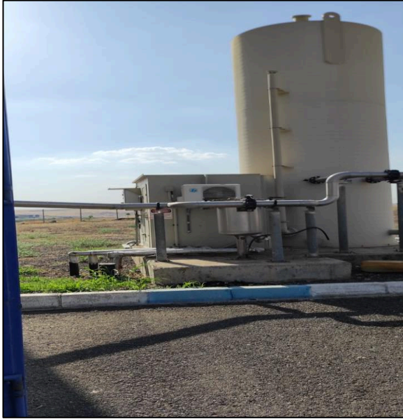
Şekil 3.25. Desülfürizasyon ünitesi
