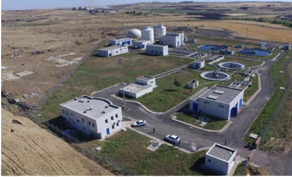
Şekil 3.1. Siverek Atık Su Arıtma Tesisi
