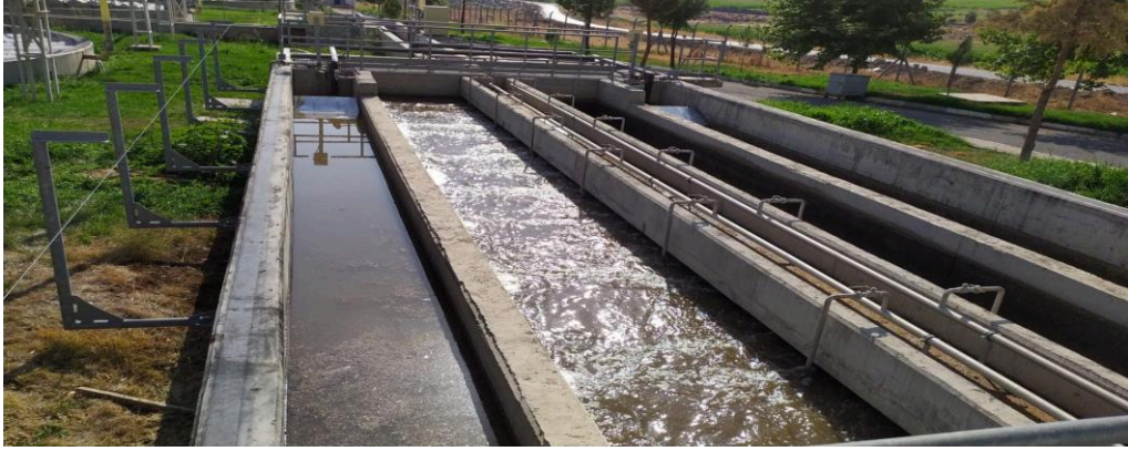
Şekil 3. 4. Kum ve yağ tutucu havuzu
