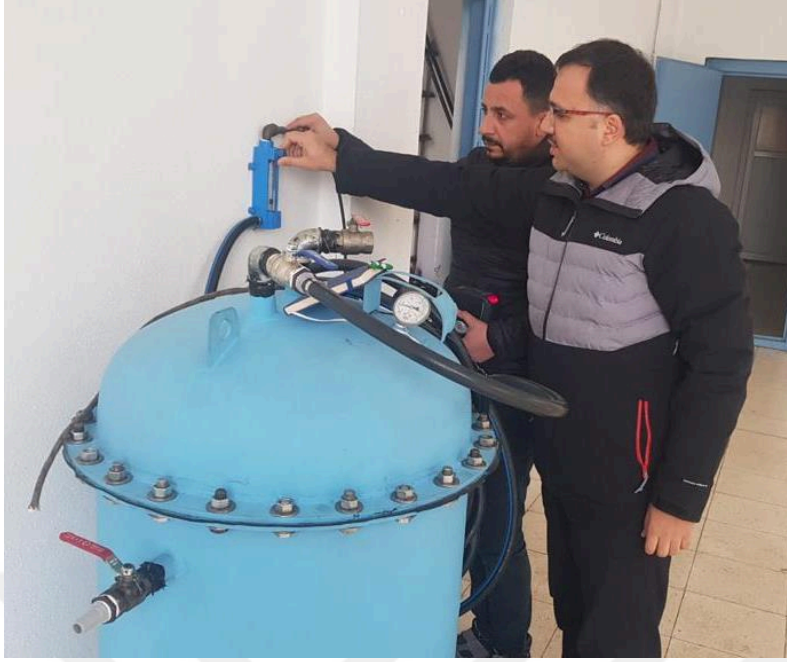
Şekil 3.32. Debimetrelili vana ile biyogaz debi ayarlaması
