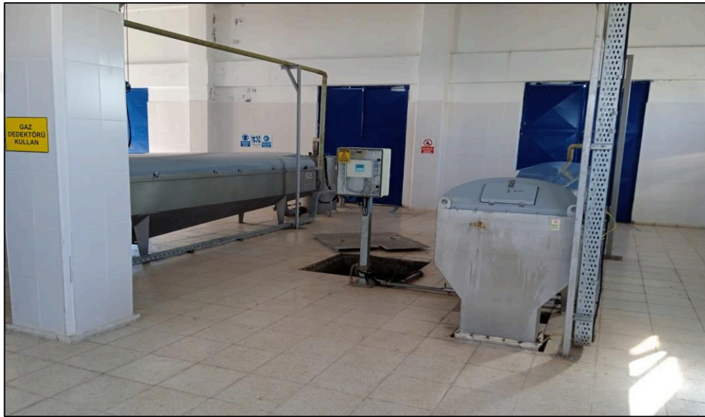
Şekil 3.18. Mekanik yoğunlaştırma ünitesi
