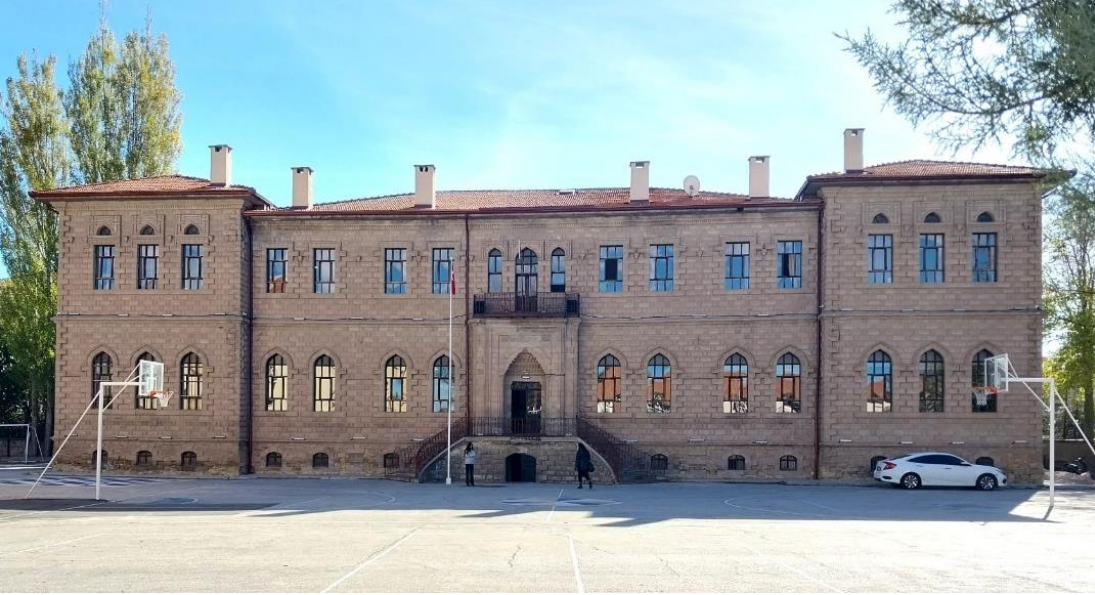
Fotoğraf 4.9. Aksaray İdadi Mektep Batı Cephe Görünüm
