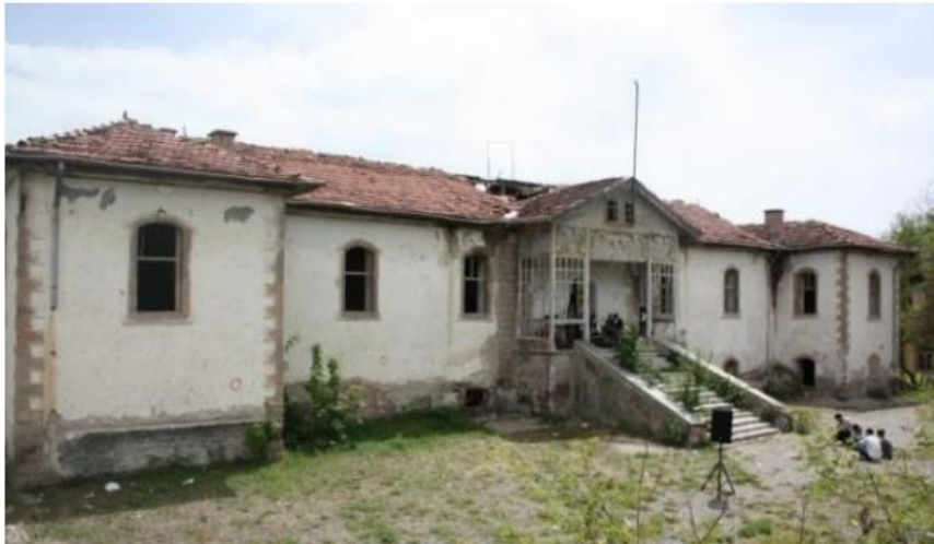
Fotoğraf 4.14. Kayseri Pazarören Köy Enstitüsünün Cephe Görünümü
