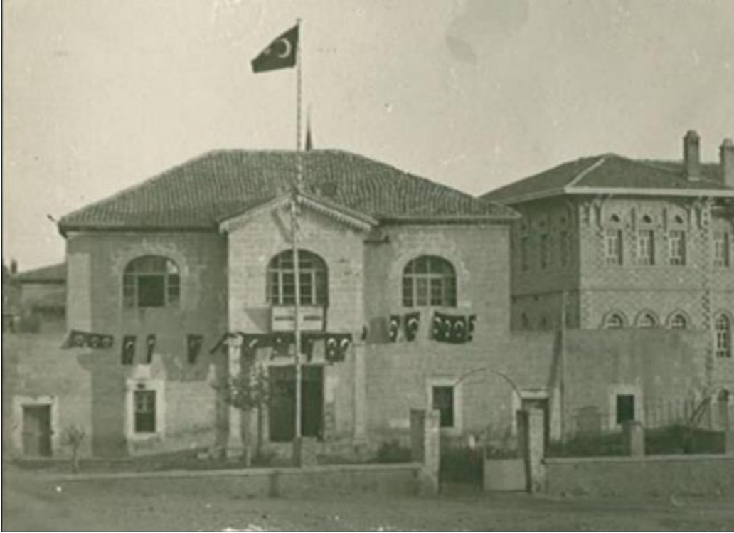
Fotoğraf 4.3. Aksaray Askerlik Şubesi Binası Cephe Görünümü
