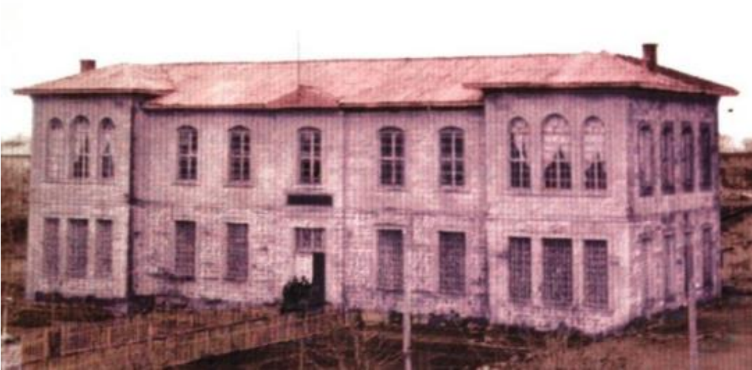
Fotoğraf 4.7. Kayseri Ticaret Lisesi Cephe Görünümü
