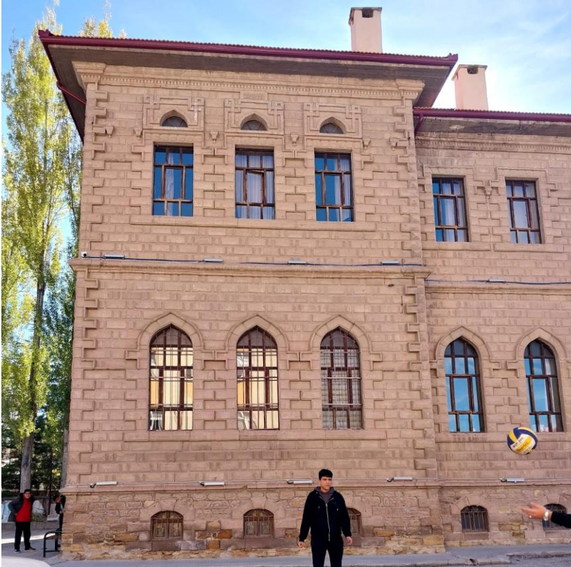
Fotoğraf 3.10. Aksaray İdadi Mektep Güney-Batı Cehpe Görünüm
