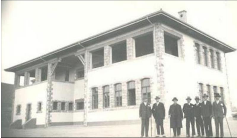
Fotoğraf 3.23. Kuzey-Batı Cephe Görünüm
