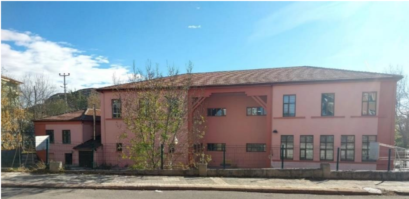
Fotoğraf 3.24. Kuzey-Batı Cephe Görünüm
