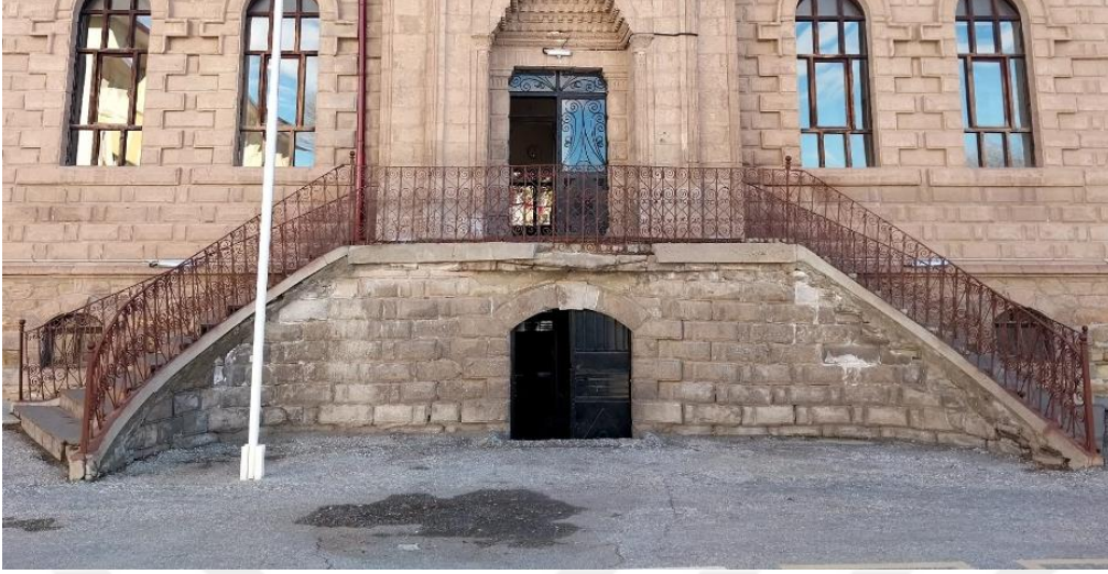
Fotoğraf 3.17. Batı Cephesi Bodrum Kat Giriş
