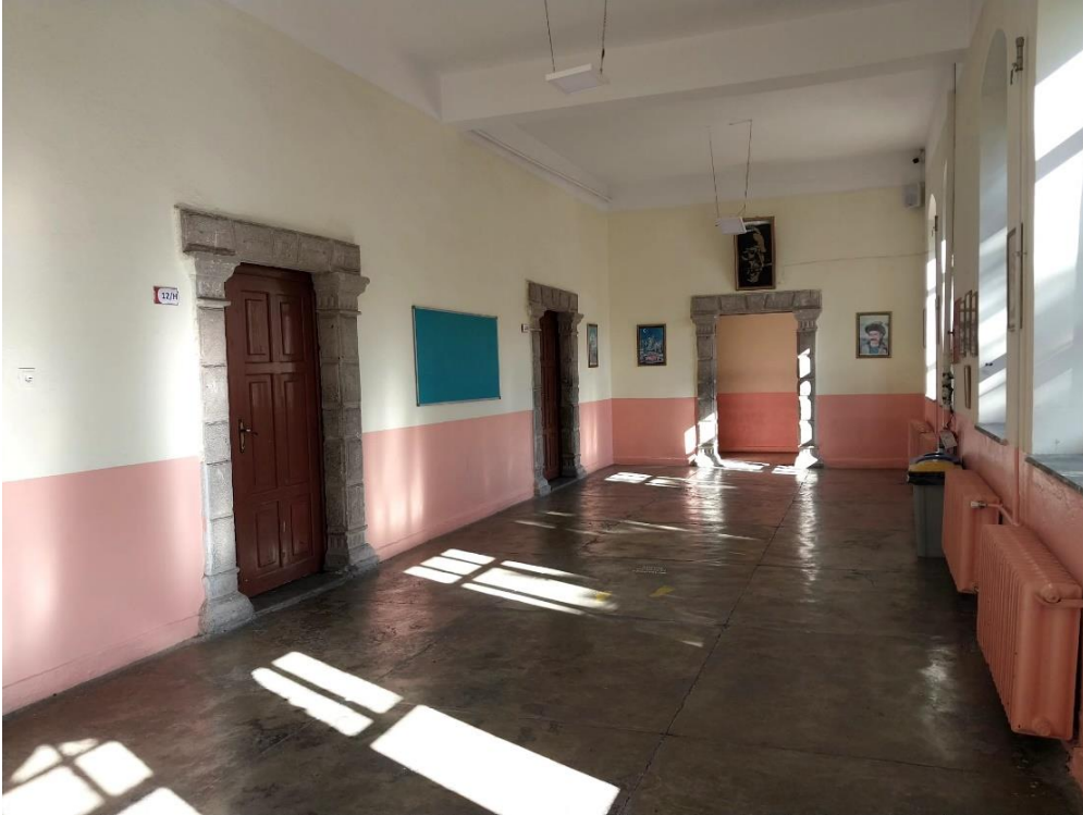
Fotoğraf 3.20. Yapı İç Mekan Birinci Kat Güney Koridor
