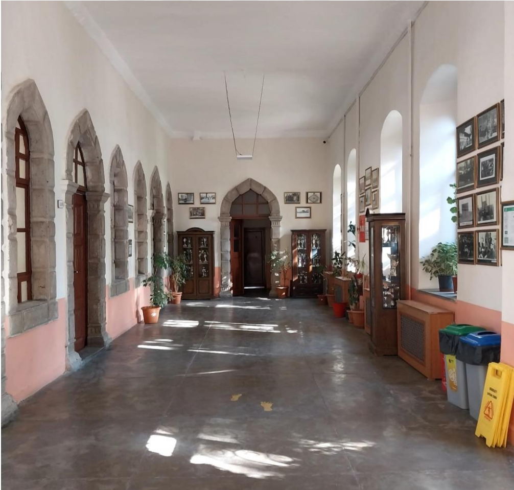
Fotoğraf 3.18. Yapı İç Mekan Zemin Kat Güney Koridor
