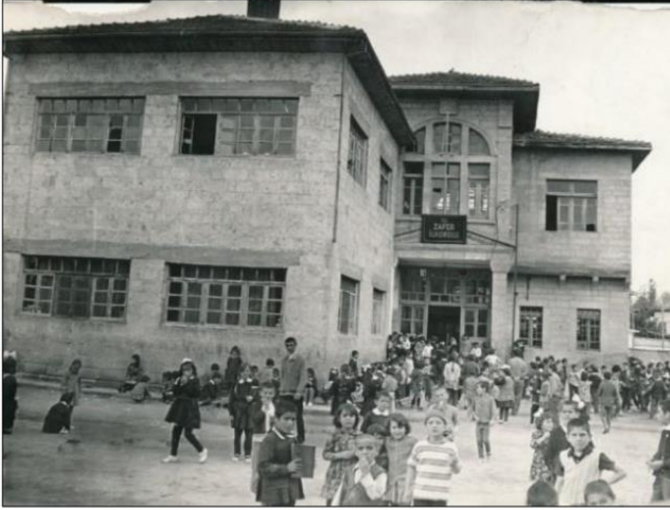
Fotoğraf 3.28. Cephe Görünüm
