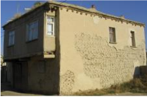
Şekil 2.3. Duvar boyunca herhangi bir destek veya hatıl kullanılmadan inşa edilmiş kerpiç bir yapı(Korkmaz, 2007).
