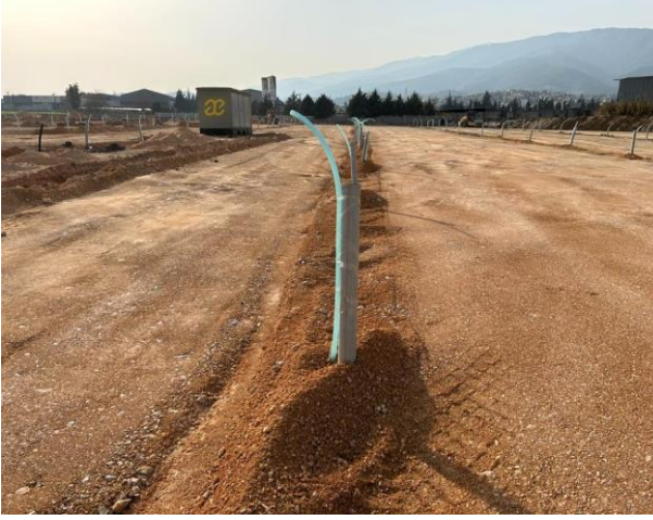
Şekil 3.13. Konteyner kentlerde kullanılan pis su-temiz su altyapı bağlantısı (AFAD röportajı, 2023).
