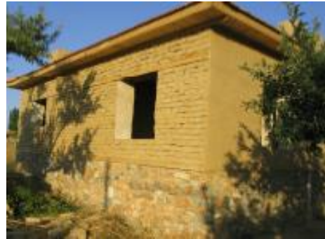
Şekil 2.4. Hatıllı kerpiç bir yapı(Korkmaz, 2007).
