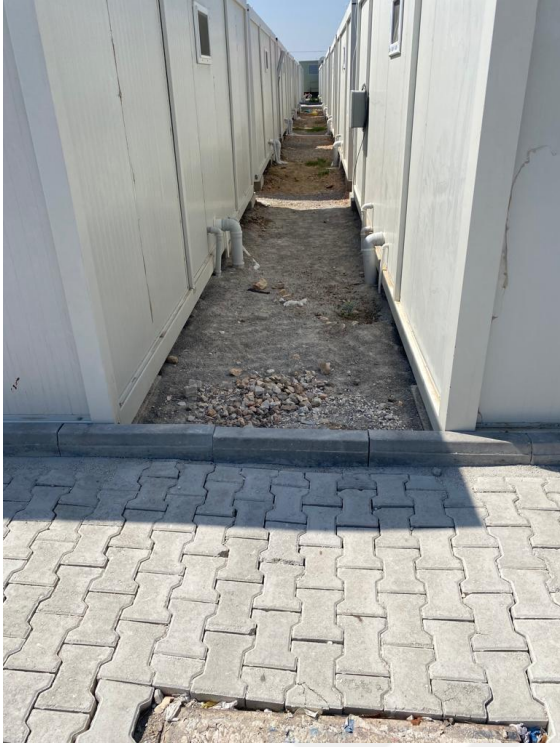
Şekil 3.9. Konteynerlerin altyapı bağlantısı (AFAD röportajı, 2023).
