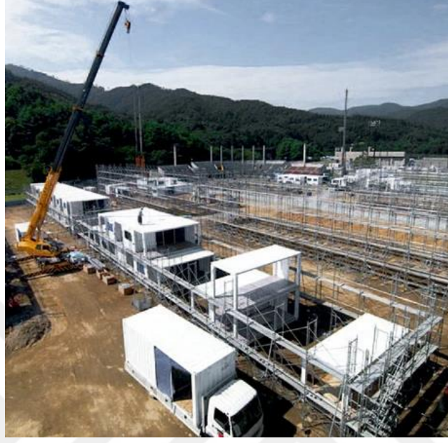
Şekil 3.24. Onagawa konteyner konutları inşaat süreci, Japonya (Url 16).
