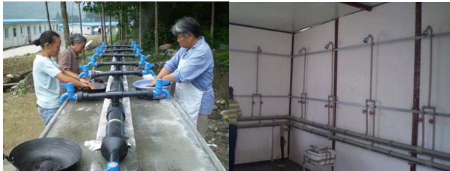
Şekil 3.21. 2008 Wenchuan Depremi Sonrası Geçici Barınma Birimlerindeki Ortak Su Alanı-Duş Alanı (DESA, 2009; Kalkan,2019).
