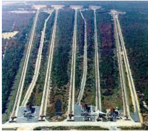
Şekil 12. ABD’de bulunan Lakehurst Test Merkezinin Görünümü
