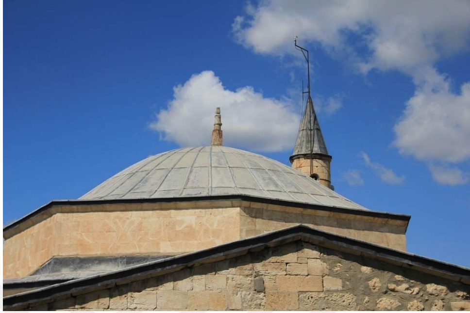
Fotoğraf 3.3. Dış mekânda kubbenin oturduğu sekizgen kasnak
