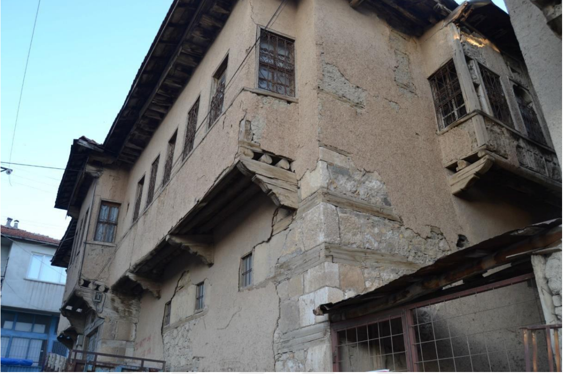
Fotoğraf 3.63. Yapı güneydoğu cephesi doğu duvarı
