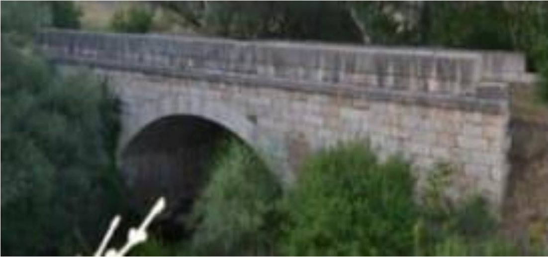
Fotoğraf 3.75. Höyük Deresi Köprüsü Cephe Görünümü
