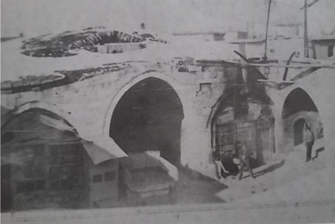
Fotoğraf 3.37. Güney cephenin onarım öncesi hali
