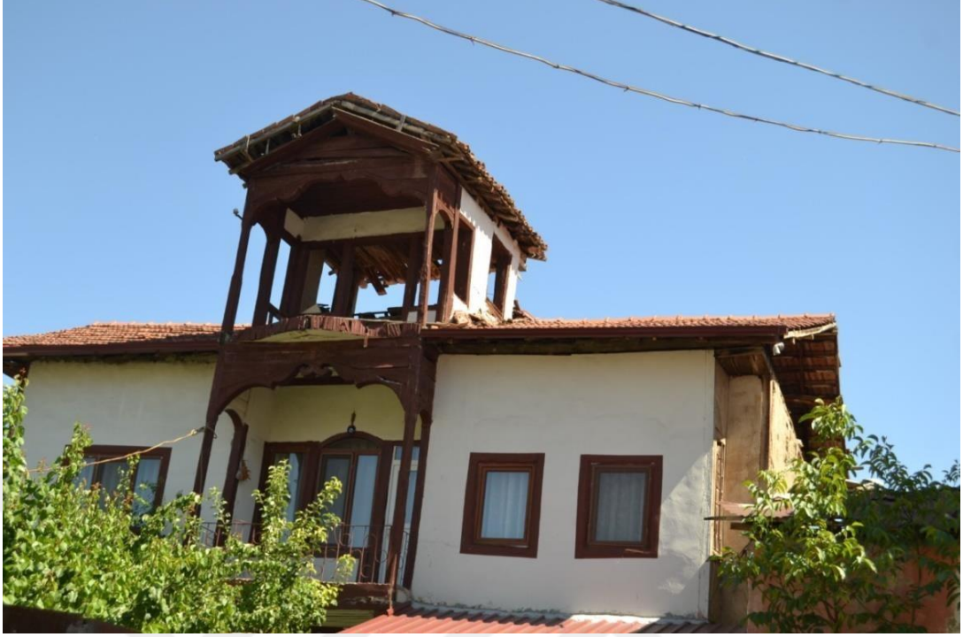
Fotoğraf 3.51. Konağın çatısı ve köşk odası
