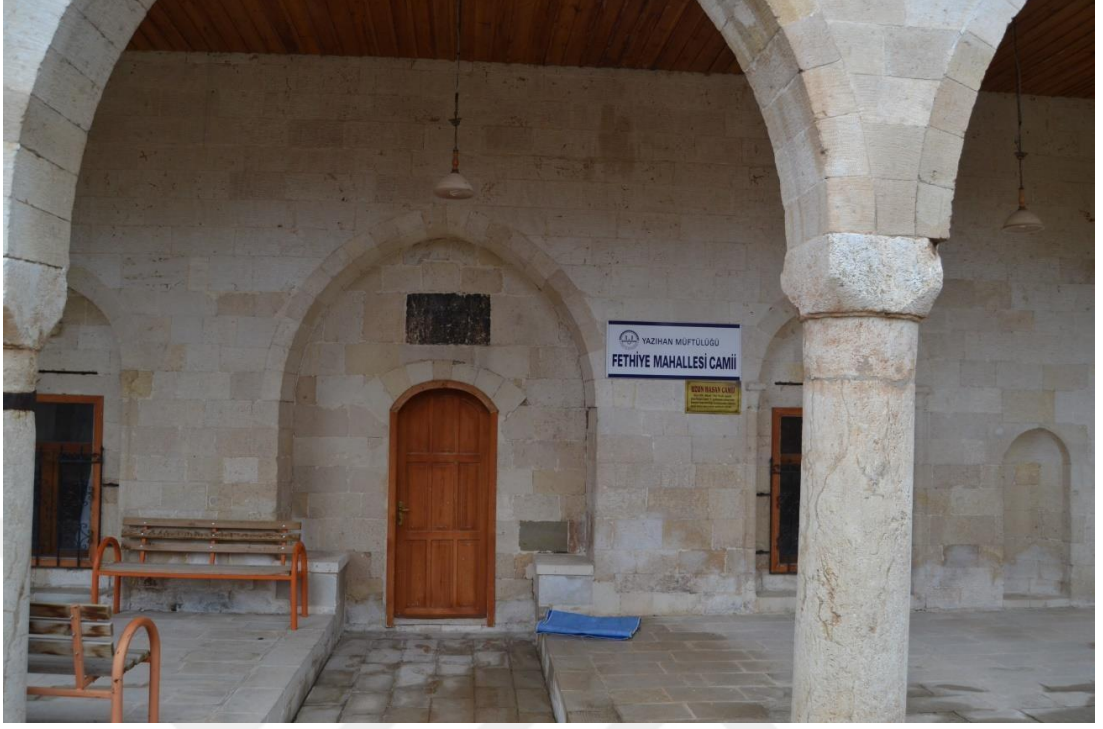
Fotoğraf 3.16. Kuzey cephede bulunan giriş kapısı
