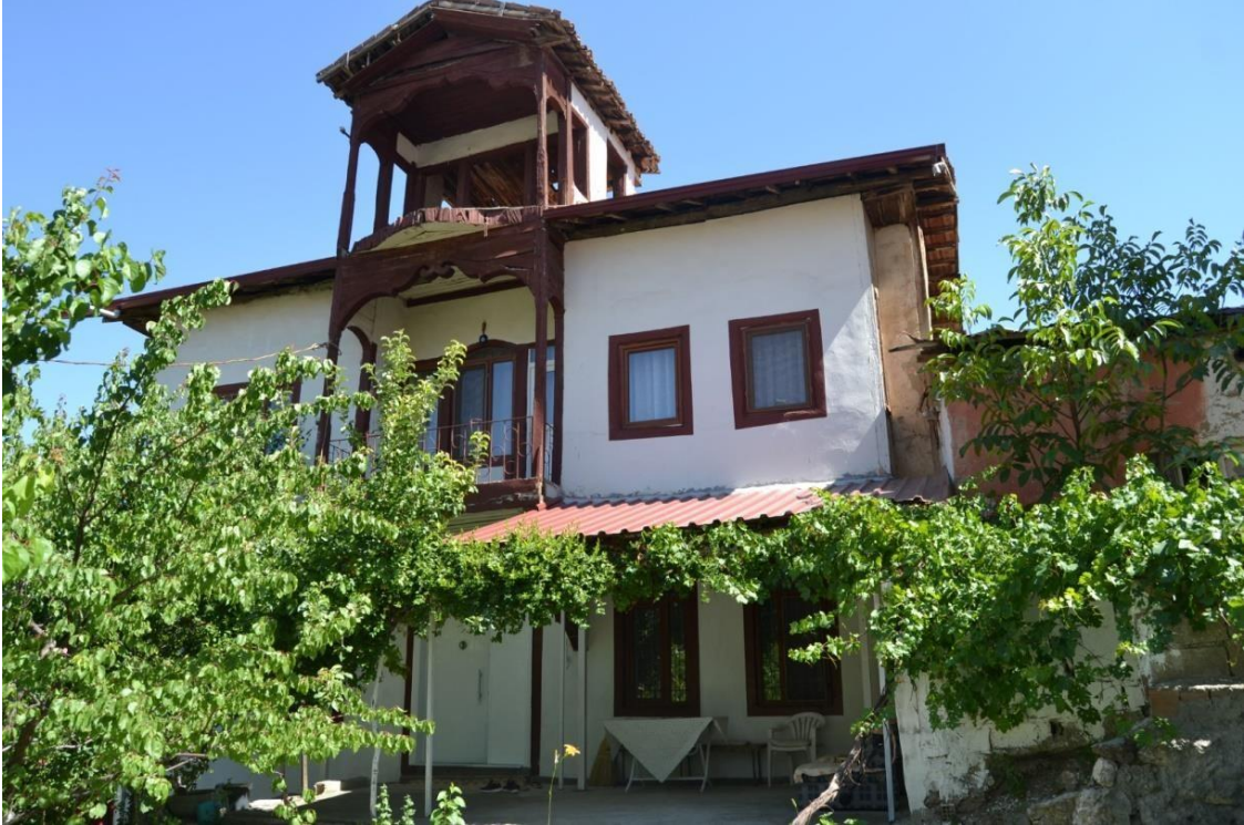
Fotoğraf 3.49. Kuzey cepheden görünüm
