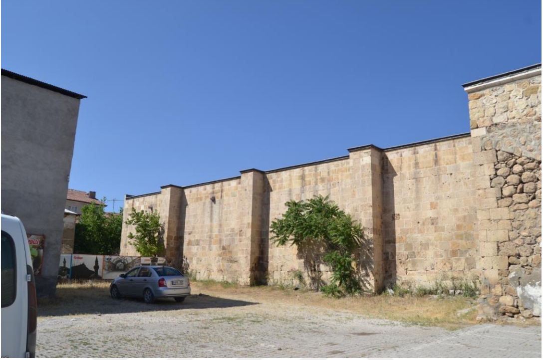
Fotoğraf 3.45. Batı cephesinde bulunan payandalar
