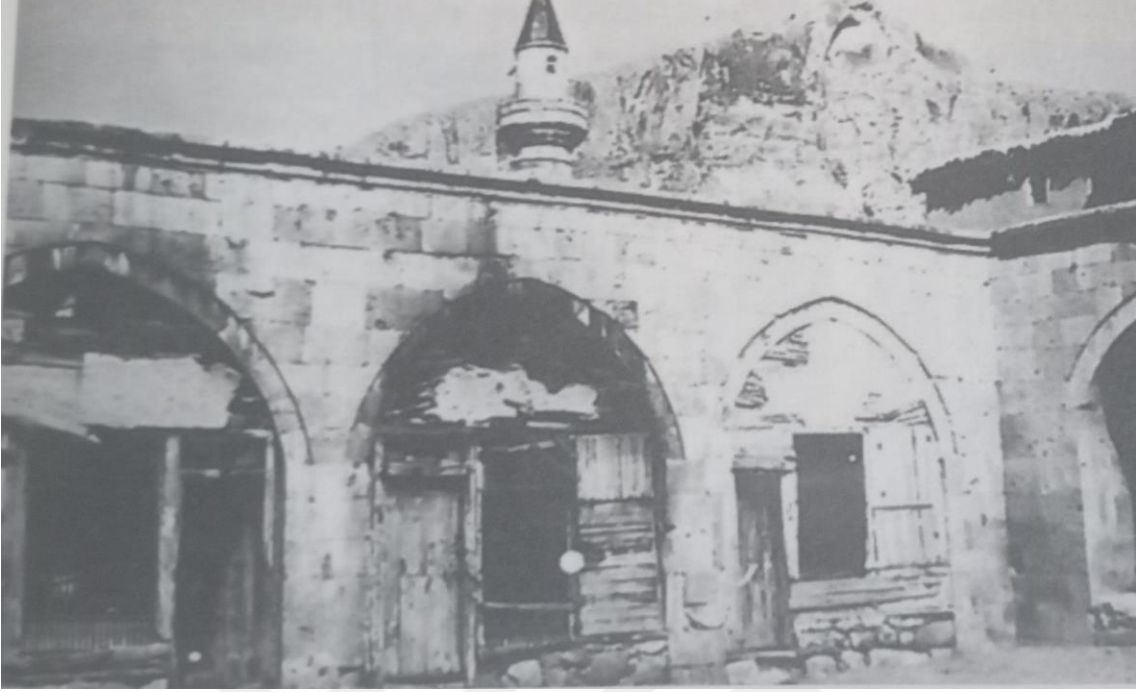
Fotoğraf 3.34. Avlunun dođu kanadının restorasyon öncesi durumu
