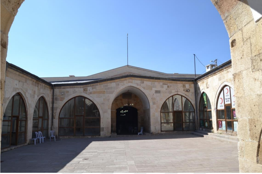
Fotoğraf 3.36. Güney cephede yer alan eyvanlar ve barınak girişi
