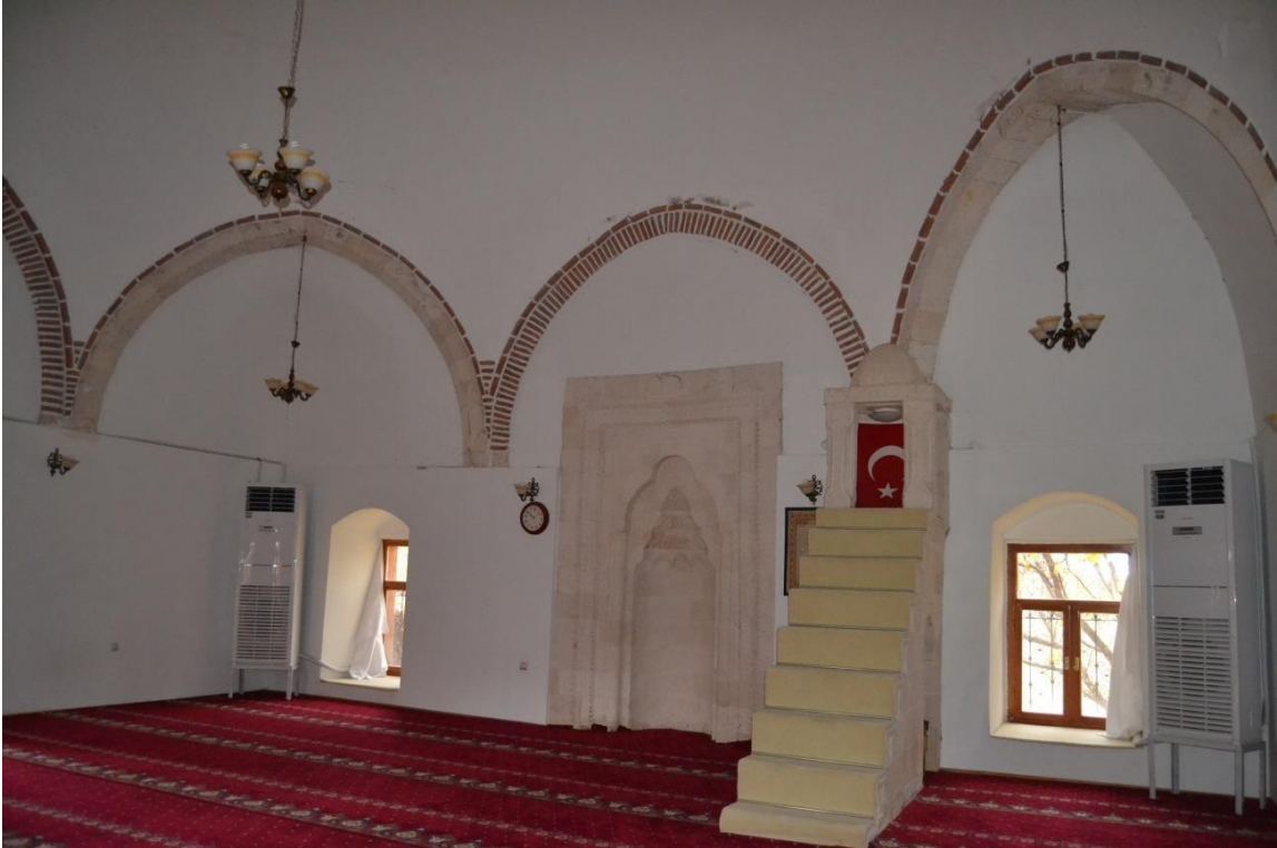
Fotoğraf 3.20. Güney cepheden görünüş
