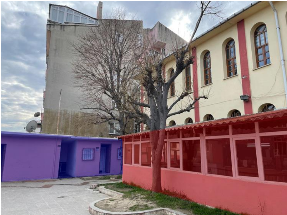
Şekil A.97: Doğu cephede terasta yer alan niteliksiz ekler.
