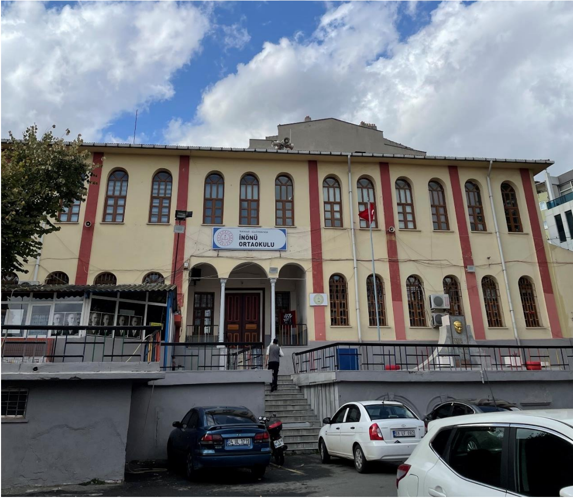
Şekil A.62: Doğu cephesi bahçe kotundan.
