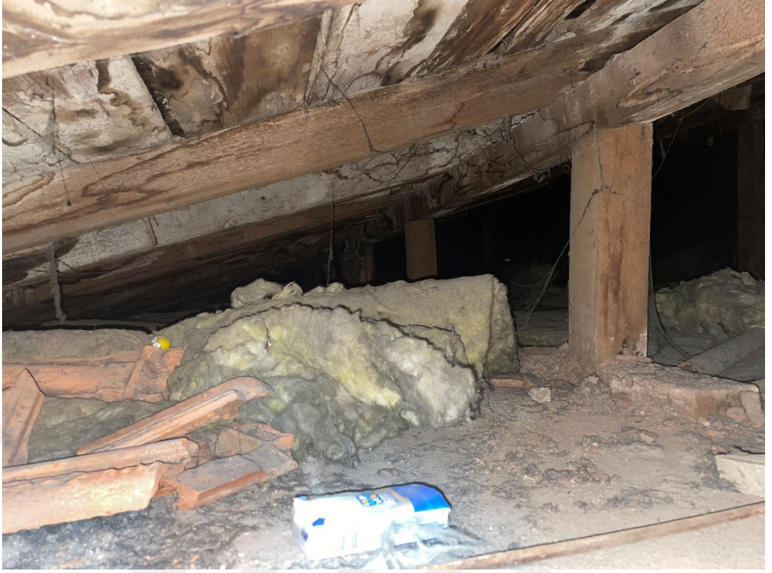
Şekil A.76: Çatı arası kuzey cepheye doğru bakış.
