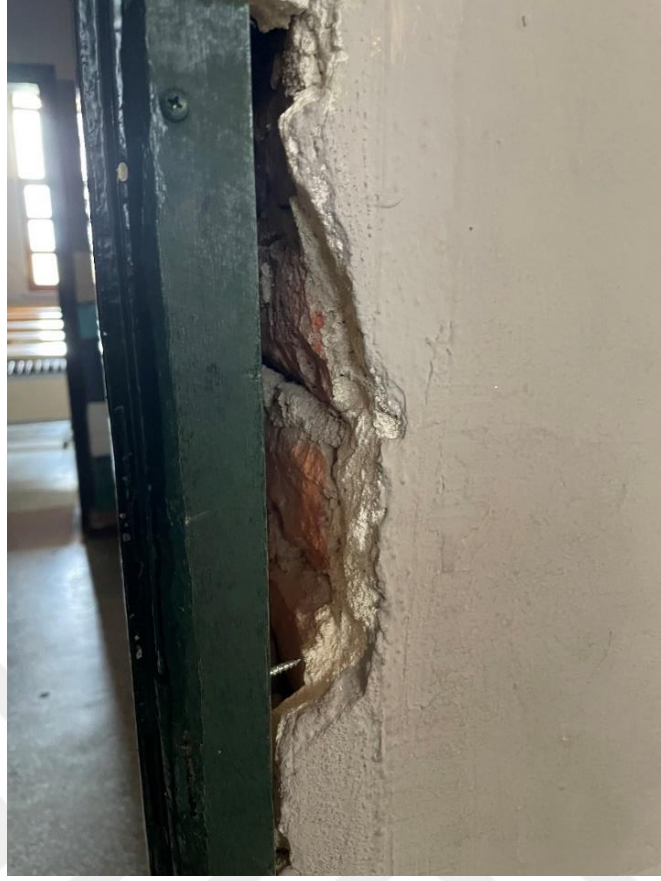
Şekil A.72: İç duvar tuğla malzemesi.
