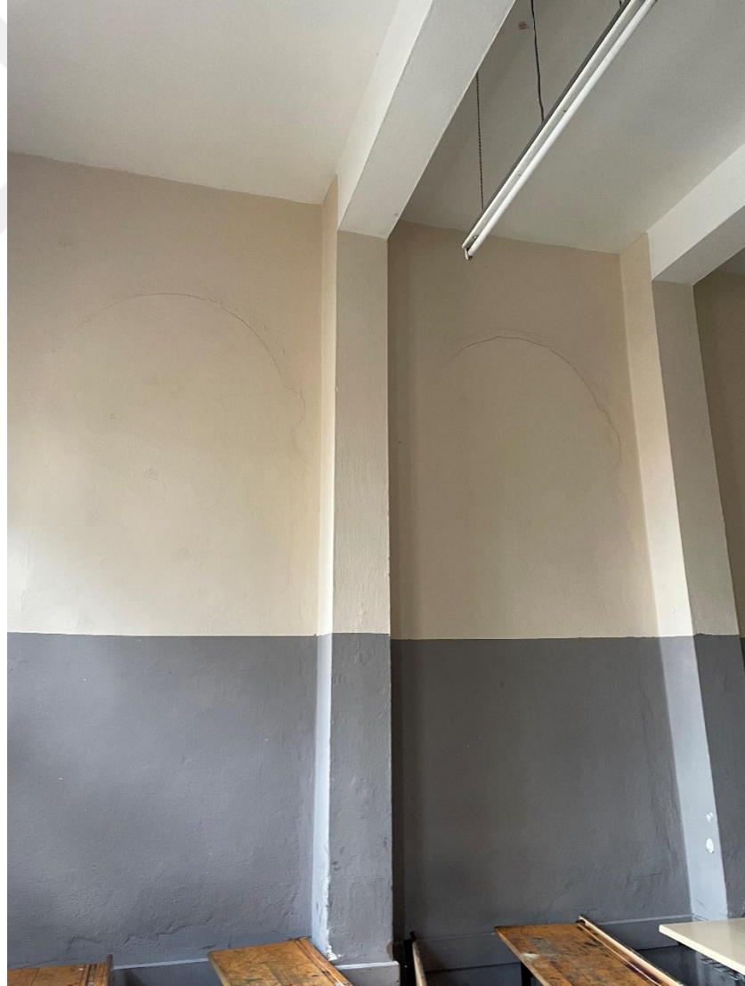
Şekil A.101: Güney cephedeki kapatılan pencere izleri.
