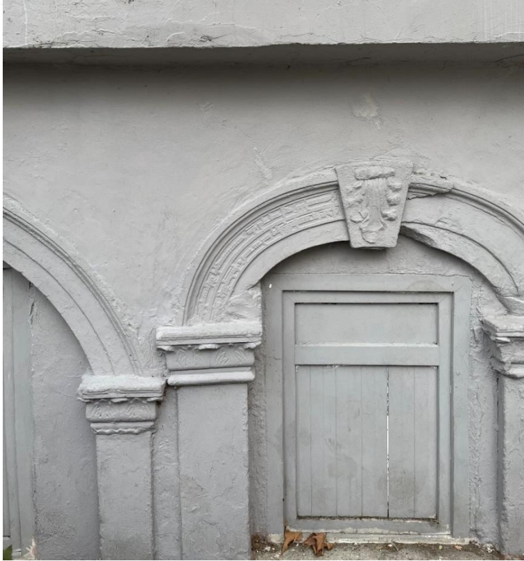
Şekil A.79: Mahzen girişi kemerli açıklıklar.
