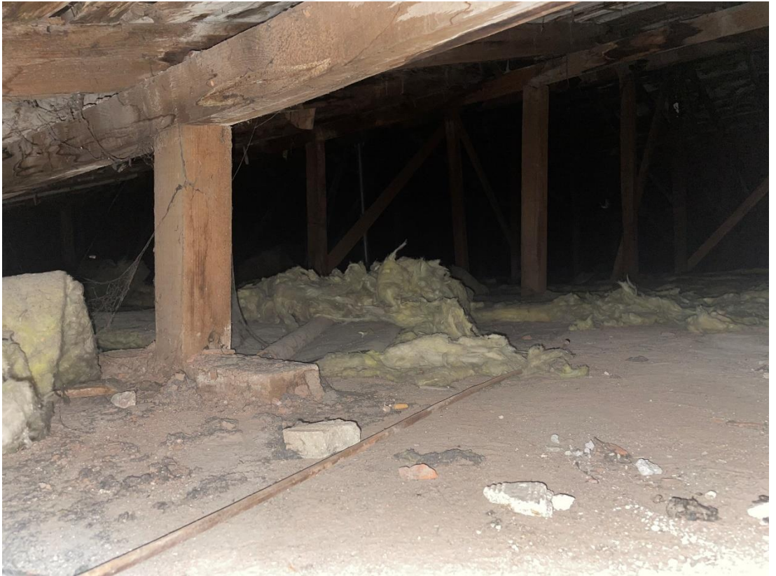
Şekil A.77: Çatı arası kuzeydoğu yönüne bakış.
