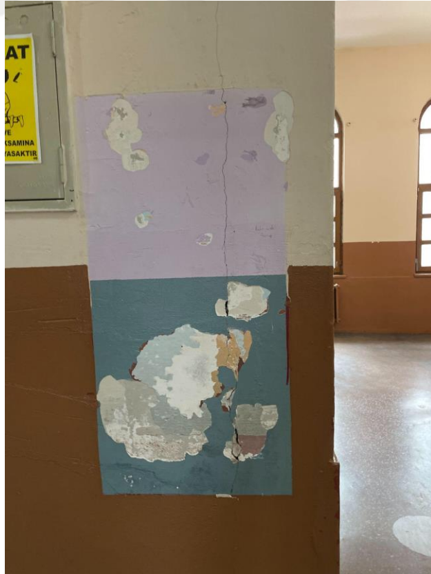
Şekil A.104: Sıva ve boya dökülmesi örneği.
