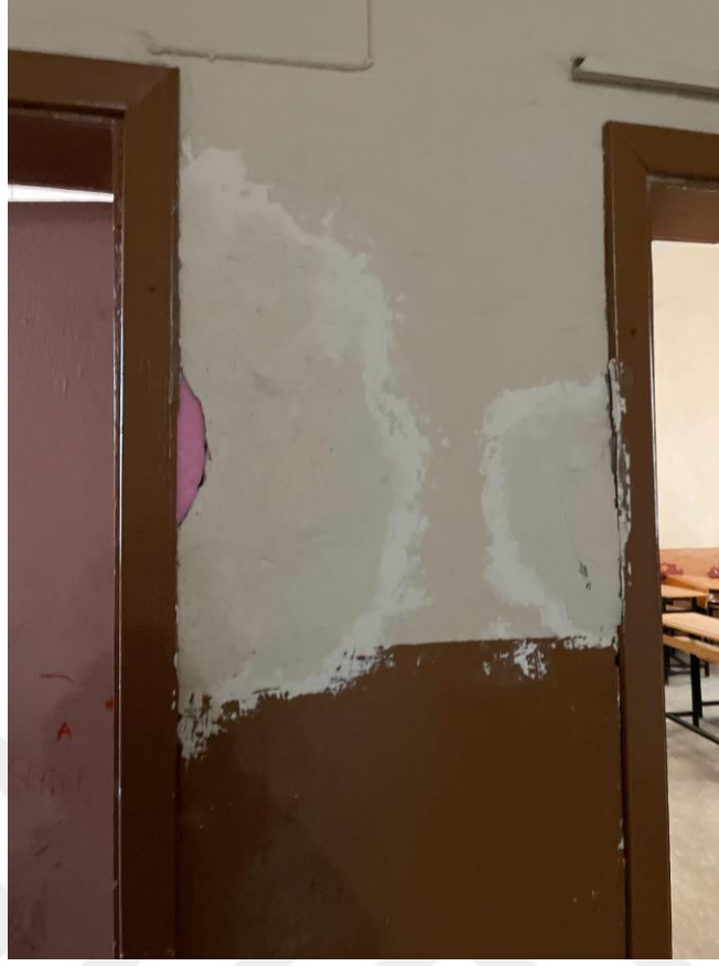
Şekil A.104: Sıva ve boya dökülmesi örneği.
