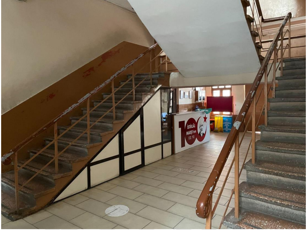
Şekil A.11: Birinci kata çıkan merdiven.
