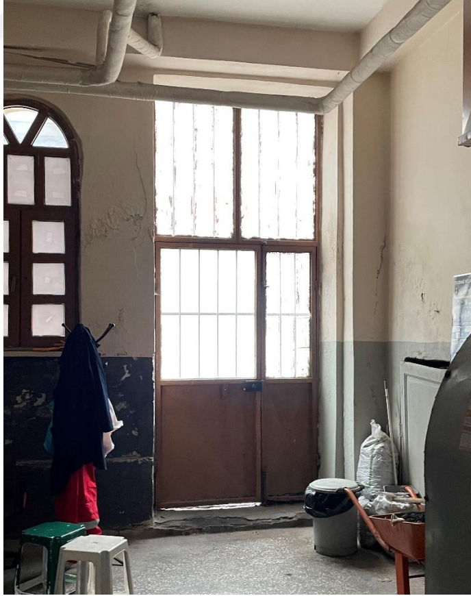
Şekil A.83: K05 Demir kapı kazan dairesinden görünümü.
