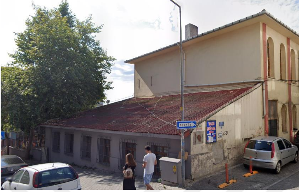
Şekil A.65: Kuzey cephe Demir Sokak'tan görünüm (Google Maps).
