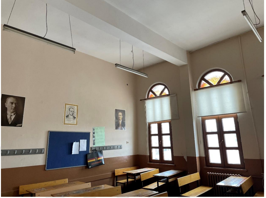
Şekil A.39: K-112 Sınıfı doğu cephe yönüne doğru.
