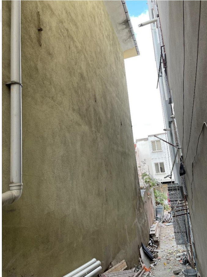
Şekil A.71: Güney cephesi.
