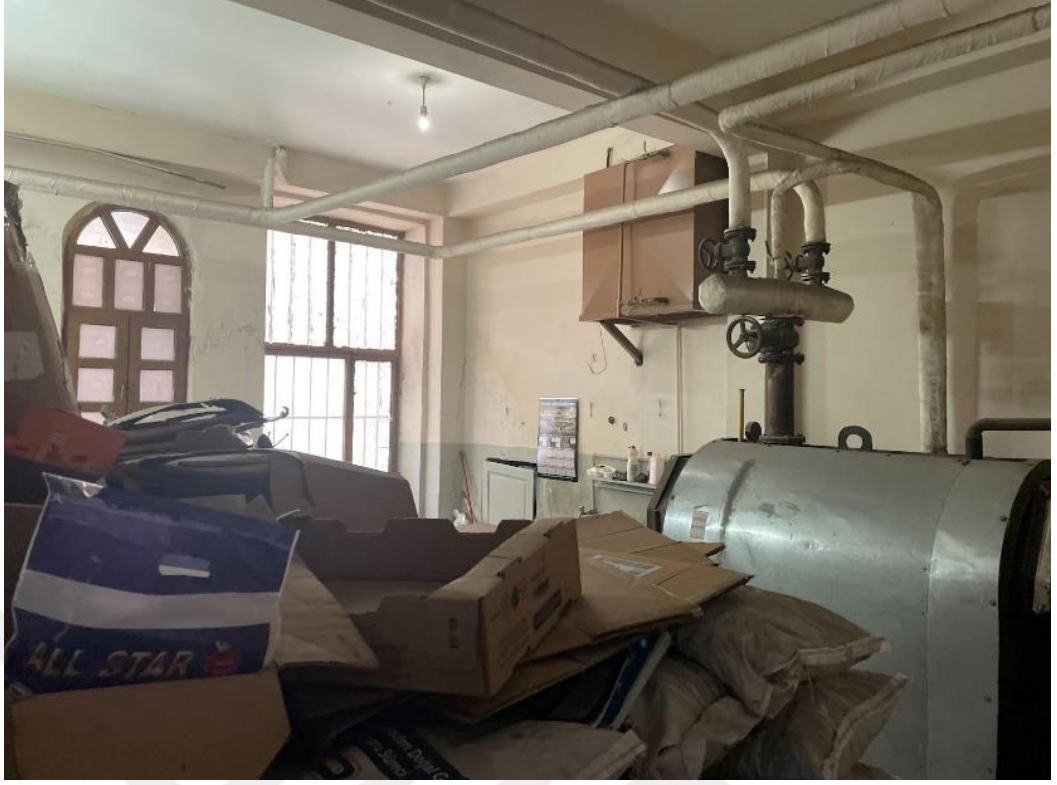
Şekil A.3: Z02 Depo ve kazan dairesi odası.
