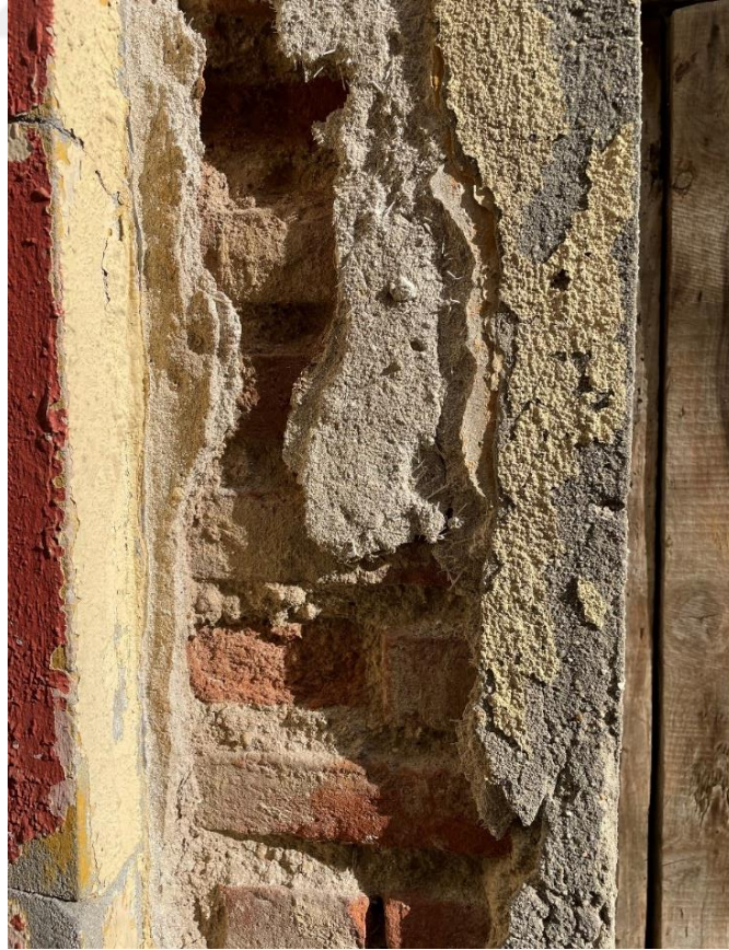
Şekil A.73: Batı cephe beden duvarı tuğla örgüsü.
