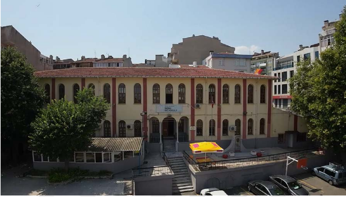
Şekil A.61: Doğu cephesi.
