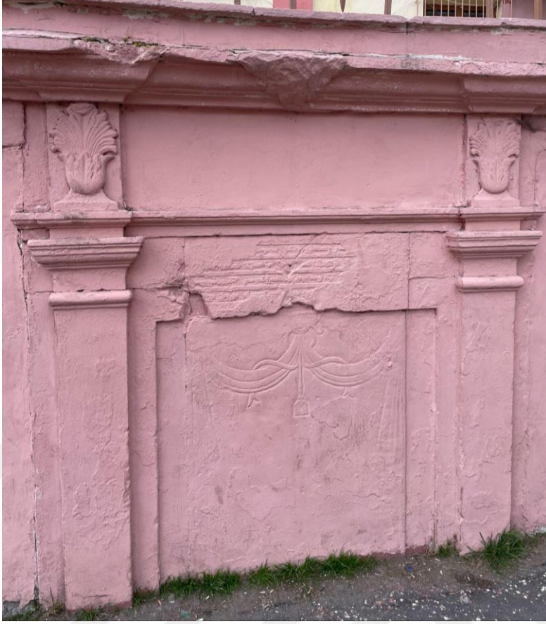
Şekil A.78: Doğu cephe çeşme duvarı.
