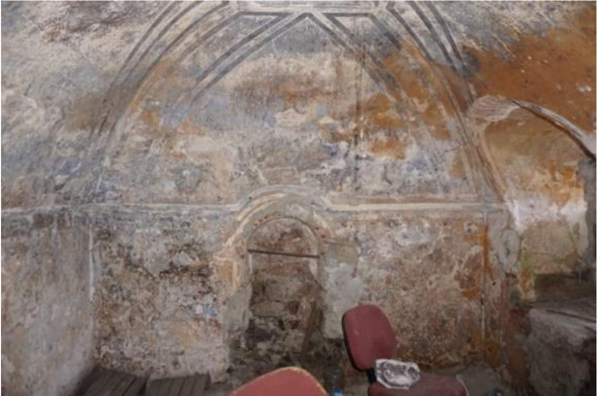
Şekil A.58: Manastır tonozlu mahzen odası (Çinko, 2023, s.557).
