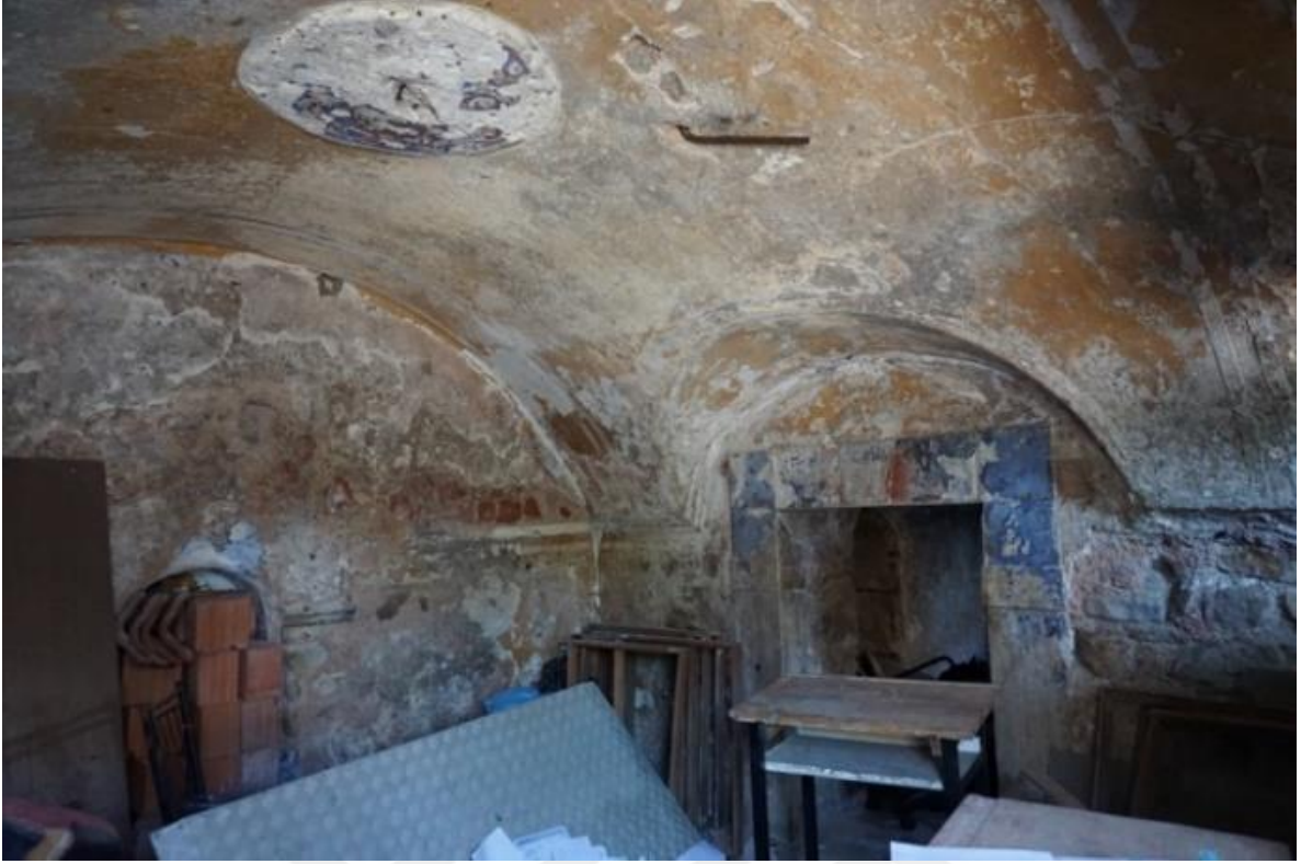
Şekil A.57: Beşik tonozlu mahzen odası (Çinko, 2023, s.556).
