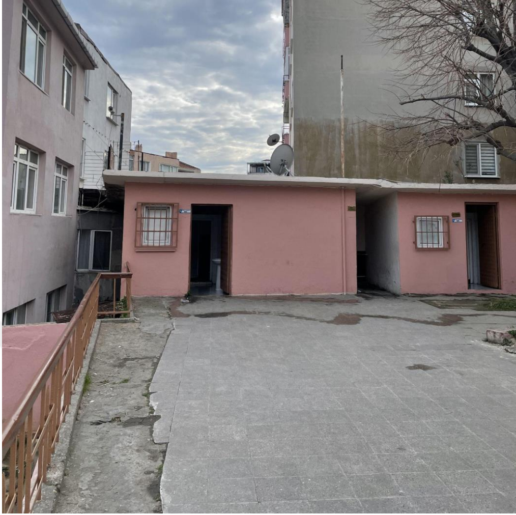
Şekil A.96: Doğu cephede terasta bulunan tuvaletler.
