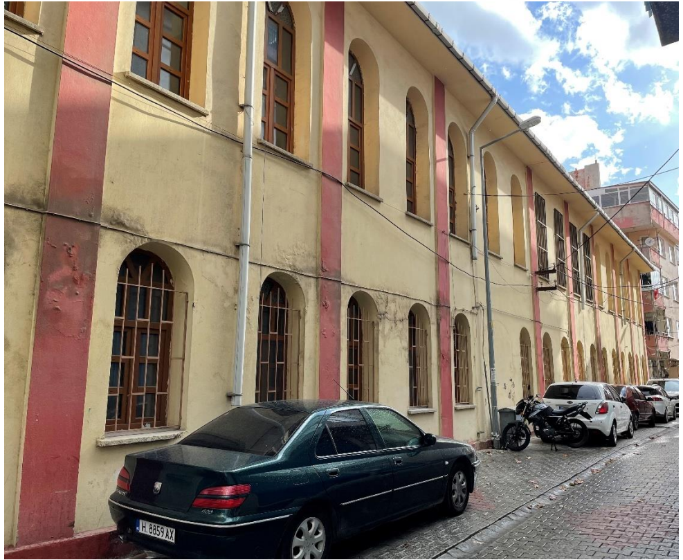
Şekil A.69: Batı cephesi ve İkbal Sokak.
