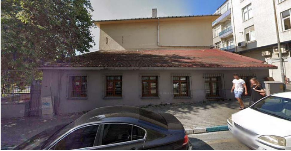
Şekil A.66: Kuzey cephe (Google Maps).
