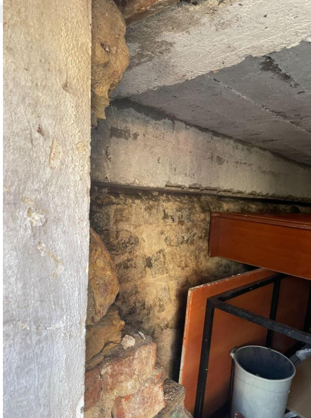
Şekil A.44: B09 Depo girişi.
