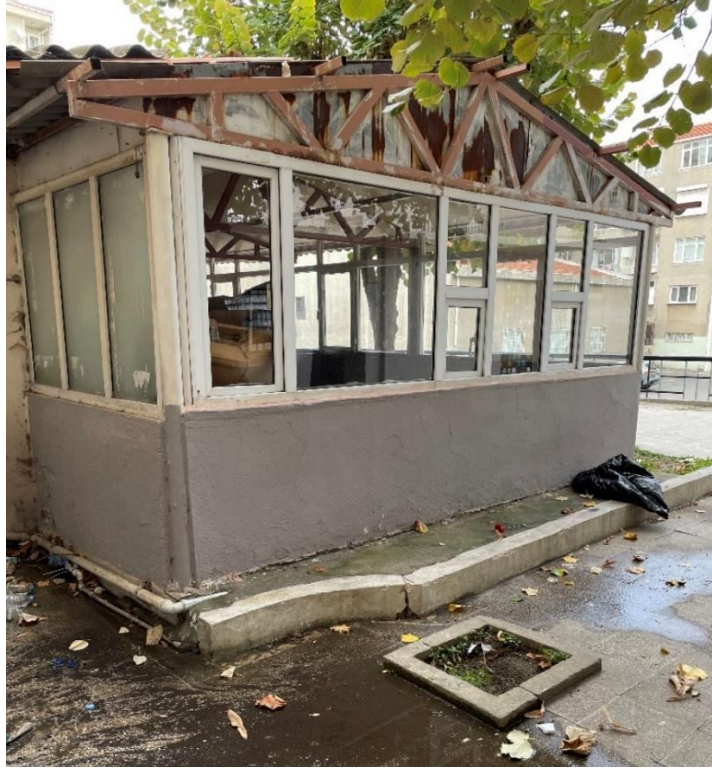
Şekil A.64: Terastaki kantin yapısı.
