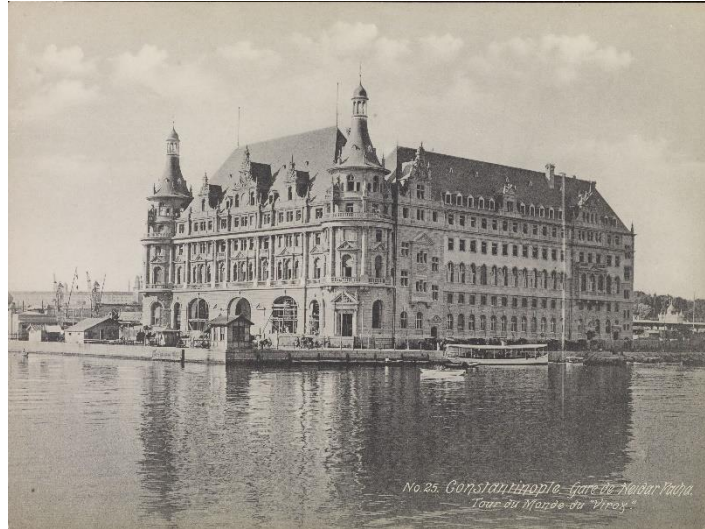
Şekil 32. Haydarpaşa Gar Binası (janusmezat.com)
