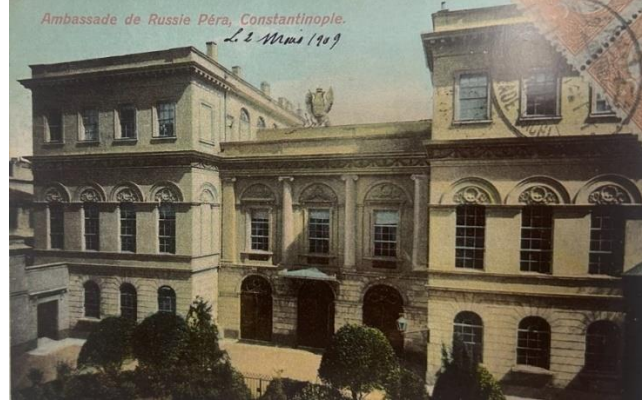
Resim 1.2.2.3 Elçilik Binası 20. yüzyılın başı (Mert Sandalcı, Max Fruchtermann Kartpostalları III. Cilt , Koçbank, İstanbul 2000, s. 940.).
