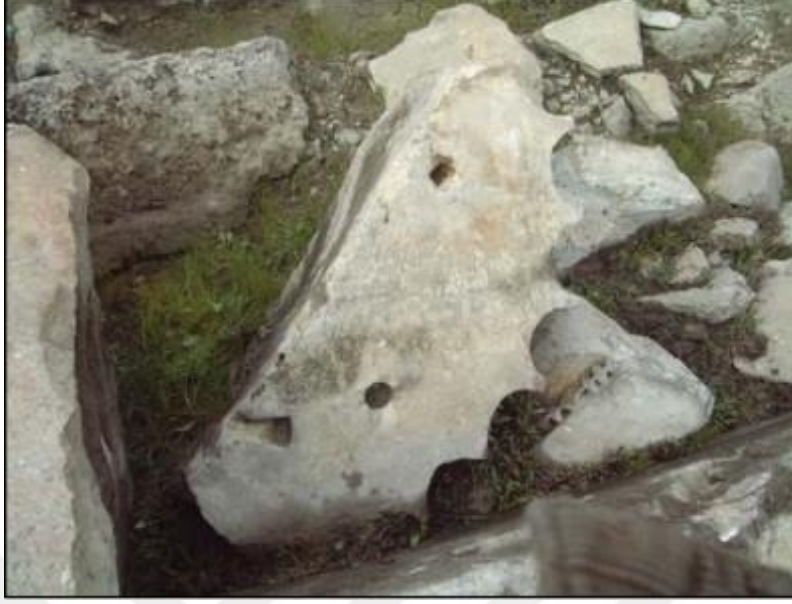
Resim 13- Magnesia Artemis Tapınağı'nda Bulunan Onarım Görmüş Bir Tambur. (Demirtaş, 2006: 55-56. Levha 33d-e.)
