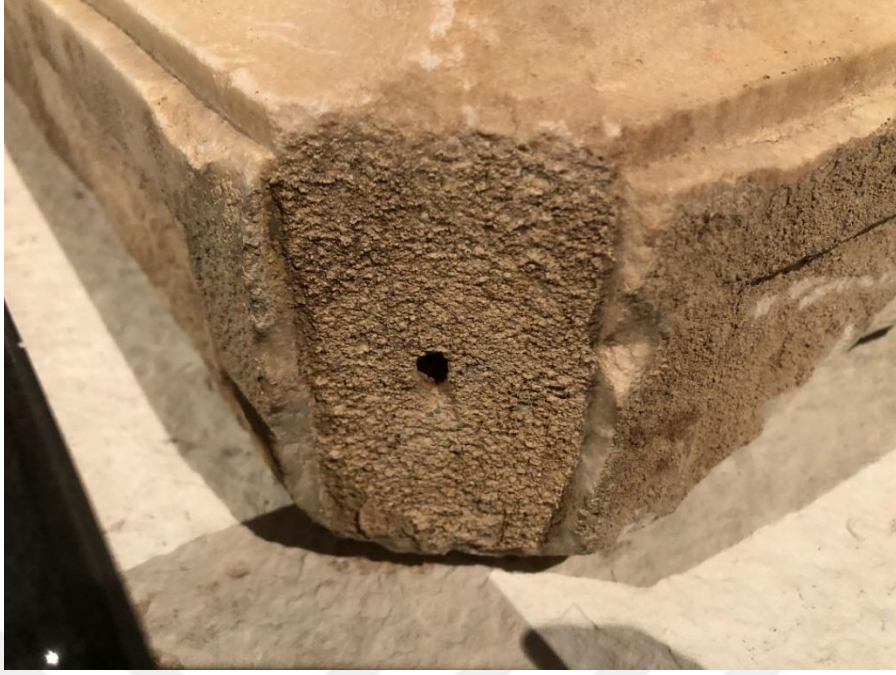
Resim 50a- Dörtgen Formlu Birleşim Yüzeyinde Yer Alan Zıvana Yuvası (Kat. No: 22).
