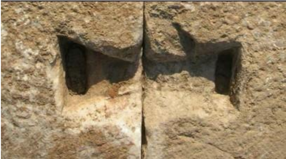
Resim 12- Kırılanc Kuyruđu Kenet Yuvası. (Demirtaş, 2006: Levha 34b.)
