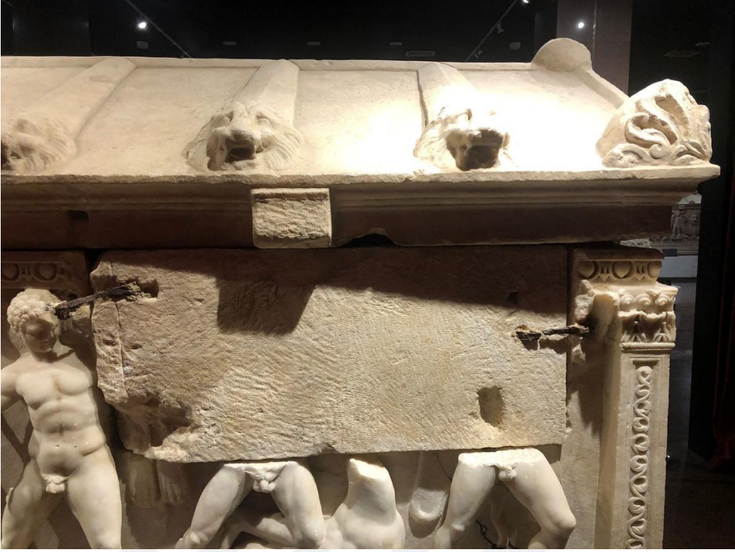
Resim 49a- Demir Kenetlerle Birleşimi Sağlanan Mermer Parça (Kat. No: 21).
