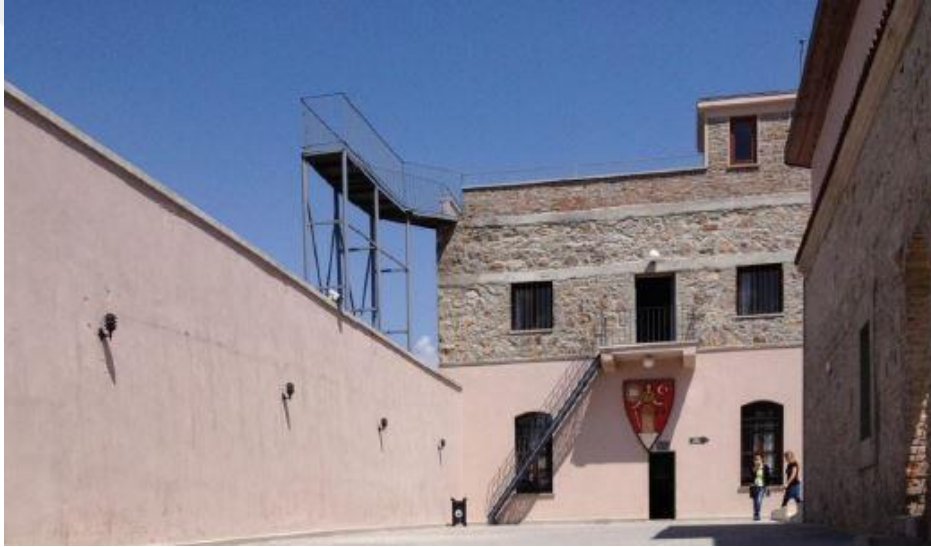
Şekil 33. Ulucanlar / Restorasyon Sonrası
