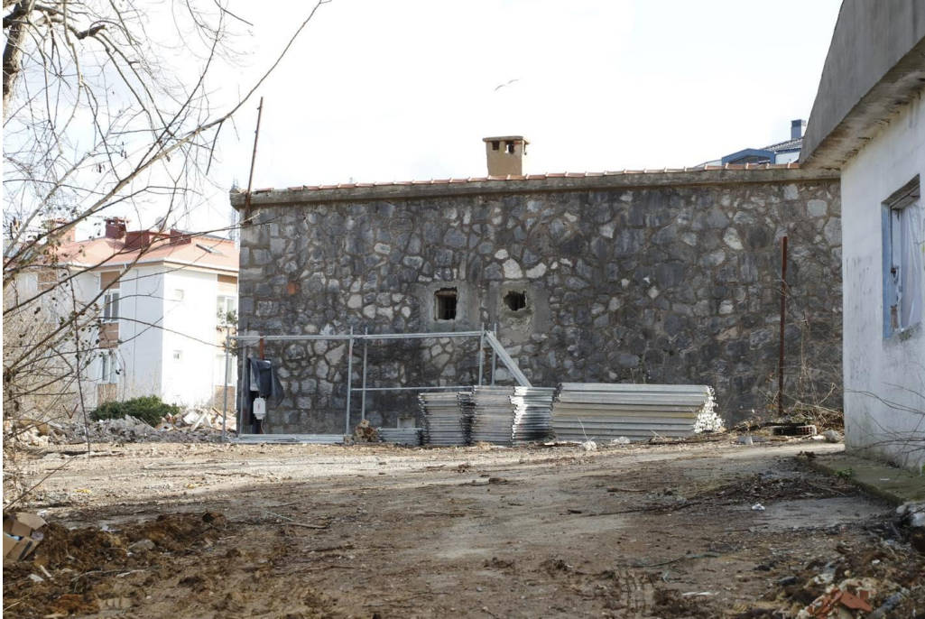
Şekil 38. Şile Cezaevi Dış Cephe Görünüş
