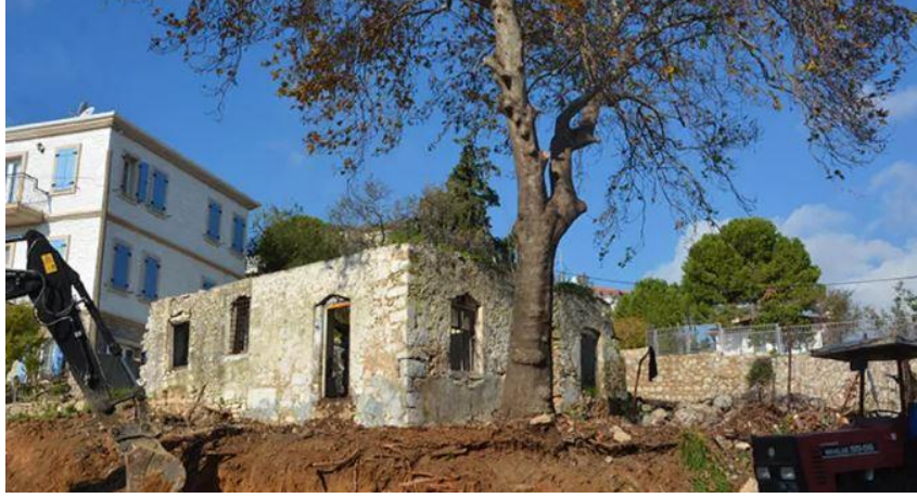
Şekil 19. Eski Datça Cezaevi Restorasyon Öncesi
