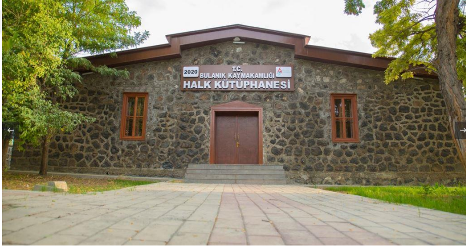
Şekil 47. Bulanık Cezaevi Ön Cephe Restorasyon Sonrası
