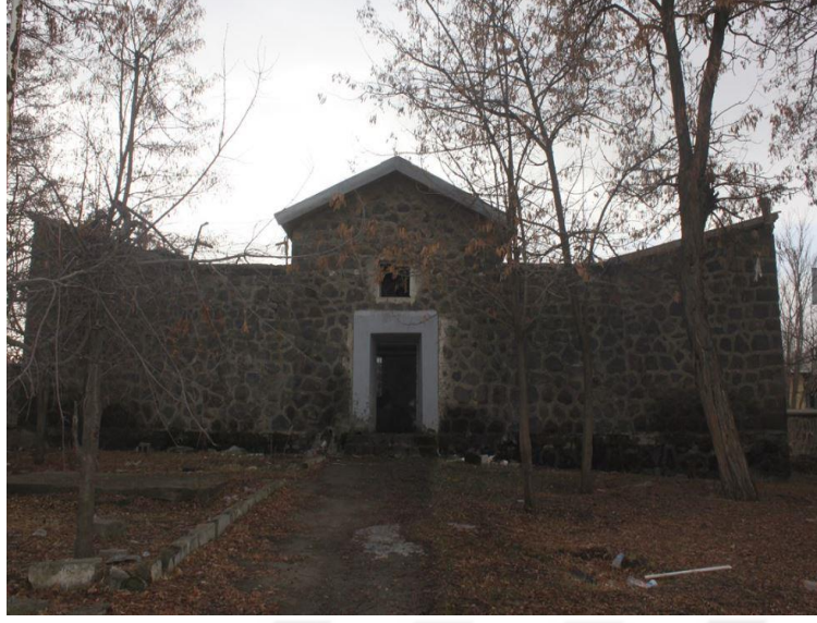
Şekil 46. Bulanık Cezaevi Ön Cephe Restorasyon Öncesi
