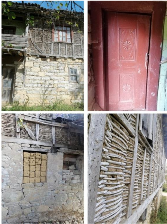
Şekil 4.16 Kocaeli, İzmit Çağırğan kirsal mahallesinde çubuk örgü sistemine ilişkin detaylar (Balcı, 2022)
