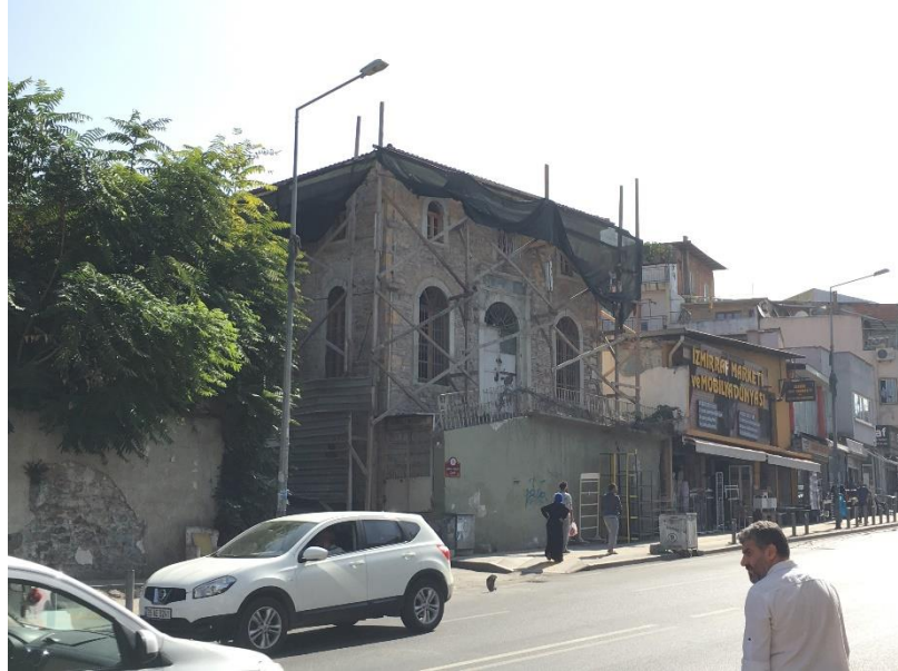
Fotoğraf 17: Asmalı Mescit restorasyon sırası genel görünüm.
