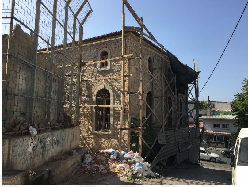
Fotoğraf 18: Asmalı Mescit restorasyon sırası genel görünüm.
