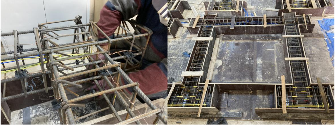
Şekil 3.3 : Donatı kafesinin oluşturulması.
