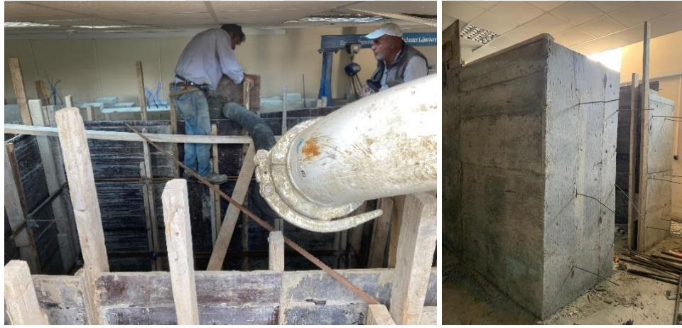
Şekil 3.21 : Betonarme paslandırma havuzu beton dökümü.
