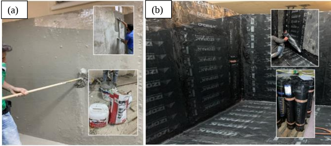
Şekil 3.22 : Betonarme paslandırma havuzu yalıtım işleri a) Çift bileşenli izolasyon uygulaması, b) membran uygulanması
