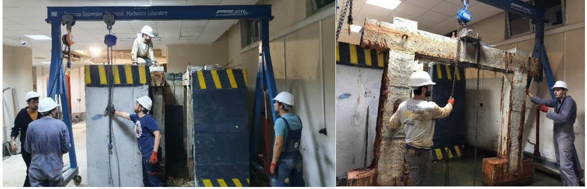
Şekil 4.1 : Betonarme çerçevelerin taşınması.
