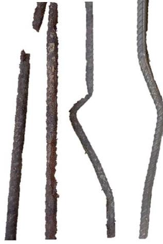
Şekil 1.14 : Donatılarda burkulma ve kopma durumu.
