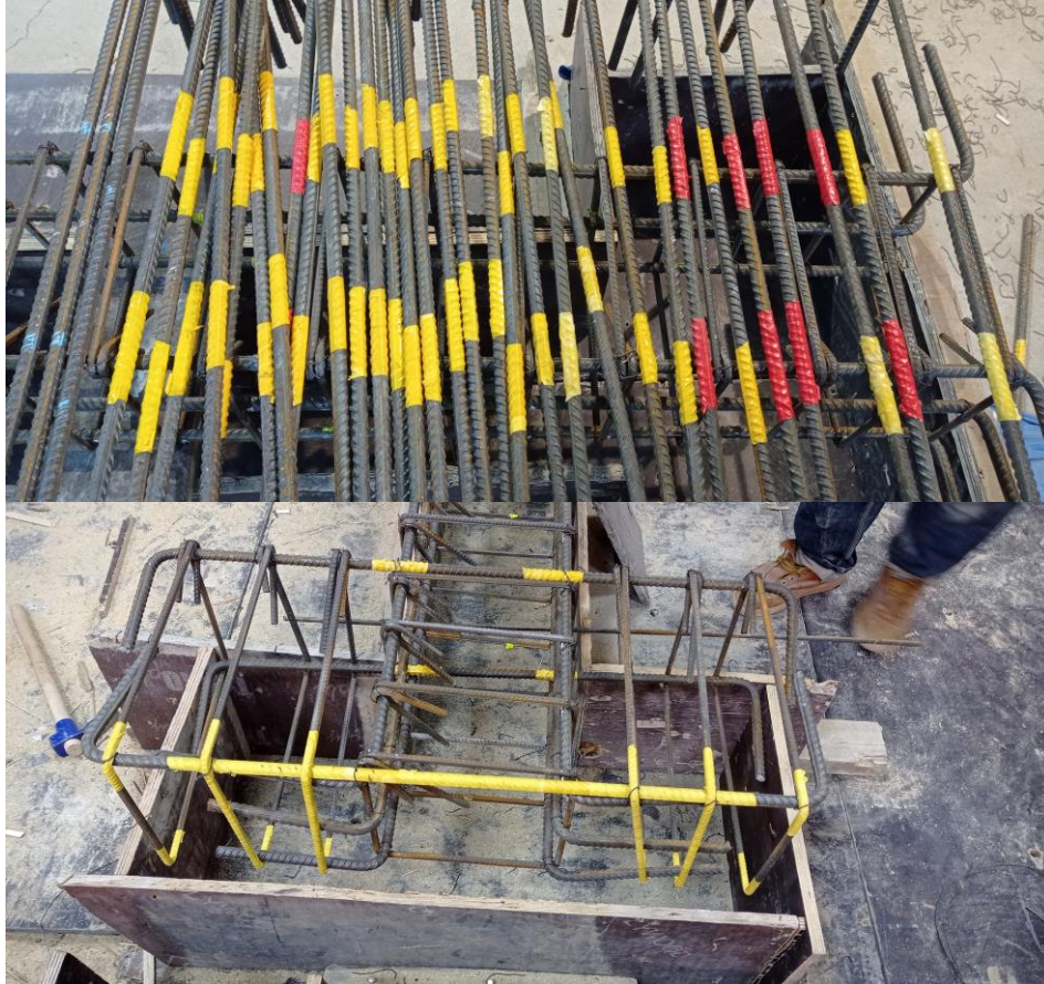
Şekil 3.4 : Temel donatılarının yalıtım işlemi.
