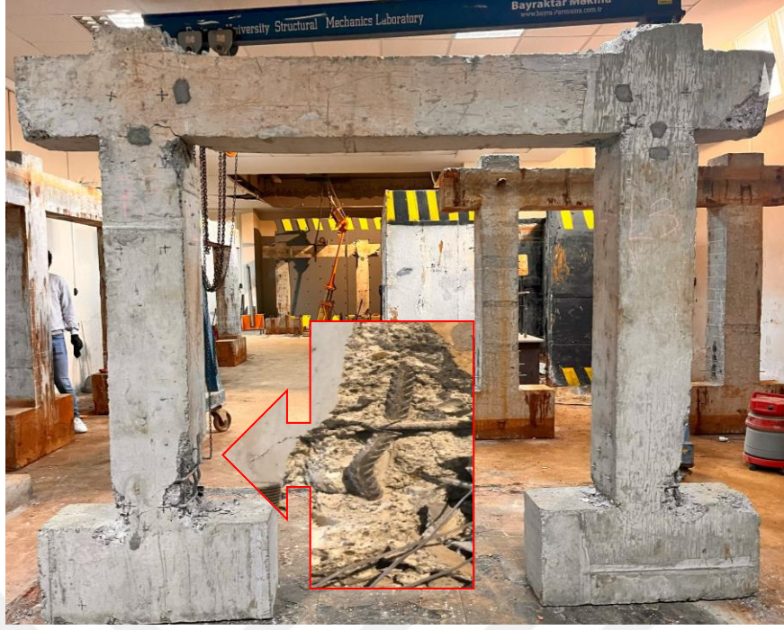
Şekil 4.33 : RCF R çerçevesi hasar durumu.
