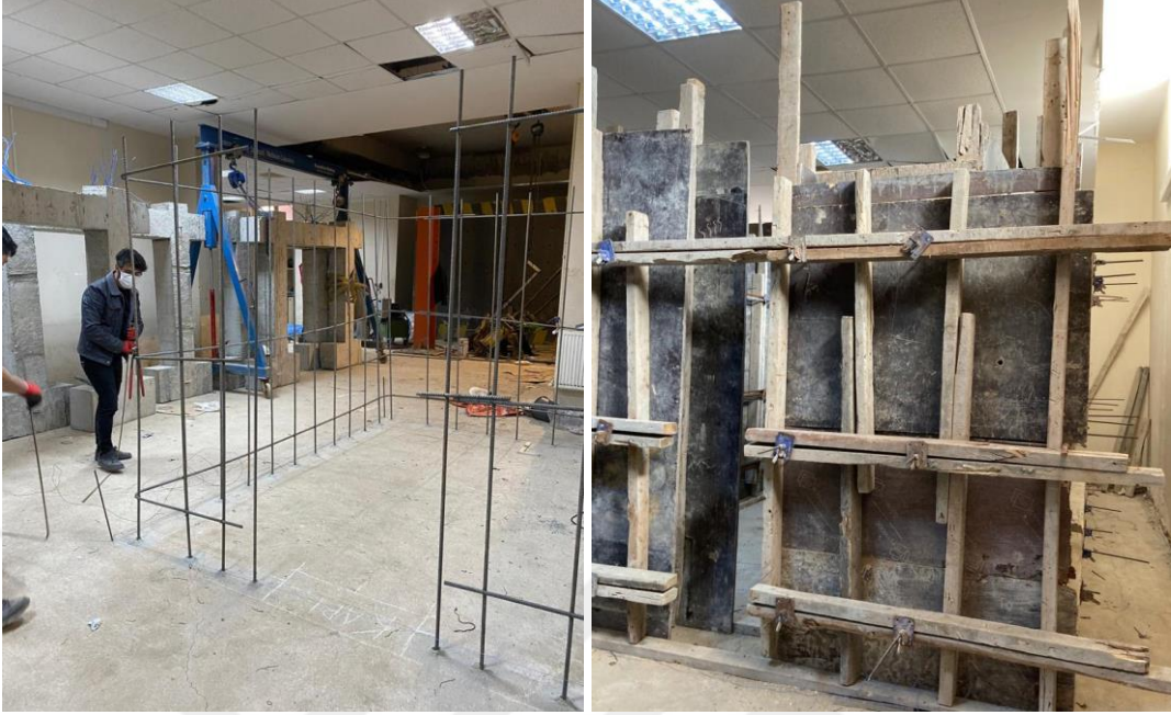
Şekil 3.20 : Betonarme paslandırma havuzu demir ve kalıp işleri.
