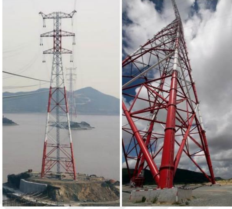
Şekil 2.4 Zhoushan elektrik iletim kulesi [60]
