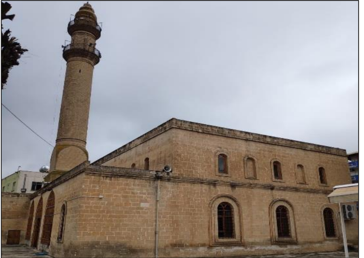
Fotoğraf 3.6. Cevat Paşa Camii, Eski Midyat Kesiminde Çarşının Tam Ortasında Bulunur.
