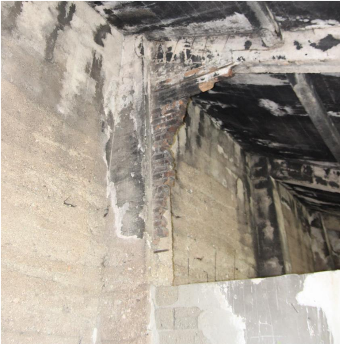
Şekil D.56: Ana sahnın güneydoğu duvarında katılaşmış tuz kalıntıları.
