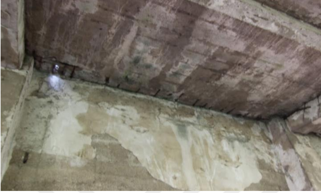
Şekil D.47: Kırma çatıda donatı yerleşimi.
