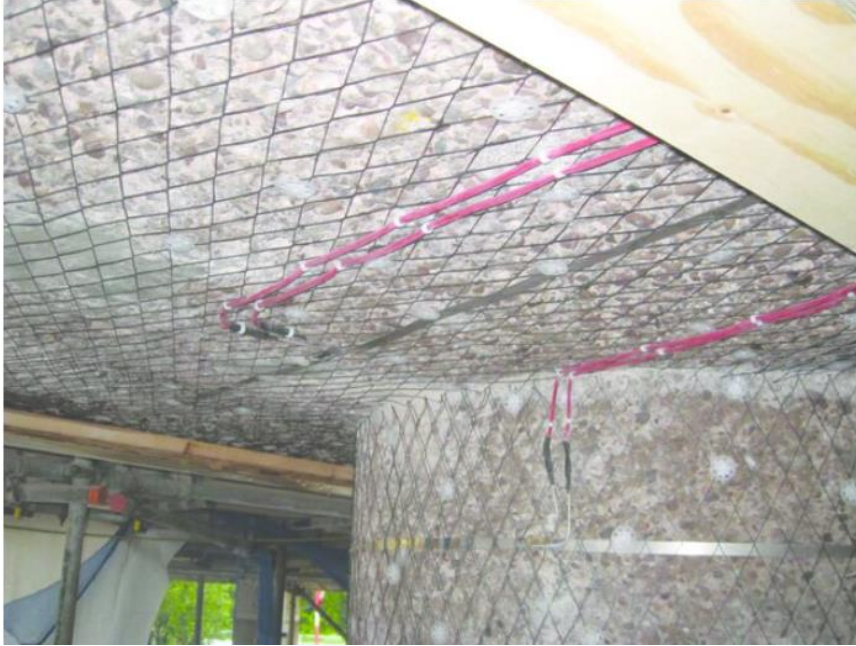
Şekil 6.8 Sıva öncesi anot ağının beton yüzeyine yerleştirilmesi (Christodoulou vd., 2013).
