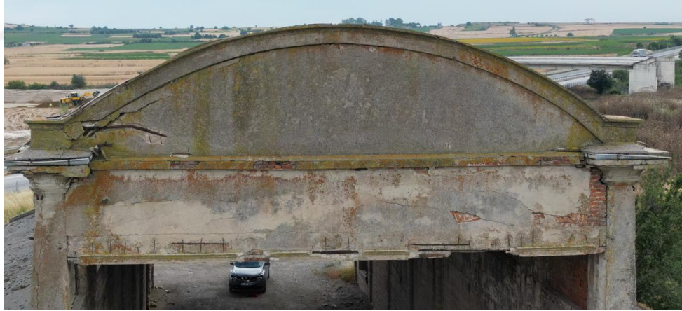
Şekil D.29: Kuzeydoğu Cephesi.
