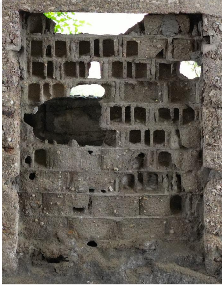
Şekil D.55: Ana sahnin güneydoğu duvarında kapatılan kapı açıklığı.
