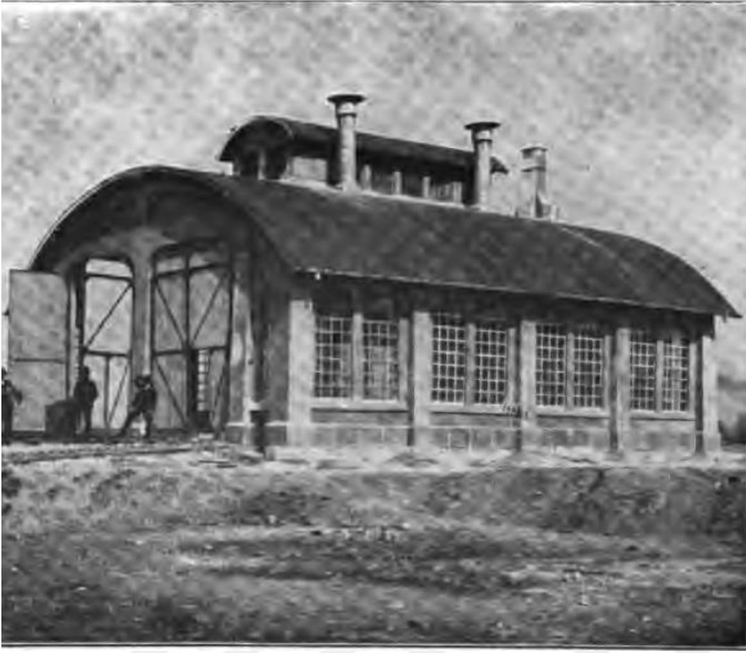
Şekil 4.3: Almanya'nın Krefeld kentinde bulunan lokomotif garajı (Mörsch, 1902, s. 231).
