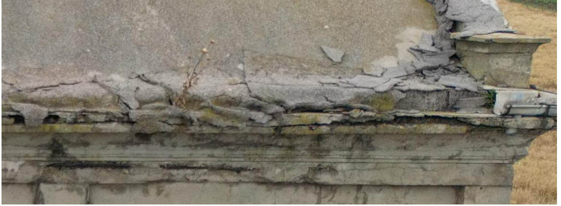
Şekil D.50: Tonoz saçığında malzeme kaybı.
