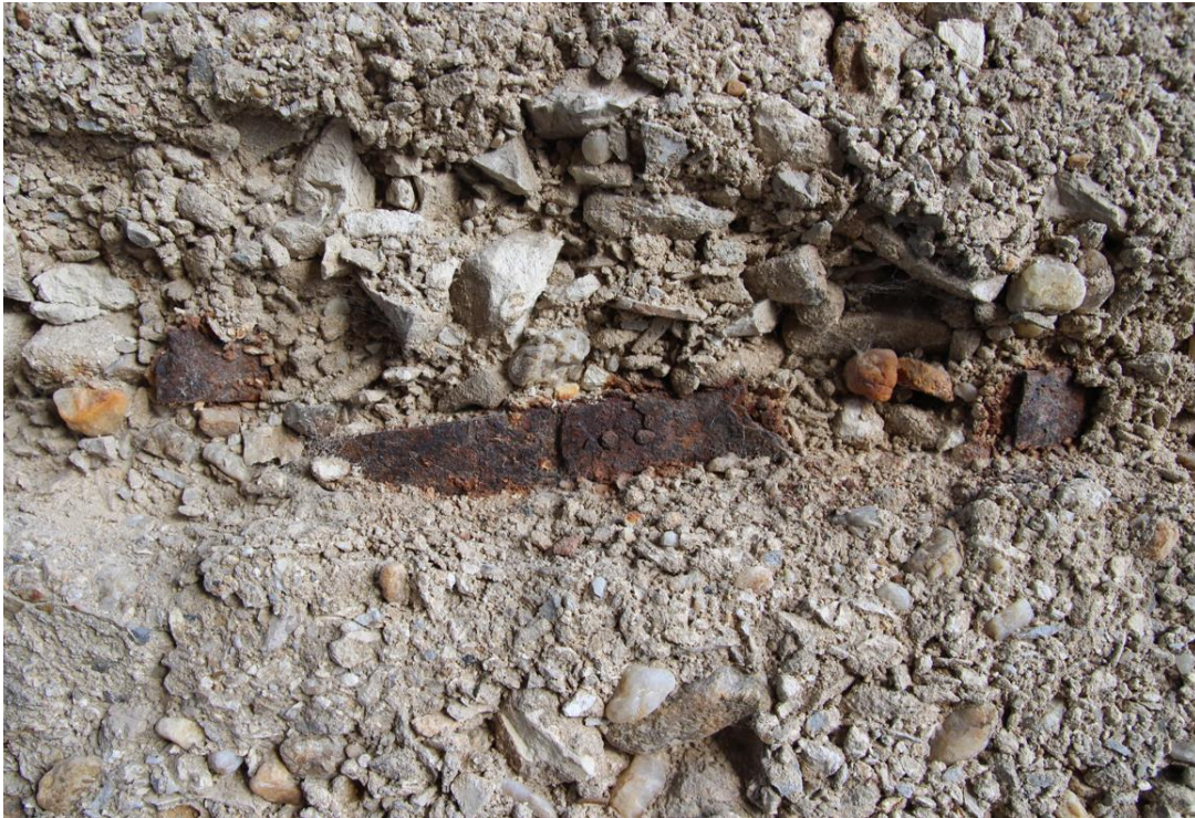
Şekil D.37: Lama benzeri enine şerit donatı.
