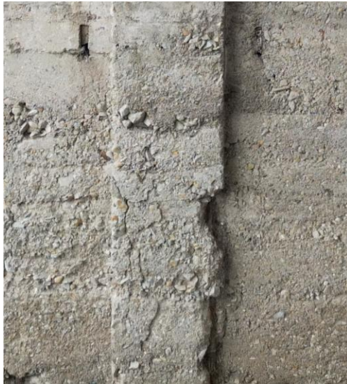
Şekil 3.29 Ana sahında yüzey erozyonu
