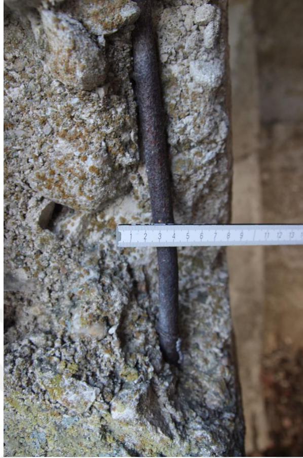
Şekil D.36: Betonarme duvarlarda kullanılan boyuna donatı.
