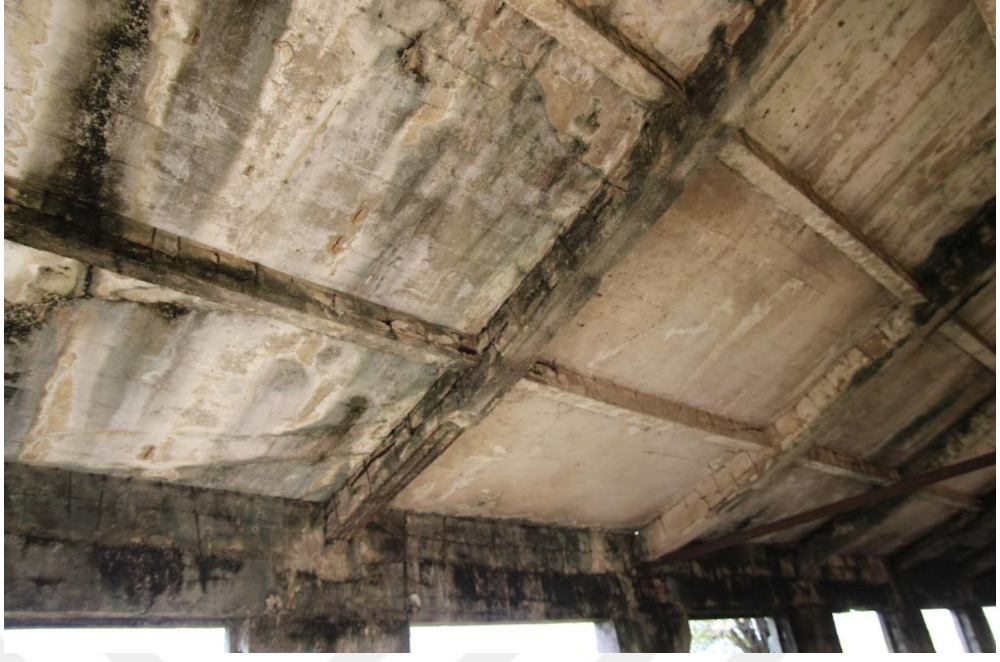
Şekil D.41: Kuzey sahında bulunan birincil ve ikincil kirişler.
