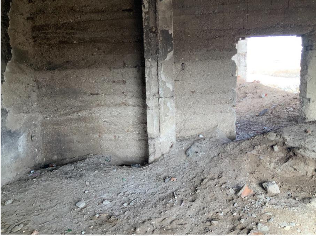
Şekil D.21: Güney Sahın Z03.E Mekanı.
