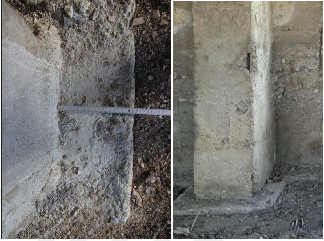
Şekil D.34: Kuzey sahında görülebilen temel ampatmanı.
