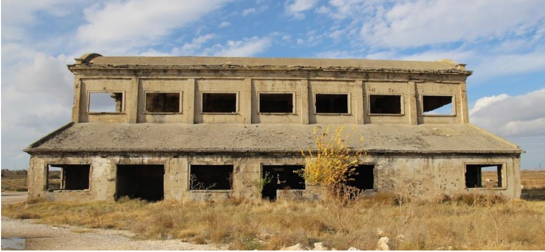
Şekil D.25: Güneydoğu Cephesi (Aralık 2022).
