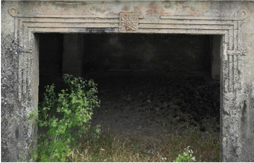
Şekil D.32: Kuzeybatı Cephesi Kapı Bezemeleri .
