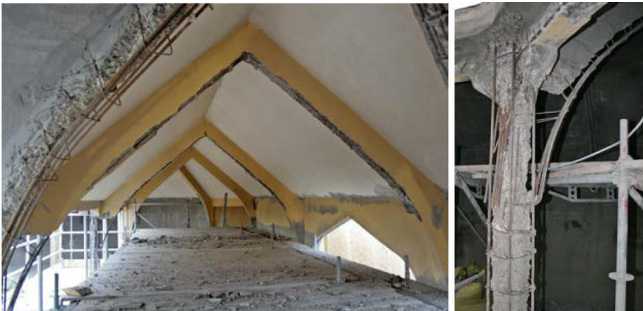
Şekil 6.6 Betonarme üzerinde geniş ölçekte su jeti uygulamaları (Heinemann, 2013, s. 350)
