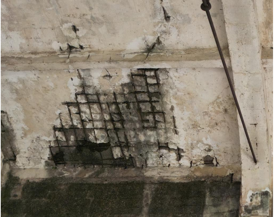
Şekil D.46: Basık tonozun donatı yerleşimi.
