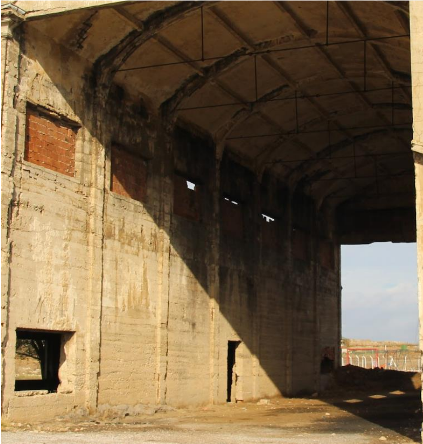
Şekil D.2: Z01 Ana Sahın Kuzeybatı Duvarı.
