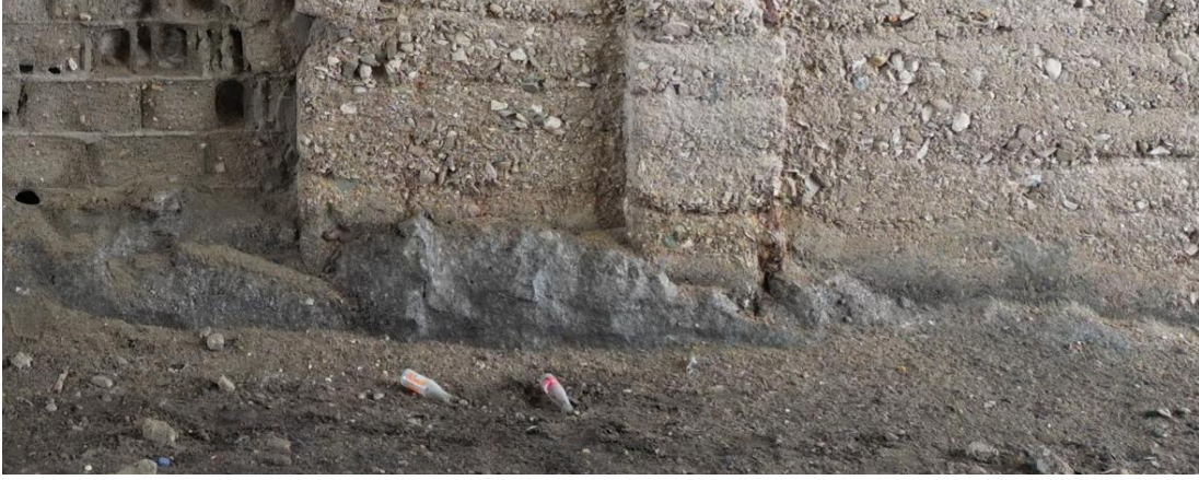
Şekil D.56: Ana sahnın güneydoğu duvarında katılaşmış tuz kalıntıları.
