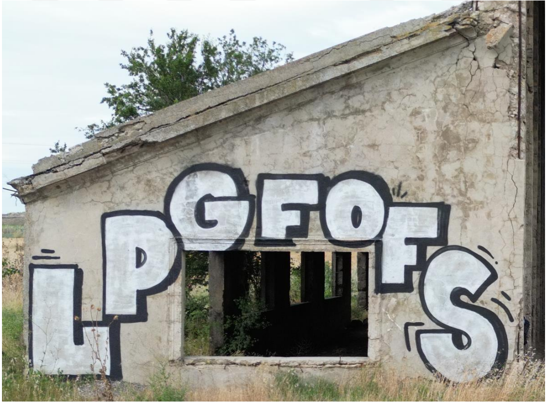
Şekil D.24: Güneybatı Cephesi.
