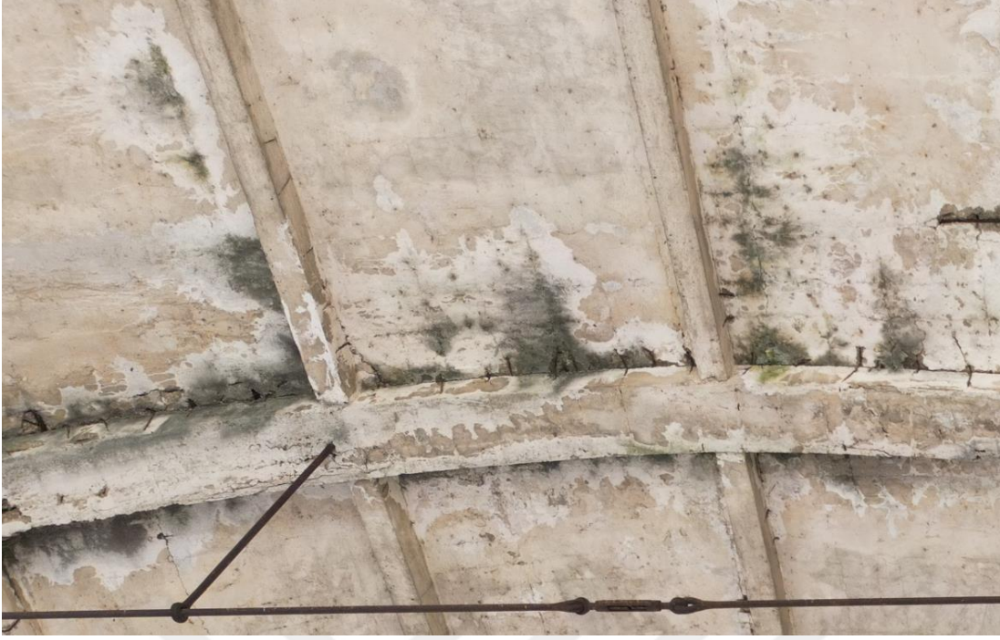
Şekil D.52: Tonoz iç yüzeyinde neme bağlı renk değişimi.
