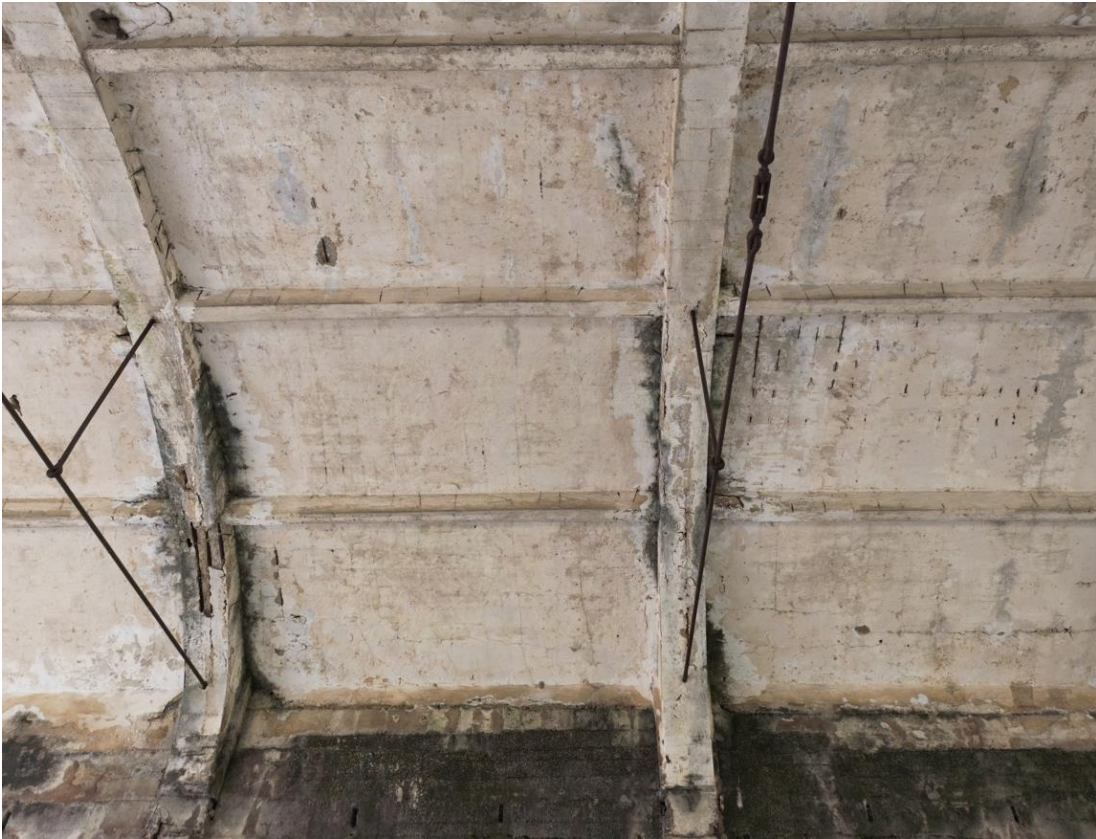
Şekil D.44: Ana sahında bulunan betonarme kemer ve kirişler.
