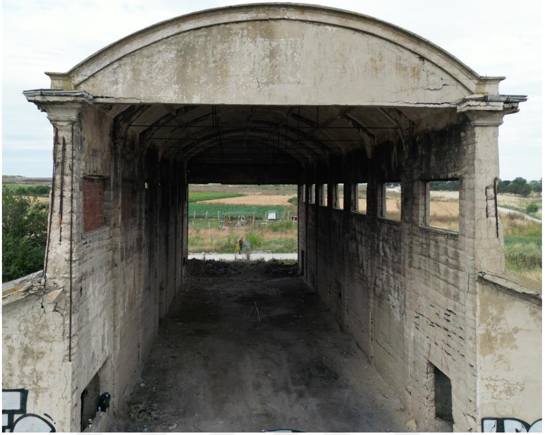
Şekil D.23: Güneybatı Cephesi .
