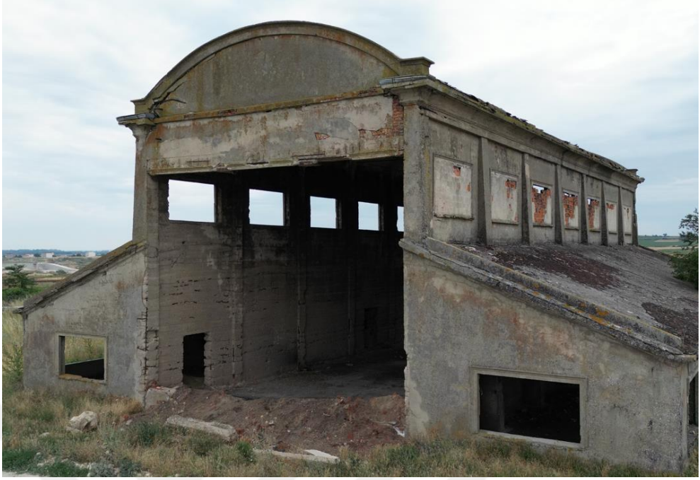
Şekil D.28: Kuzeydoğu Cephesi.
