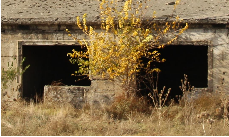
Şekil D.26: Güneydoğu Cephesinde Müdahale Edilen Pencere Açıklıkları.
