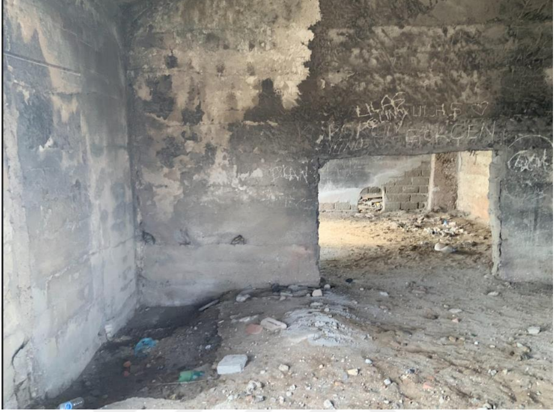
Şekil D.19: Güney Sahın Z03.E Mekanı.
