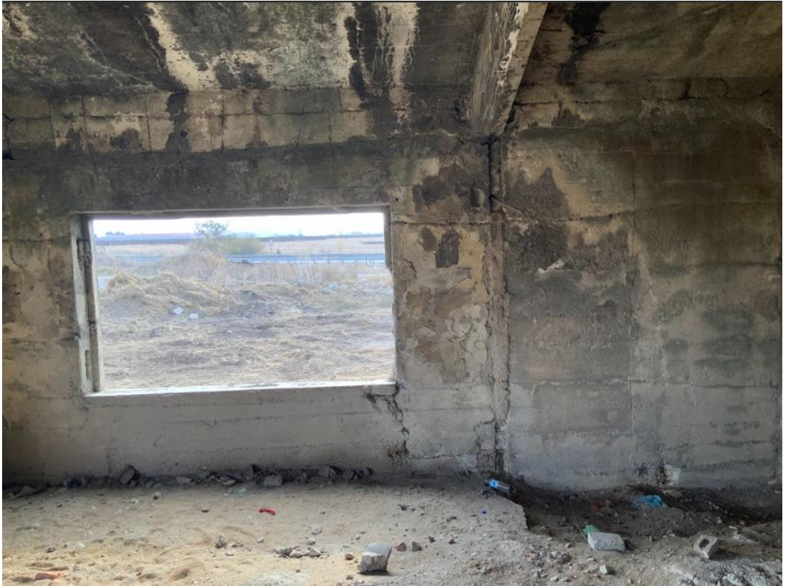
Şekil D.20: Güney Sahın Z03.E Mekanı.
