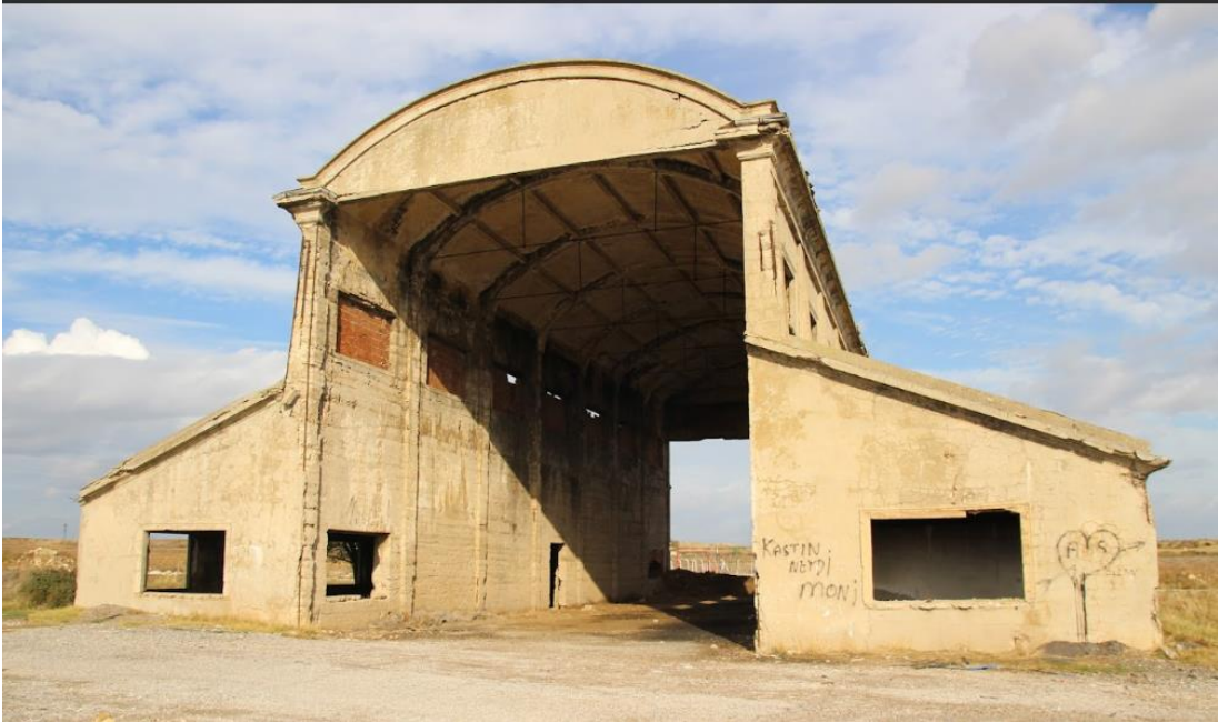
Şekil D.22: Güneybatı Cephesi (Aralık 2022).
