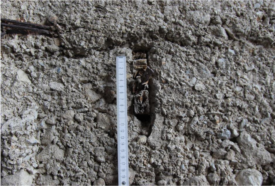
Şekil D.40: Kalıp bağlantısı için kullanılan ahşap elemanlar.
