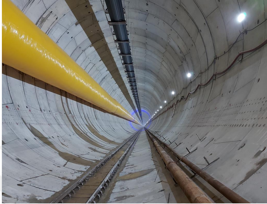
Şekil 2.4 : TBM ile açılan tünel örneği.
