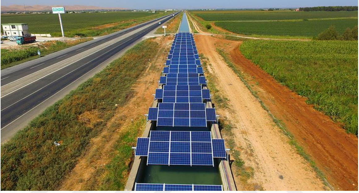
Şekil 3.20. Kanal üstü fotovoltaik sistem örneği[47].
