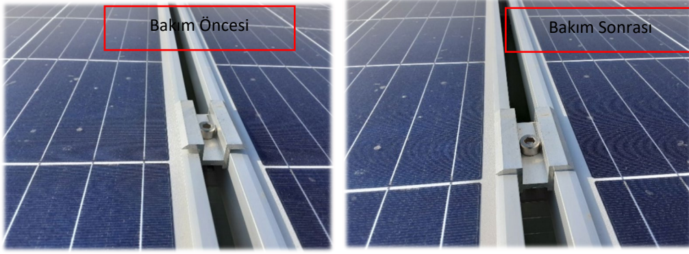
Şekil 7.18. Panel Tutucu Arızası
