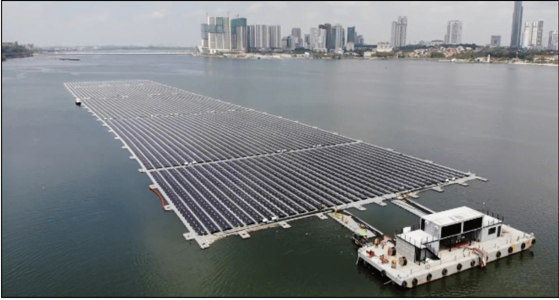
Şekil 3.22. Yüzer fotovoltaik sistem örneği[49].
