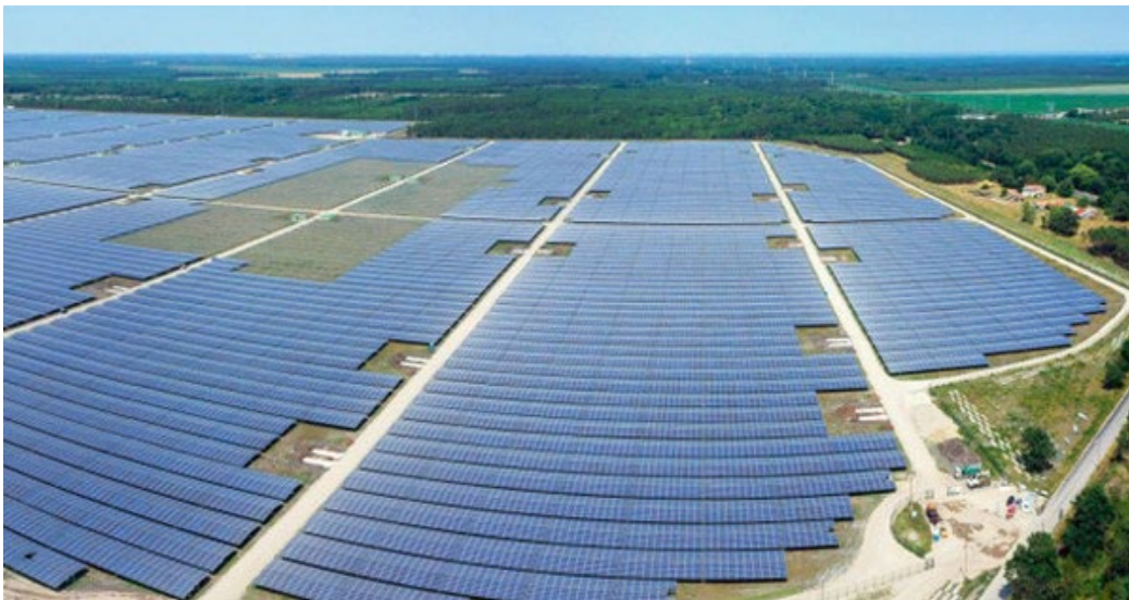
Şekil 3.17. Arazi kurulumlu fotovoltaik sistem örneğı[45].
