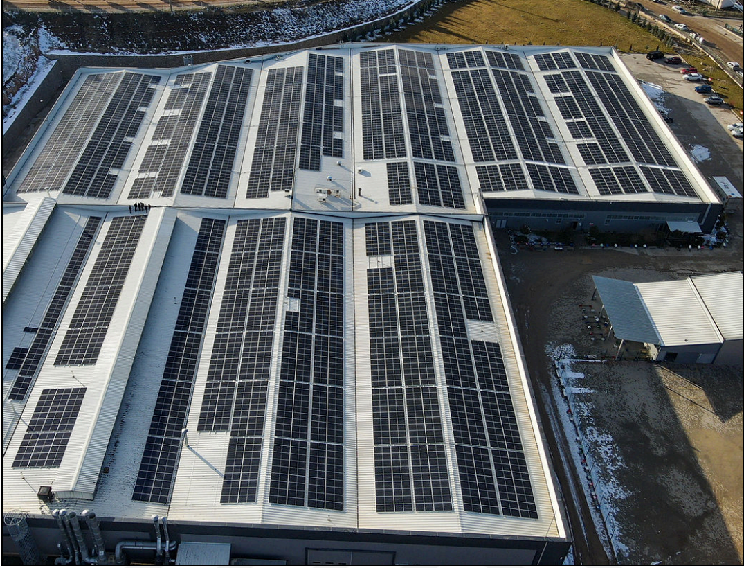
Şekil 3.19. Fabrika binaları için çatı üstü fotovoltaik sistem örneği[46].
