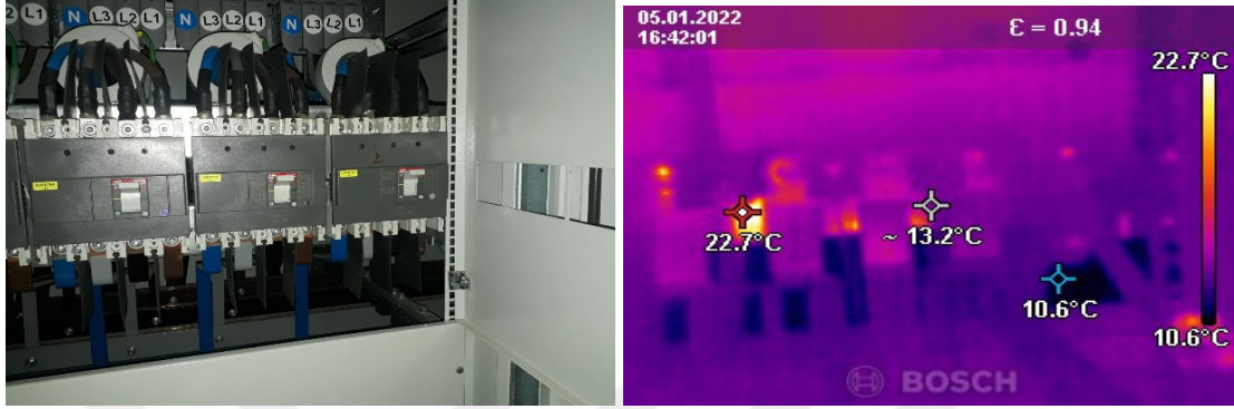
Şekil 7.20. TMS Arızası
