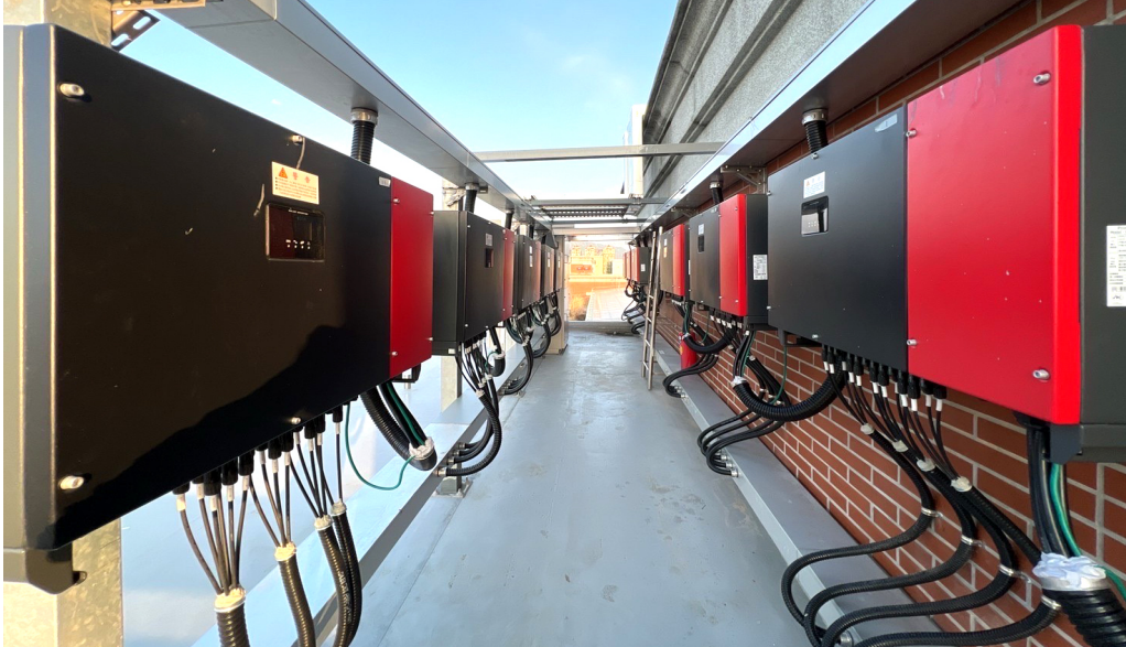
Şekil 3.6. Örnek Evirici Bağlantıları[35].
