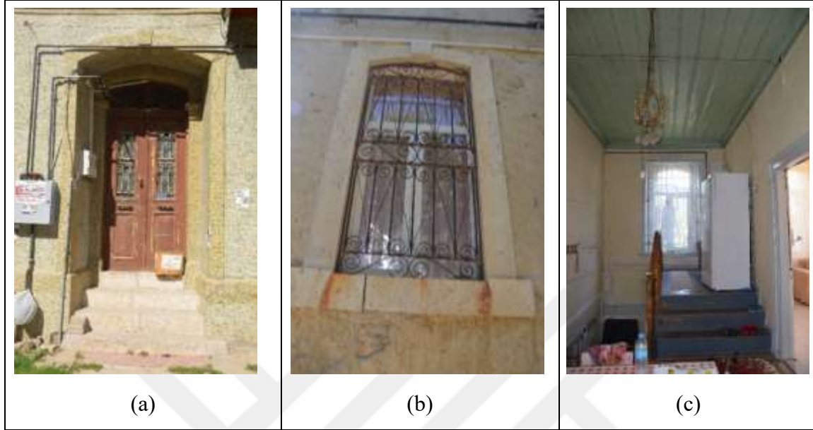
Resim 5.138. (a) Restorasyon öncesi kapı detayı (b) Pencere detayı (c) Zemin kat sofa tavan ve merdiven detayı
