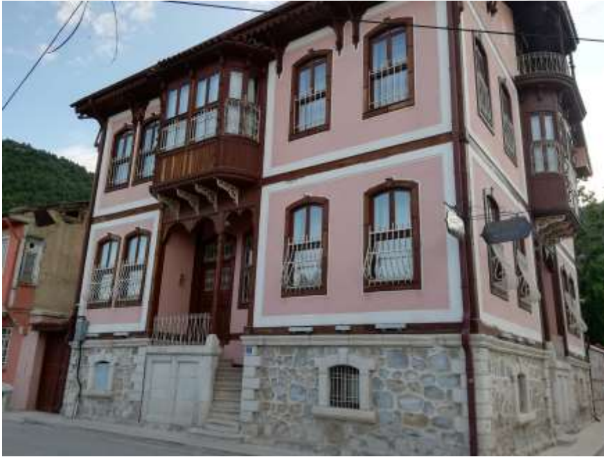
Resim 5.165. Takkasızlar Konađı dođu cephesi
