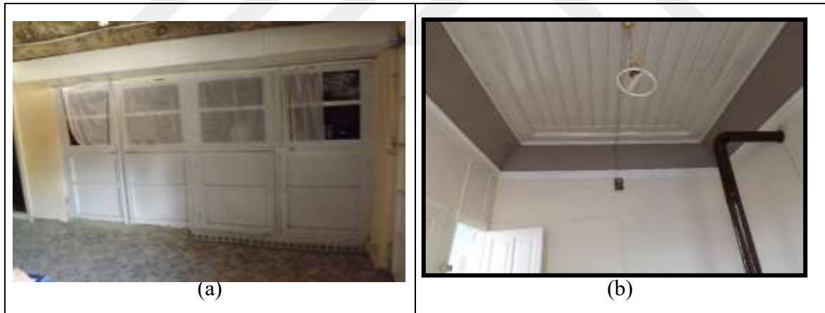
Resim 5.59. (a) Alt zemin hanay gömme dolap detayı; (b) Birinci kat tekne tavan detayı(Akşehir Belediyesi Arşivi)
