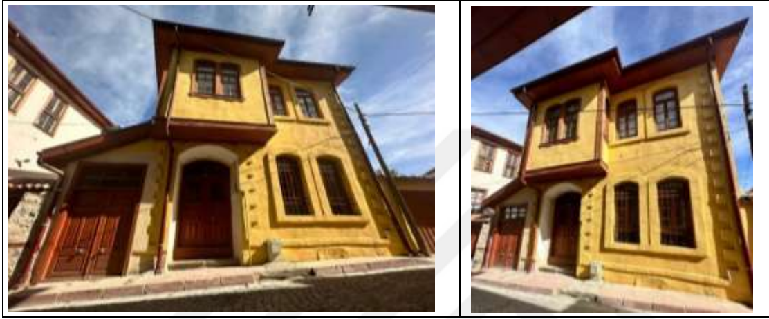
Resim 5.152. Hacı Hamza Sokak no:30 ön cephe fotoğrafları
