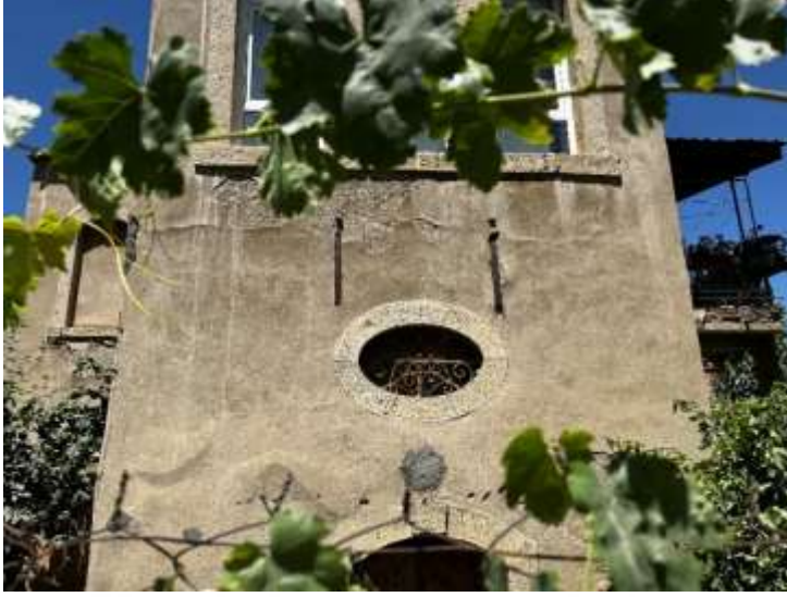
Resim 6.18. Tuncer Öz evi arka cephesi eliptik pencere
