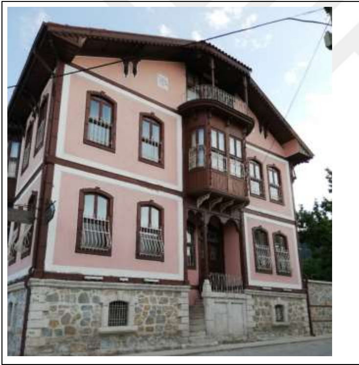
Resim 5.164. Takkasızlar Konağı kuzey cephesi
