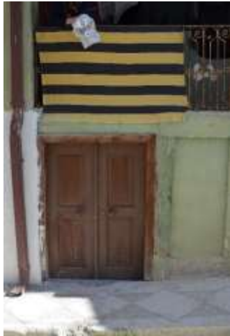
Resim 5.35. Alt Zemin kat depo giriş kapısı
