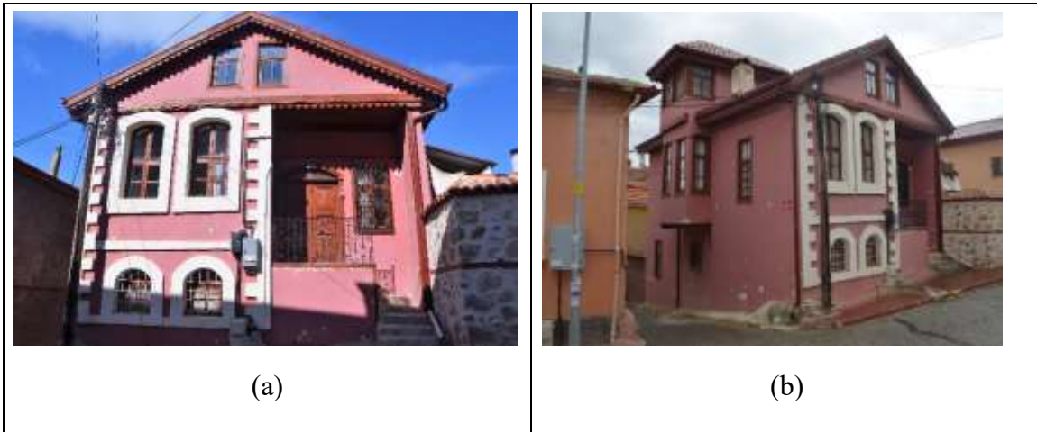
Resim 5.110. (a) İhsan Küçükafacan evi ön cephe (b) İhsan Küçükafacan evi ön cephe
