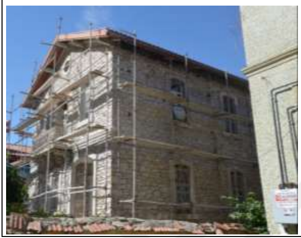
Resim 5.136. Güldane Sandıklı evi güney cephesi restorasyon sırasında çekilen fotoğrafı
