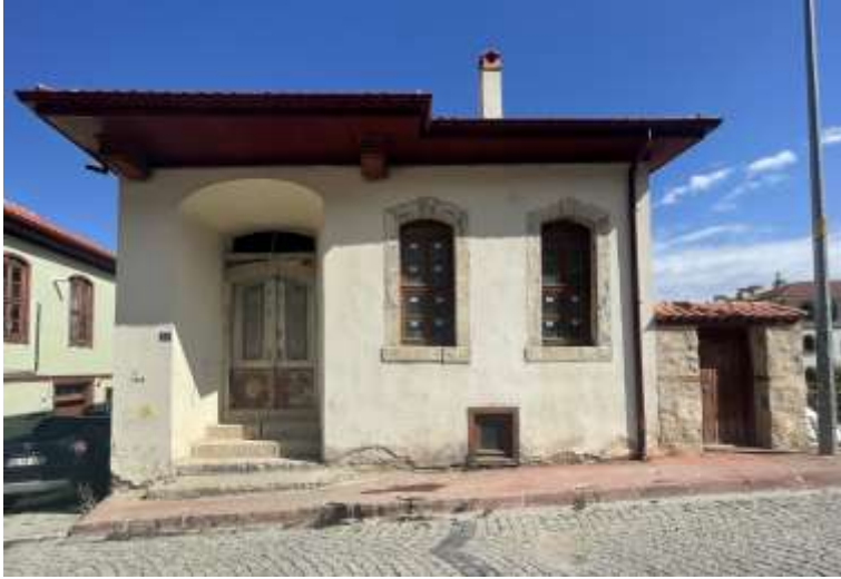
Resim 5.120. Hacı Hamza Sokak 44 numaralı yapı ön cephesi
