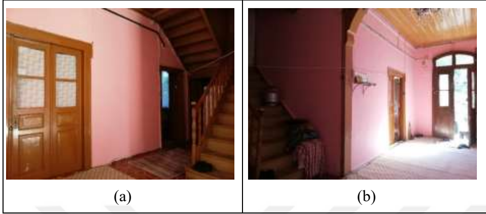
Resim 5.128. (a) Sofadan mutfak ve odaya geçiş kapıları (b) Sofanın sağında yer alan oda ve merdiven
