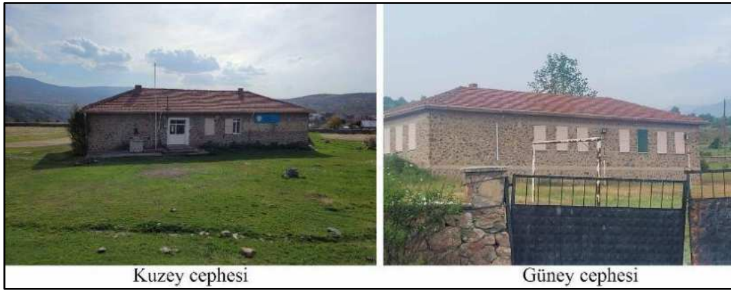
Şekil 4.6 Deveören İlköğretim Okulu binası
