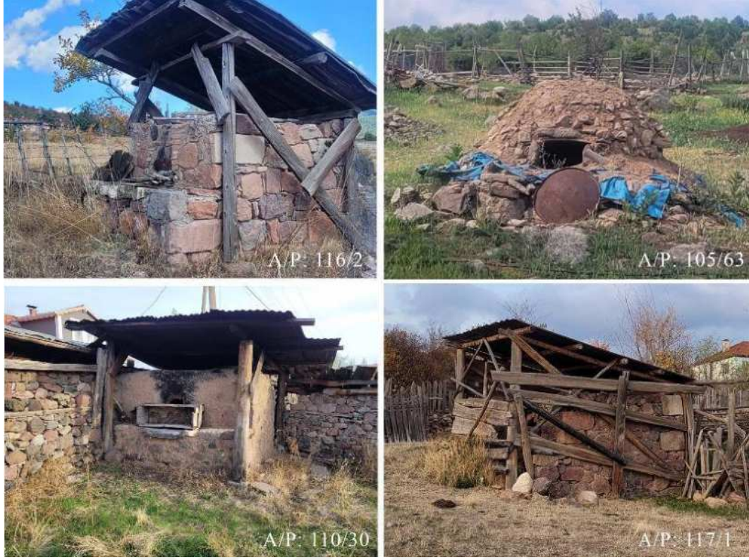
Şekil 6.28 Ortak kullanılan fırınlar ve niteliksiz üst örtüleri (2023)
