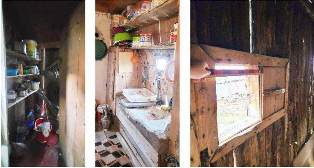
Şekil 5.16 Ayranlık(solda), ayranlık ve yanında abdestlik (ortada), kayar hela havalandırma penceresi(sağda) (2022)
