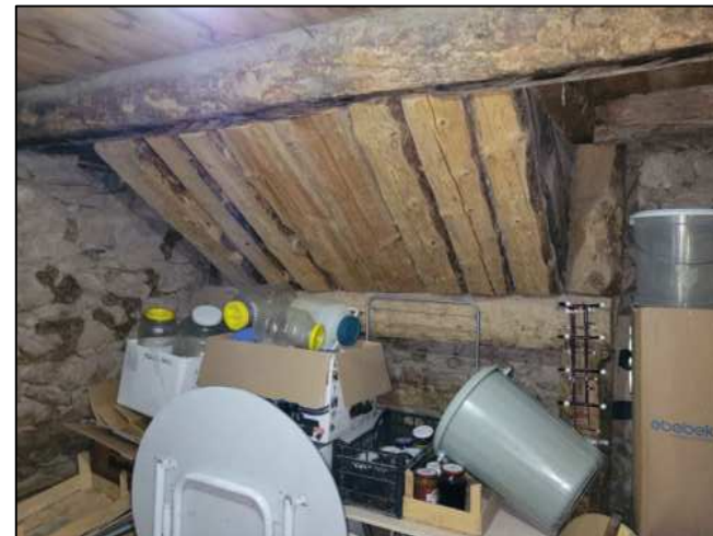
Z04 ATÖLYE/ Ocağın altındaki taşıyıcı sistem
