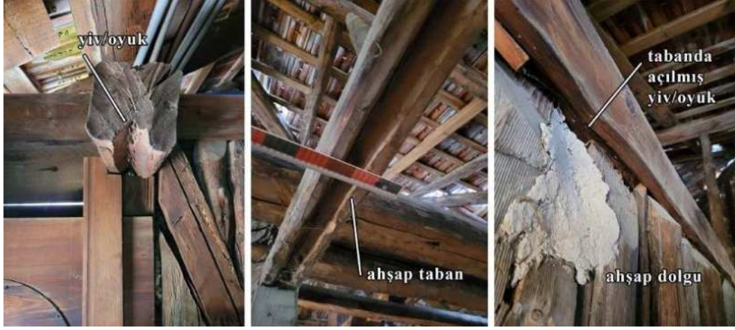
Şekil 5.58 Ahşap üst tabanda açılan yive oturmuş ahşap dolgular (dizemeler) (2023)
