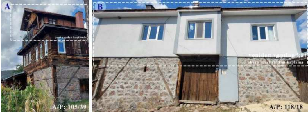
Şekil 6.6 Solda Ada 105, parsel 39 ve sağda ada 118, parsel 18’de bulunan üst katları yapı malzemesi olarak sökülmüş, taşınmış ve yeni malzemelerle tamamlanmış konutlar (2022)
