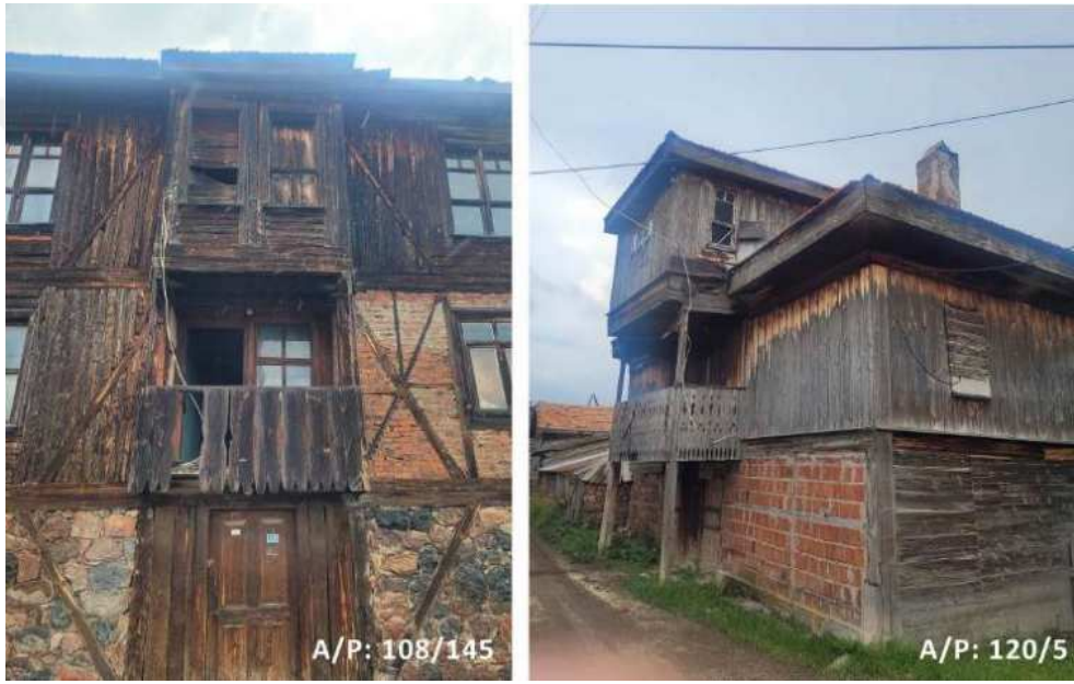
Şekil 5.51 Balkon çıkması ve kapalı çıkması olan konutlar (2022)
