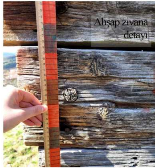
Şekil 5.19 Deveören Köyü'ndeki ahşap yığma (kurtboğaz ve karaboğaz tekniğiyle yapılmış) ambar yapıları ve detayları (2022)
