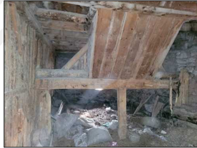
ocağın altındaki taşıyıcı sistem Z03 AHIR
