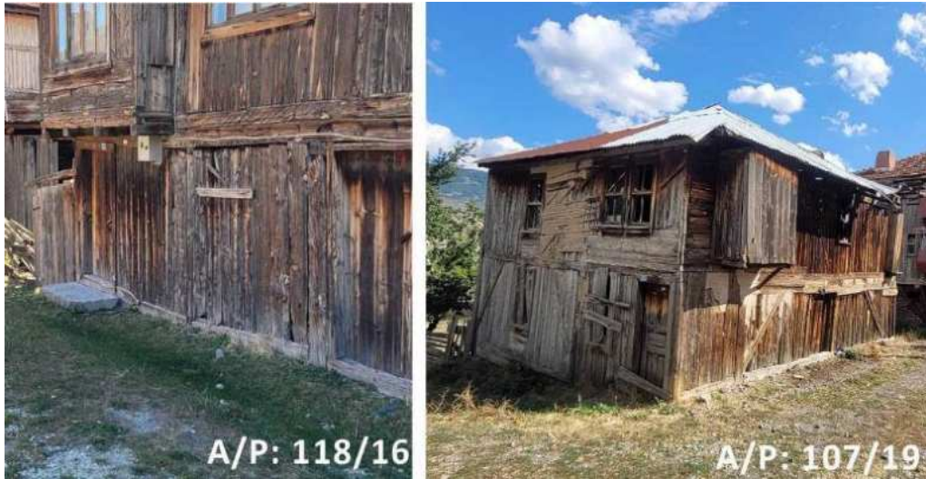
Şekil 5.55 Ahşap tabanların doğrudan toprak zemine yerleştirildiği konutlar (2022)
