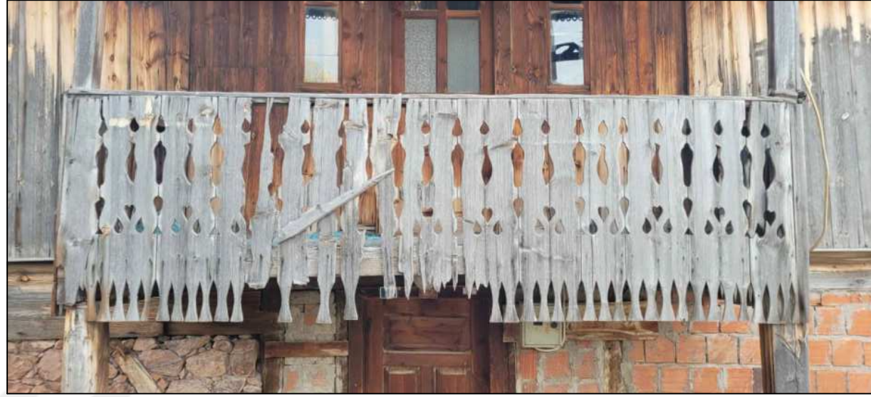
KUZEYDOĞU CEPHESİ BALKON KORKULUĞU
