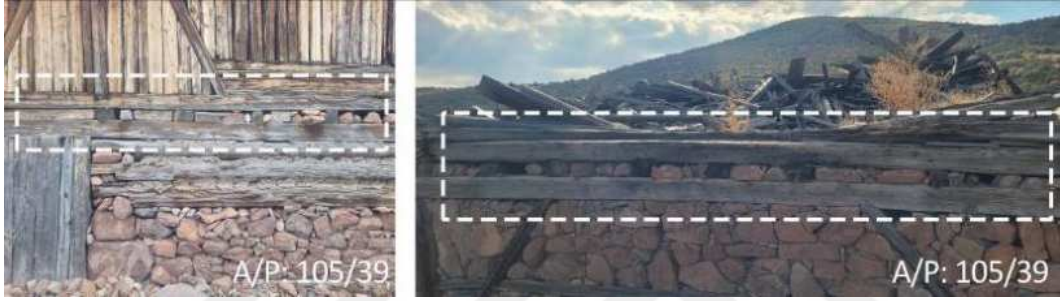
Şekil 5.62 Çift tabanlı döşemelerde kirişler arası dolgu malzemesi olarak ahşap veya moloz taş kullanımı (2022)
