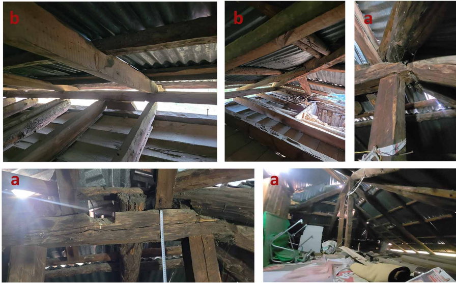
Şekil 5.65 Deveören Köyü'ndeki konutların çatılarındaki ahşap taşıyıcı sistem (2023)
