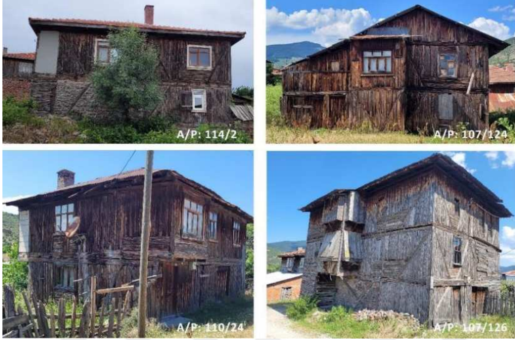
Şekil 5.52 Ahşap dizemeli konutlar (2023)
