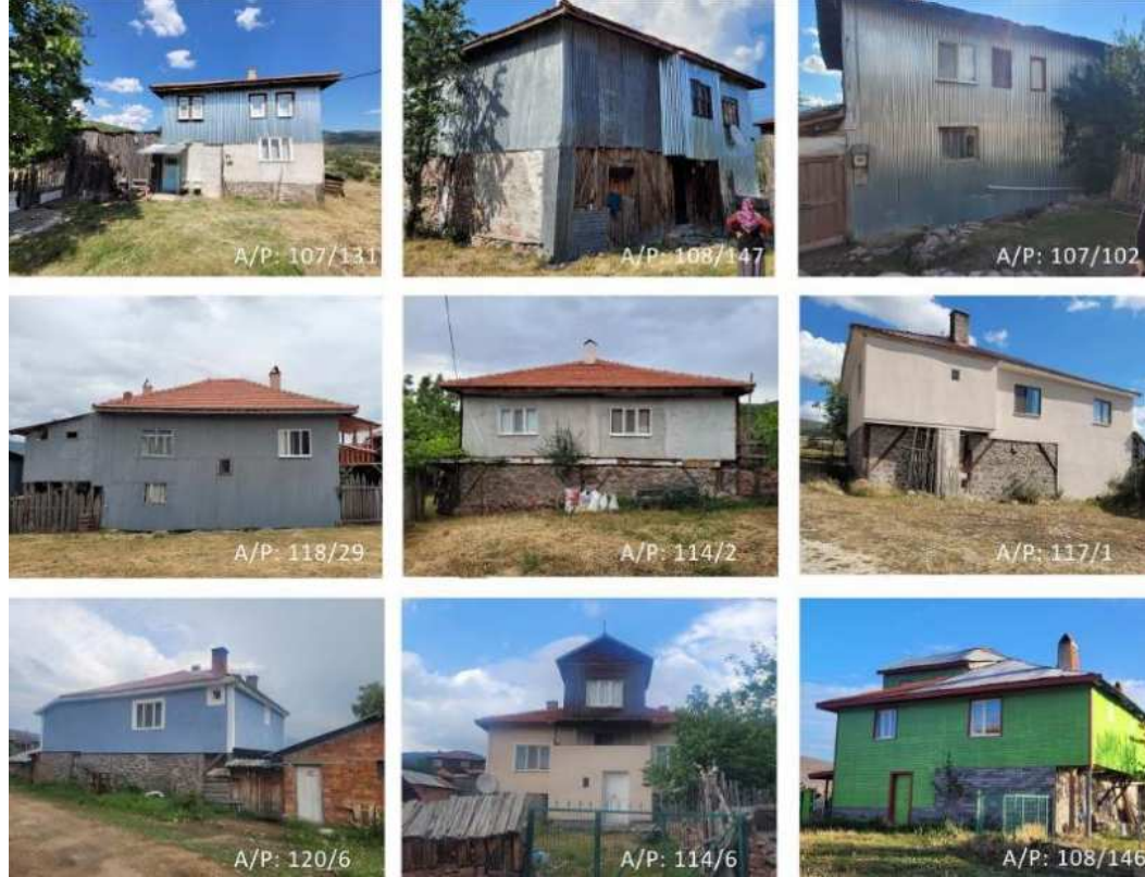
Şekil 6.16 Cephelerde metal ya da EPS kaplama üzeri sıva boya uygulamaları (2023)
