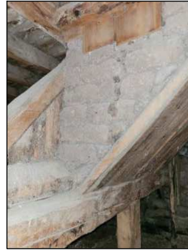
ocağın altındaki taşıyıcı sistem Z03 AHIR
