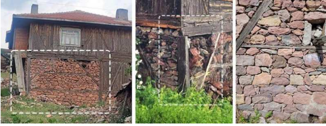
Şekil 6.10 Zemin katta yığma taş, harçsız kuru duvar örgüleri veya harçları dökülmüş örnekler (2023)
