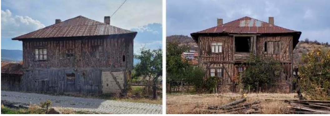
Şekil 6.24 Ada 116, parsel 1’deki terk edilmiş taş dolgulu ve dizemeli konut (2023)
