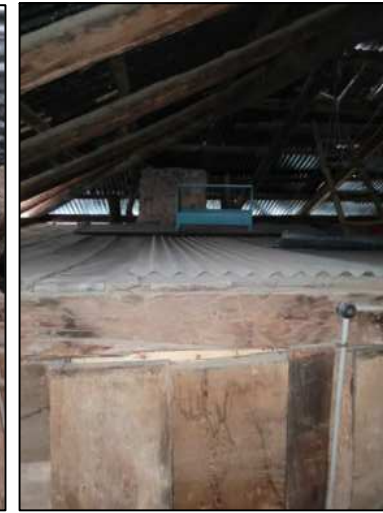
Çatının içten görünüşü ve 101 no'lu odanın tavan döşemesi 102 SOFA/HAYAT
