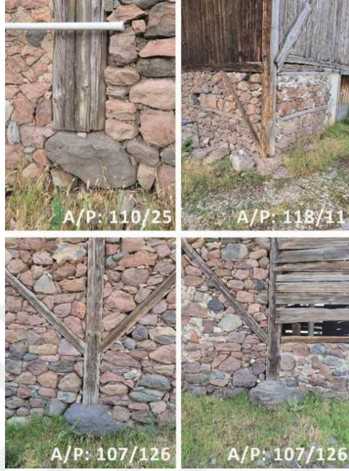
Şekil 5.56 Taş kaidelere oturan ahşap dikmeler (2023)
