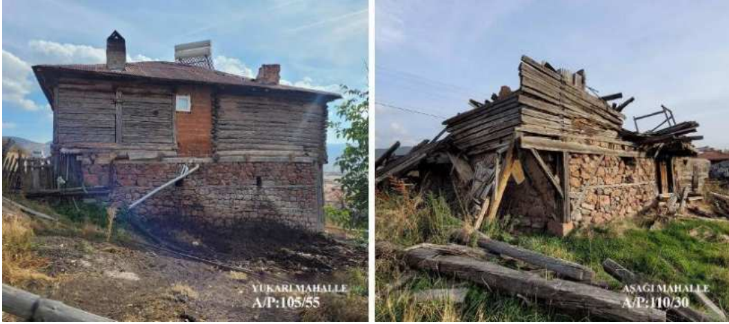
Şekil 5.60 Konutların yaşam katlarında yığma ahşap sistemli duvarlar (2023)
