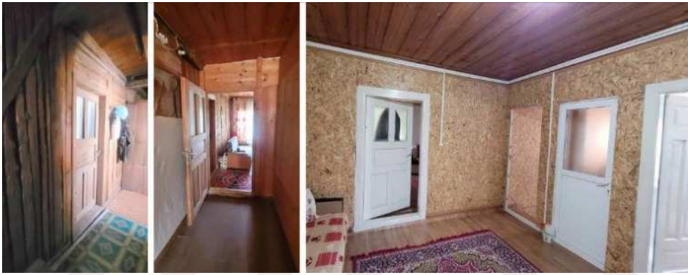
Şekil 5.9 Sofaları bölen muhdes kapılar (sırasıyla ada/parsel: 120/5, 118/16, 110/25) (2022)
