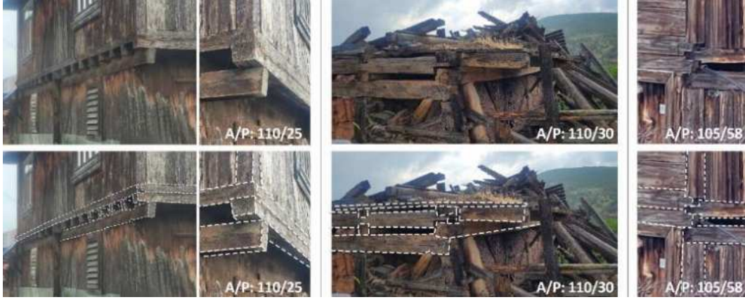
Şekil 5.61 Ahşap döşeme tabanı ve kiriş birleşimleri (2022)
