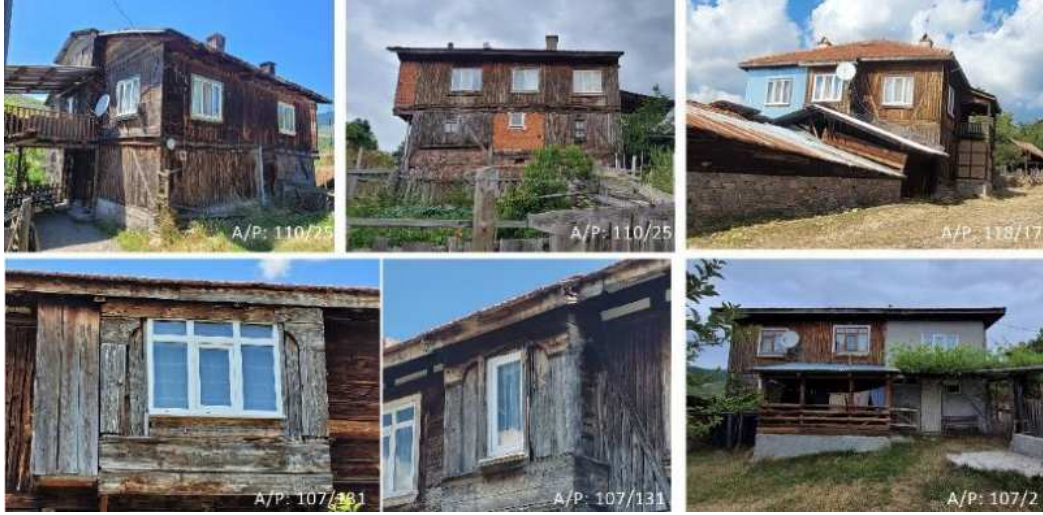
Şekil 6.17 Özgün ahşap pencere boyut ve doğramalarındaki değişiklikler, yeni PVC doğramalar (2023)
