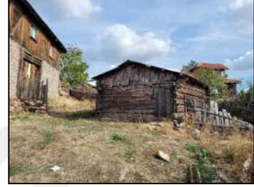
Güneybatı Görünüşü (ambar)
