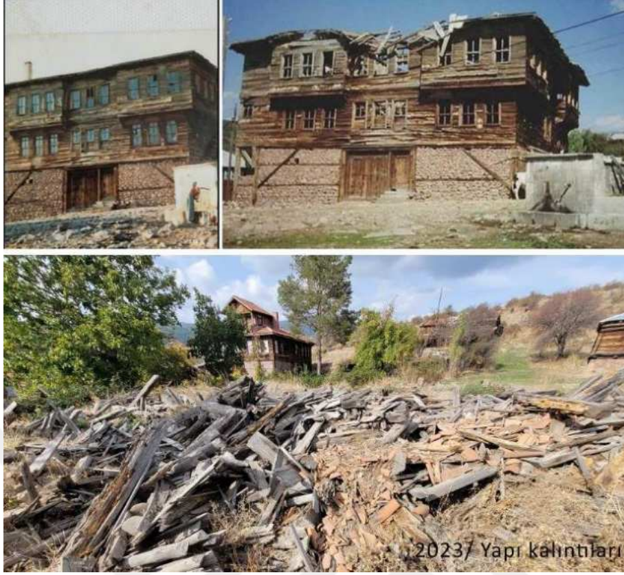
Şekil 6.22 2018 yılında yıkılan ada 105, parsel 37'deki konut [24]
