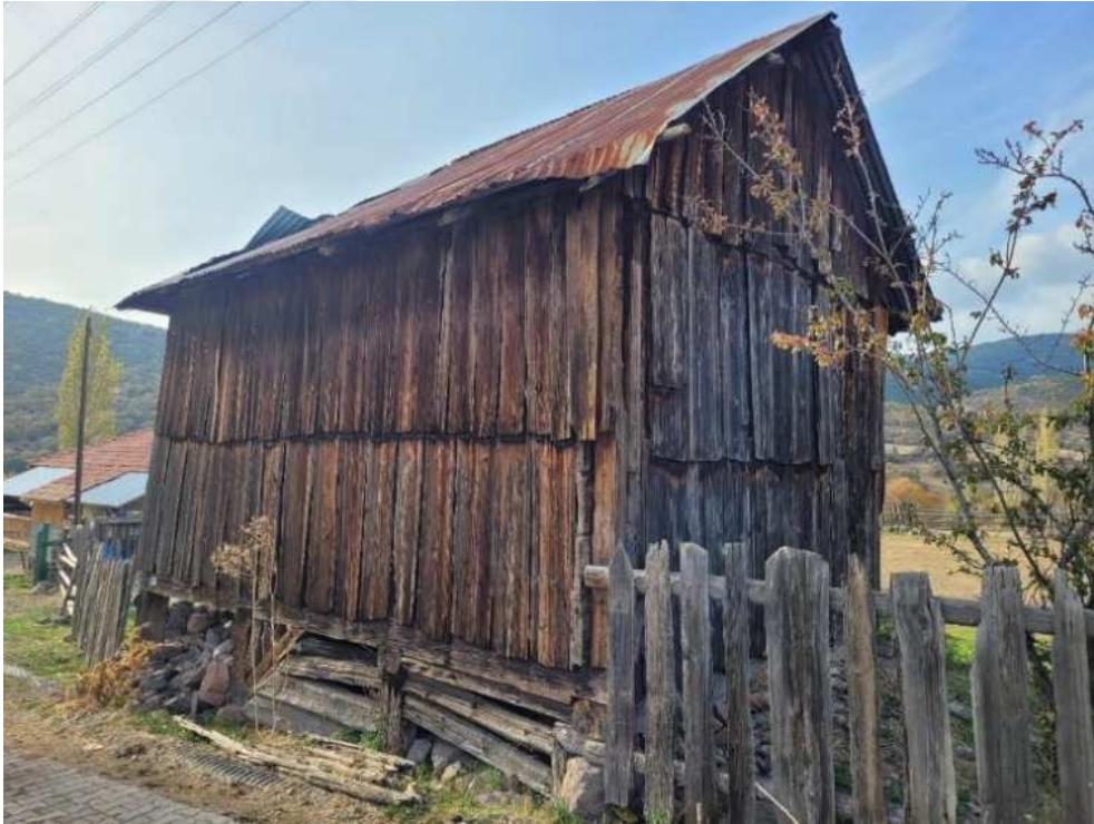
Şekil 5.22 Ada 112 parsel 58'deki ahşap karkas üzeri ahşap kaplama ambar (2023)
