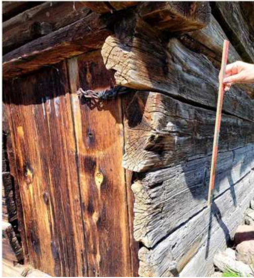
Şekil 5.19 Deveören Köyü'ndeki ahşap yığma (kurtboğaz ve karaboğaz tekniğiyle yapılmış) ambar yapıları ve detayları (2022)
