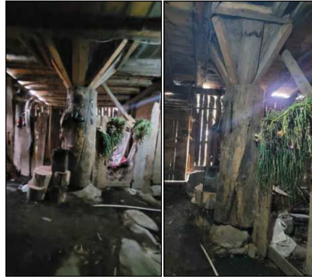
ocakçı taşıyan ahşap dikme sistem (R:65 cm) Z03 AHIR
