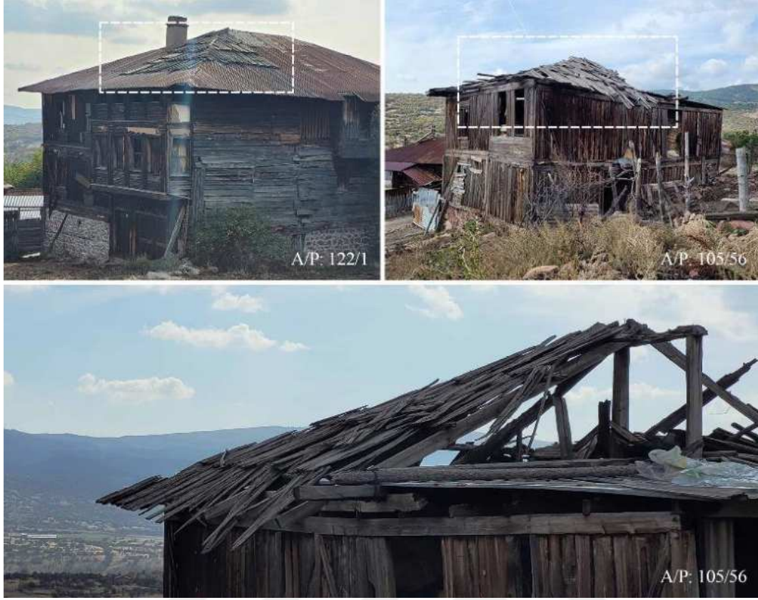
Şekil 5.66 Deveören Köyü’nde günümüzde mevcut hartamalı çatılar (2023)
