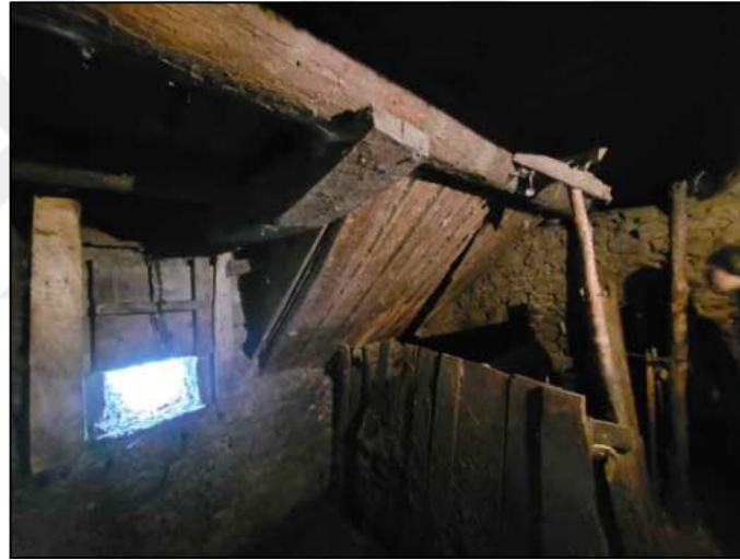
ocağın altındaki taşıyıcı sistem Z06 AHIR
