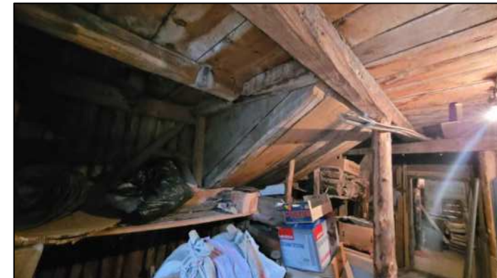
ZO1 DEPO/ OCAK ALTINDAKİ AŞAP TAŞIYICI SİSTEM
