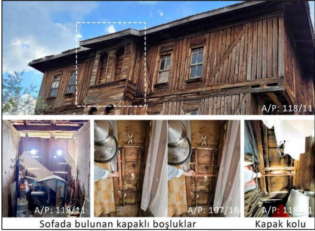
Şekil 5.48 Ada 107, parsel 18 ve Ada 118, parsel 11'deki konutun ayazlığındaki kayar pencere kapağı (2023)
