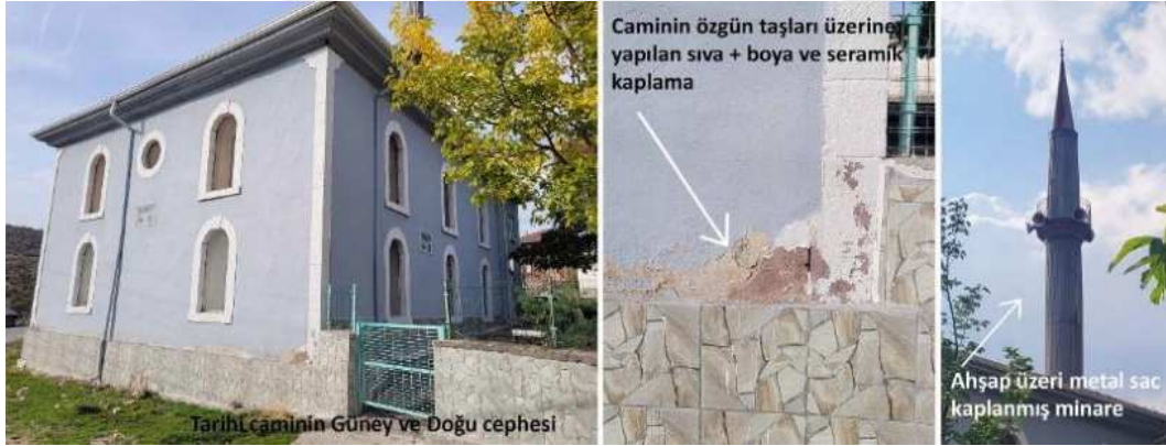
Şekil 6.18 Deveören Cami'sinin dış cephesindeki müdahaleler (2023)
