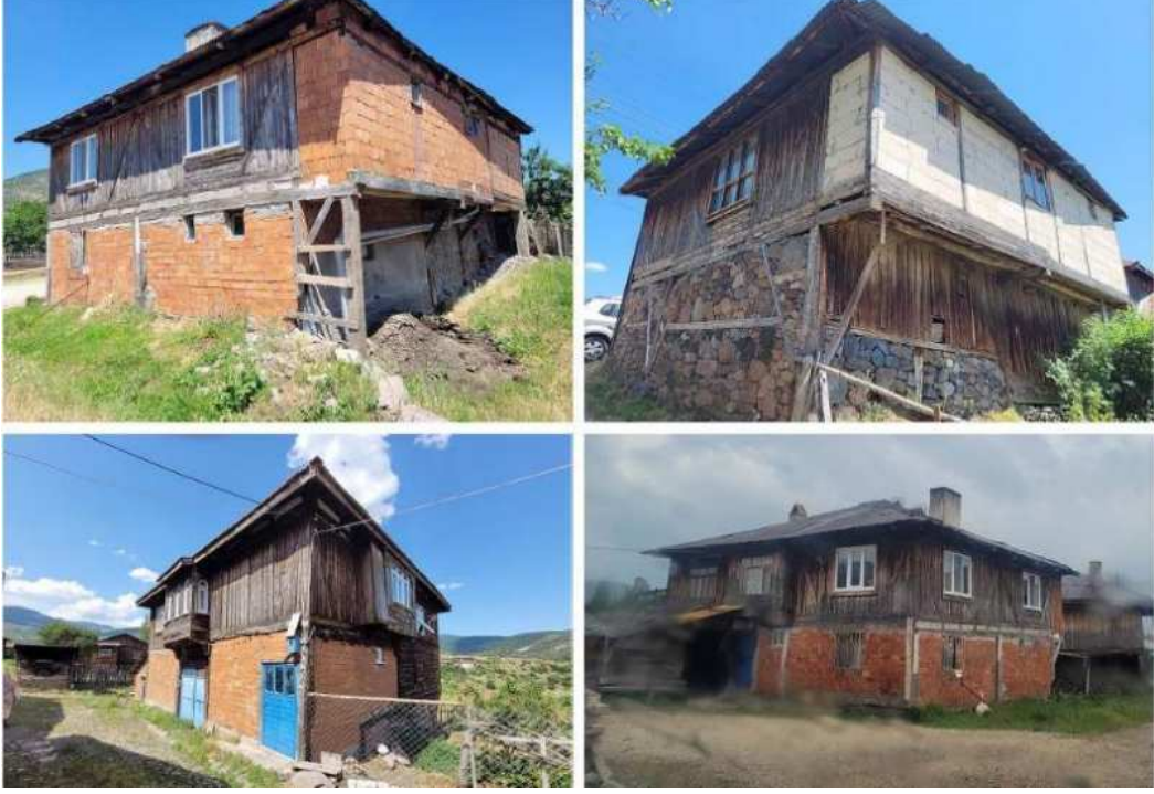
Şekil 6.19 Dış cephelerde dolgu malzemesi olarak muhdes delikli tuğla ve gazbeton kullanılması (2023)
