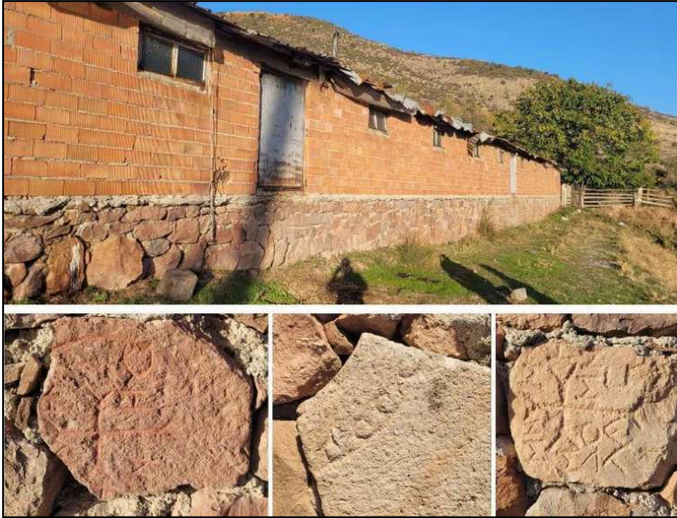
Şekil 2.4 Kümes yapısı subasmanındaki devşirme taşlar (2022)
