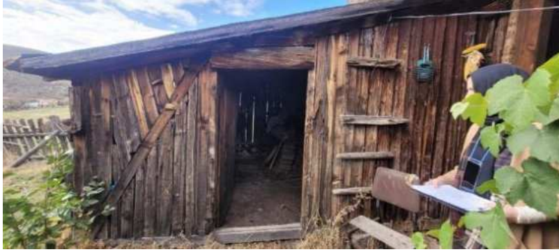
Şekil 5.25 Ada: 118, parsel:16'da bulunan arılığın çatısına çıkmayı sağlayan basamaklar (2022)
