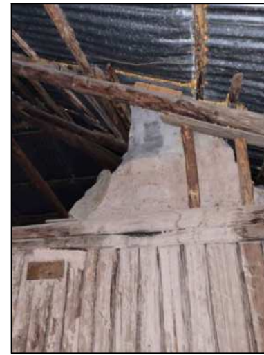
Çatının içten görünüşü ve baca çıkışı 102 SOFA/HAYAT
