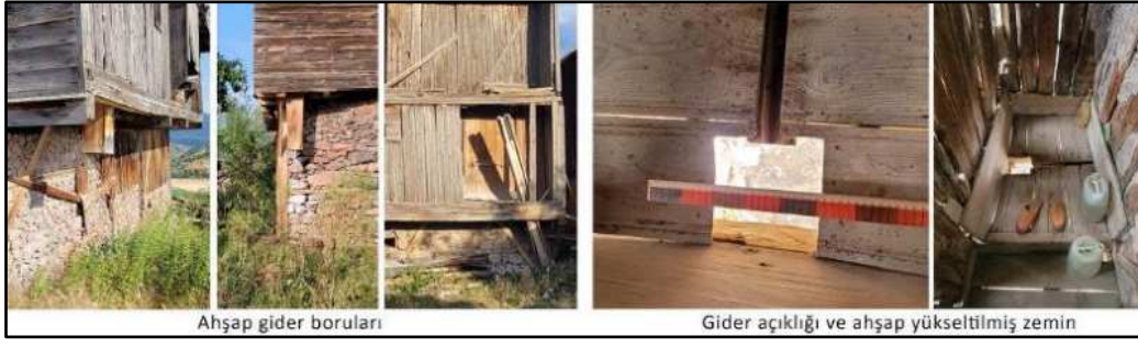
Şekil 5.15 Hela tabanı yükseltilmiş zemin ve ahşap gider boruları (2023)
