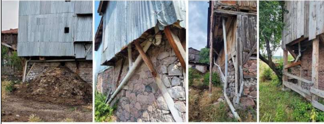
Dış cephelerde görülen PVC atık su boruları
