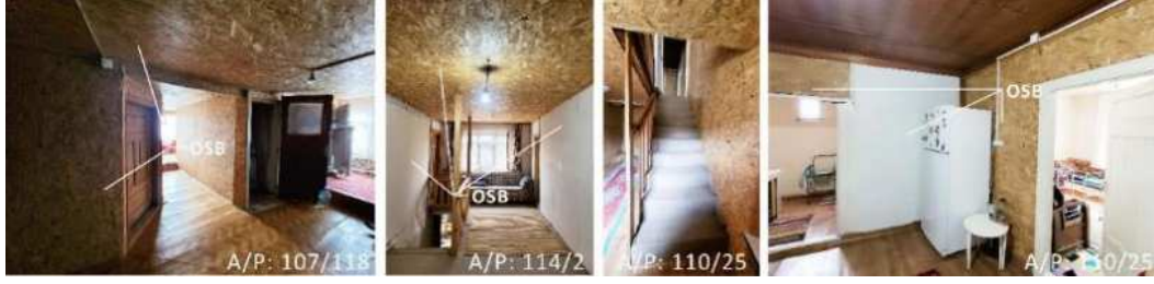
Şekil 6.15 Yalıtım sağlamak için tavan ve duvarlarda yapılan OSB (yönlendirilmiş yonga levha) kaplamalar (2023)
