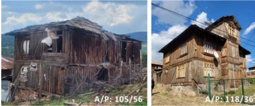
Şekil 5.54 Eğimli arazilerde bulunan konutların taş subasmanları (2022)
