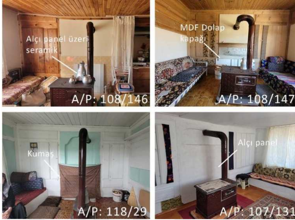
Şekil 6.14 Ön yüzü kapatılan özgün ocaklar ve kurulan sobalar (2023)
