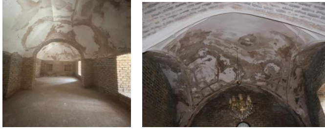
Şekil 3-45: İmitasyon (beton ) tuğla ile örülen tonoz(sol), İmitasyon (beton ) tuğla ile örülen kubbe(sağ), (HS-A, 2022)
