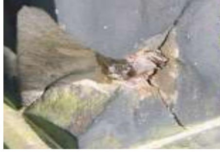
Şekil 2-25: Taş Yüzeyinden Parça Kopması
