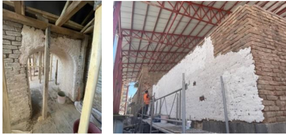
Şekil 4-50: Revaklarda kağıt hamuru ile temizlik yapılması (sol), Dış cephede kağıt hamuru ile temizlik yapılması(sağ) (HS-A, 2022)
