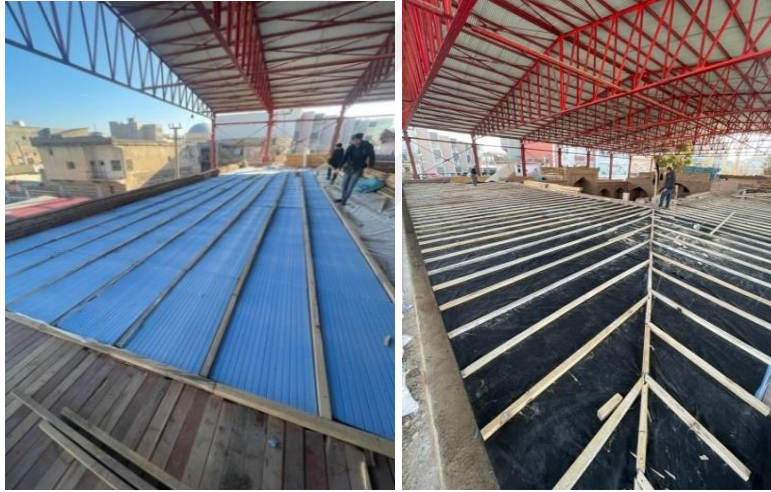
Şekil 4-39: Çatı kaplaması altına yalıtım malzemelerinin serilmesi(sol), Çatı altına buhar dengeleyici serilmesi(sağ) (HS-A, 2022)
