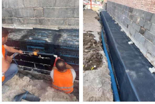
Şekil 4-5: Temel takviyesine yalıtım yapılması(sol),Temele drenaj levhası ve drenaj borusu döşenmesi (sağ) (HS-A, 2022)
