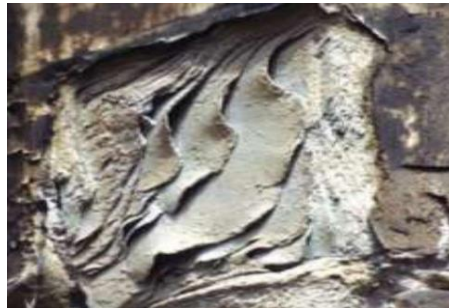
Şekil 2-22: Taş Yüzeyinde Yapraklanma
