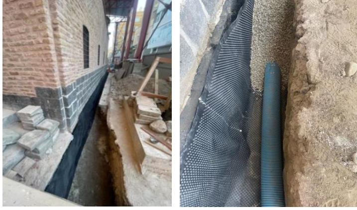
Şekil 4-7: Temel yüzeyine yalıtım yapılması (sol), Temelde drenaj levhası ve drenaj borusu döşenmesi (sağ) (HS-A, 2022)
