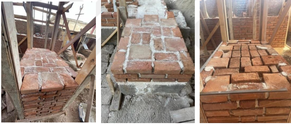
Şekil 4-27: Kırmızı Medresede şaşırtma örgü tekniği ile duvar örülmesi (HS-A, 2022)
