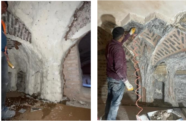
Şekil 4-54: Sıva yüzeylerinde kağıt hamuru ile temizlik yapılması(sol), Sıva yüzeyinin basınçlı hava ile temizlenmesi(sağ) (HS-A, 2022)
