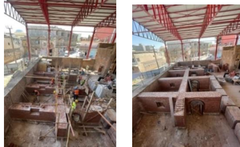
řekil 4-24: Kuzey dođu duvar rm ařamaları (HS-A, 2022)
