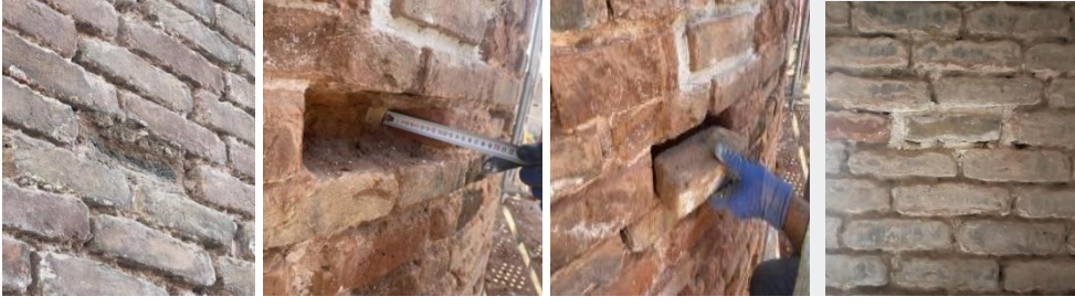
Şekil 4-18: Soldan sağa uygulama aşamaları (HS-A, 2022)
