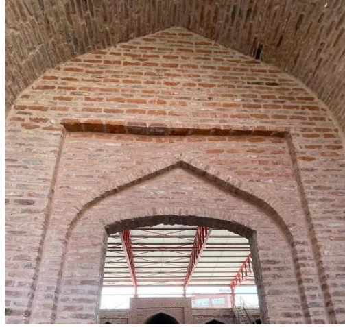
Şekil 4-16: Onarım sonrası görünüş (HS-A, 2022)
