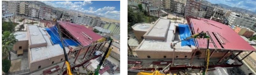
Şekil 4-71: Kırmızı Medrese geçici çatı söküm aşaması (HS-A, 2022)
