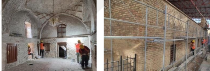
Şekil 4-9: Medrese mescit bölümünde derz açma işlemi(sol), Medrese doğu cephelerinde derz açma işlemi (sağ) (HS-A, 2022)
