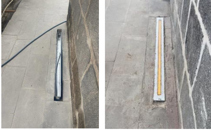
Şekil 4-63: LED Wallwasher montajı (HS-A, 2022)
