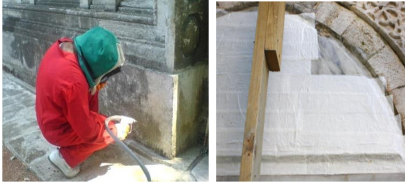
Şekil 2-34: Kumlama ile mekanik temizlik yapılması(sol), Kağıt hamuru ile kimyasal temizlik yapılması(sağ)
