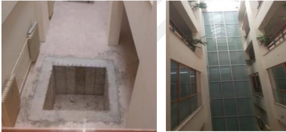
Şekil 2-39: Çukurova üniversitesi Su Ürünleri Fakültesi galeri boşluğuna asansör temel kuyusu açılması(sol), kat asansörü güncel durum(sağ) (ŞAHİN & DİKMEN, 2023)
