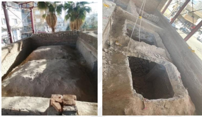
Şekil 4-34: Beton olan tonoz üstündeki çatı kaplamalarının sökülmesi(sol)Doğu-I Hücresinin beton olan tonozunun sökülmesi(sağ) (HS-A, 2022)
