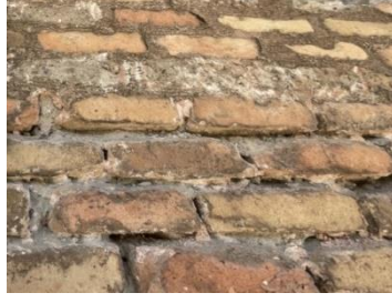
Şekil 4-8: Tuğla duvar yüzeyinde derz açma işlemi (HS-A, 2022)
