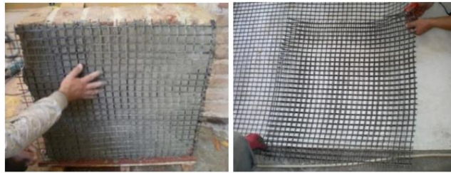
Şekil 2-7: Karbon Izgara İle Donatılı Harç Uygulaması (Mezrea & Yılmaz, 2013)
