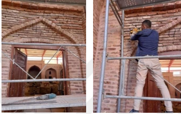
Şekil 4-15: Duvar Çatlağın da karbon çubuk yerleşimi(sol), Epoksi uygulaması(sağ) (HS-A, 2022)
