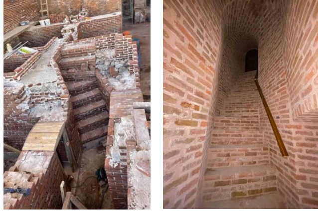
Şekil 4-59: Çatı merdiveni örümü (sol), Tamamlanan çatı merdiveni (sağ) (HS-A, 2022)
