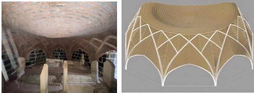
Şekil 3-10: Türbenin alt katı(cenazelik)(solda) (HS-A, 2022), Türbe alt kat ters kubbe modeli (sağda) (TURES, 2017)
