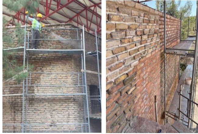
Şekil 4-12: Derz yapılmadan önce duvarın basınçlı su ile yıkanması(sol), Derz dolgu yapılması(sağ) (HS-A, 2022)
