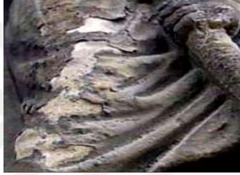
Şekil 2-21: Taş Yüzeyinde Kavlama
