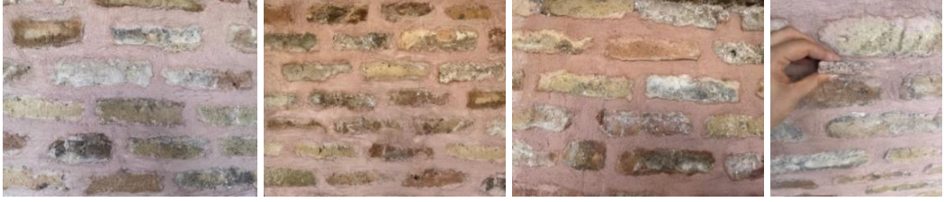
Şekil 4-11: Yapılan farklı Derz dolgu numuneleri (HS-A, 2022)
