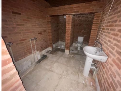
Şekil 4-58: Avlunun kuzey doğu tonozunda yapılan ıslak hacim birimleri (sağ) (HS-A, 2022)
