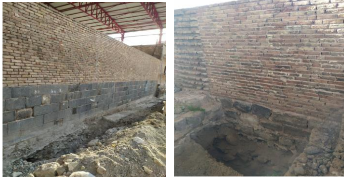
Şekil 4-1: Kuzey duvarı dış cephe gözlem çukuru(sol), Kuzey duvarı iç kısım gözlem çukuru(sağ),
