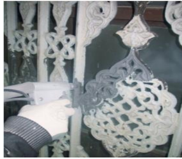
Şekil 2-36: Pertevniyal Valide Sultan Cami, metal elemanlarda gerçekleştirilen kumlama işlemi aşamaları (Zakar, 2013)
