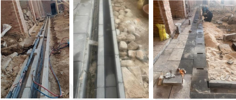
Şekil 4-69: Mekanik kanal ve Drenaj kanalı yapımı (sol), Kanal kapaklarının yerleştirilmesi(sağ) (HS-A, 2022))
