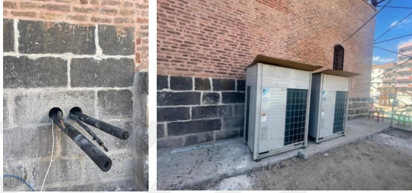
Şekil 4-67: Dış ünite bağlantısı(sol), Dış ünite Yerleşimi(sağ) (HS-A, 2022)
