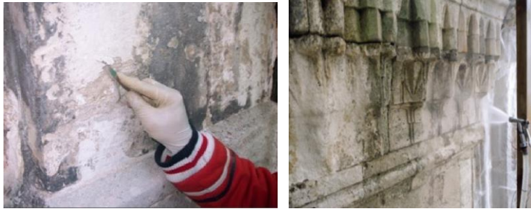
Şekil 2-33: Bisturi ile mekanik temizlik yapılması(solda), su ile mekanik temizlik yapılması (sağda)
