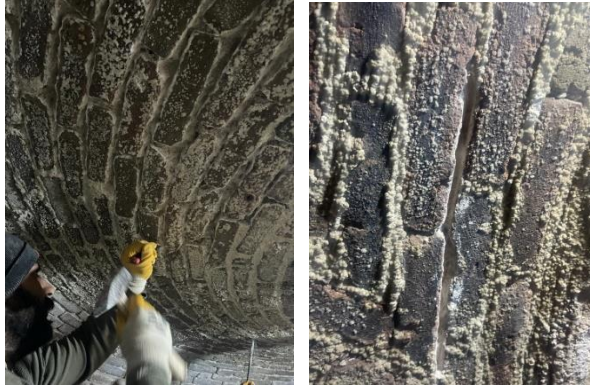
Şekil 4-48: Tuğla yüzeyinde mekanik temizlik ve derz açma (HS-A, 2022)
