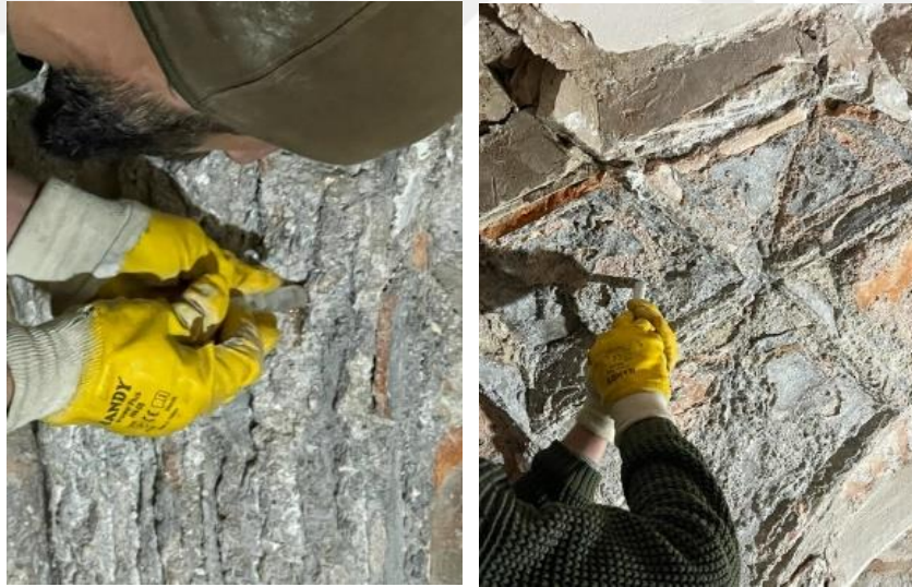
Şekil 4-56: Alkol enjekte edilmesi(sol), Malta harcı enjekte edilmesi (sağ) (HS-A, 2022)
