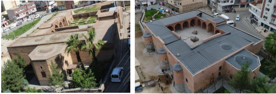
Şekil 3-30: Kırız Medrese Güney Cephesi(sol) (AVGM-A, 2021), Kırız Medrese Güneybatı Cephesi (sağ) (HS-A, 2022)
