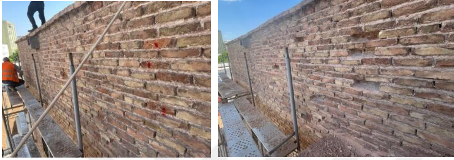
Şekil 4-19: Tuğla duvarda çürütülecek tuğlaların belirlenmesi(sol), Belirlenen tuğlaların çürütülerek alınması(sağ) (HS-A, 2022)
