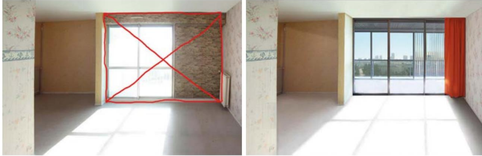
Şekil 2-11: İç mekan cephe duvarının müdahale öncesi görünümü(sol), Müdahale sonrası görünümü (sağ) (Sadıkoğlu, 2016)
