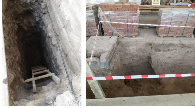
Şekil 4-2: Doğu dış cephesi gözlem çukuru (sol),Hücre ara duvar temelinde açılan gözlem çukuru (sağ) (HS-A, 2022)
