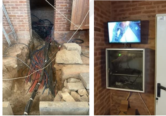
Şekil 4-60: Teknik hacim hücresi alt yapısının döşenmesi (sol), Teknik hacimde kamera sistemi (sağ) (HS-A, 2022)
