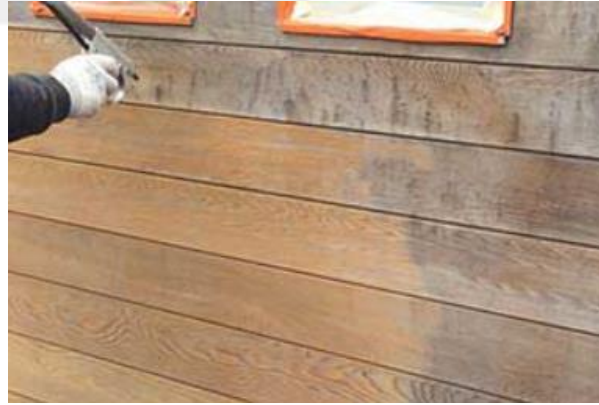
Şekil 2-35: Ahşap yüzeyde kumlama ile yapılan mekanik temizlik
