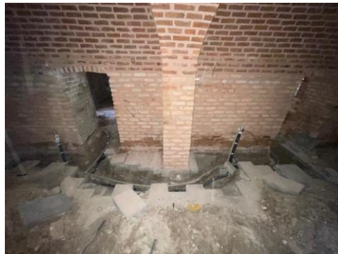
Şekil 4-66: İklimlendirme sistemi için döşemeye yapılan müdahale
