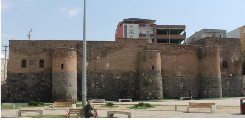
Şekil 3-33: Kırmızı Medrese Batı Cephesi (AVGM-A, 2021)
