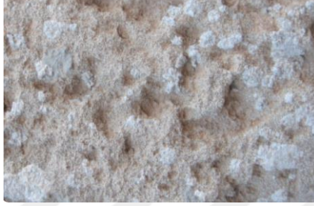
Şekil 2-18: Taş Yüzeyinde Çiçeklenme
