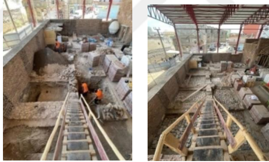
řekil 4-23: Kuzey dođu blmnde temel tespit kazıları(sol), Blokaj dřenmesi(sađ)
