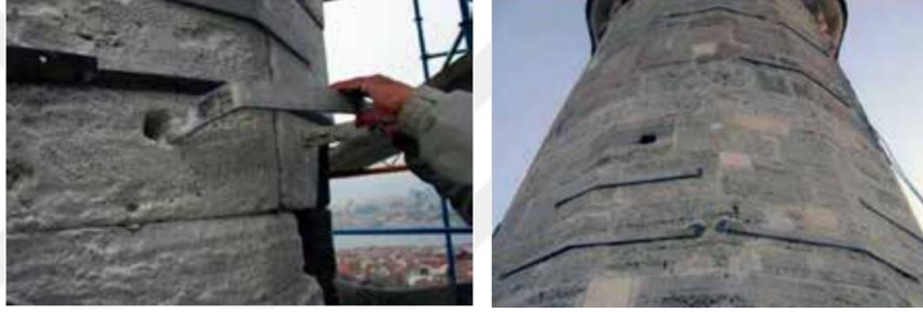
Şekil 2-4: Fatih Camii Minarede Paslanmaz Çelik Kenet Uygulaması (Haluk Yıldız & 2013)
