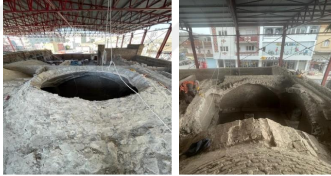
Şekil 4-30: Harim doğu kubbesinin sökümü (sol), Kubbe altı kemerlerin sökümü(sağ)
