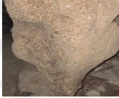
Şekil 2-28: Taş Yüzeyinde Aşınma
