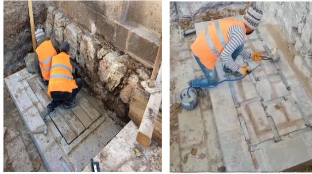
Şekil 4-4: Yeni temel ile eski temelin çelik tijlerle bağlantısının yapılması(sol), Kenet bağlantı yerlerine kurşun dökülmesi(sağ) (HS-A, 2022)
