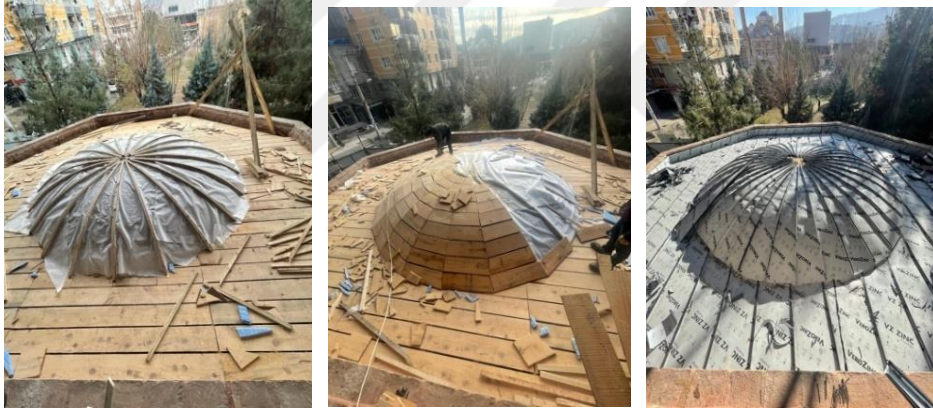
Şekil 4-41: Çatı altına sırasıyla buhar dengeleyici serilmesi, havalandırma merteklerinin döşenmesi, Titanyum çinko kenet sistem çatı kaplamasının yapılması (HS-A, 2022)
