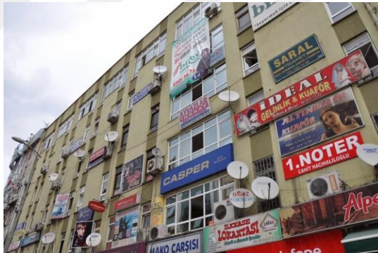
Şekil 2-43: Cepheye yerleştirilen klima dış üniteleri ve çanak antenler
