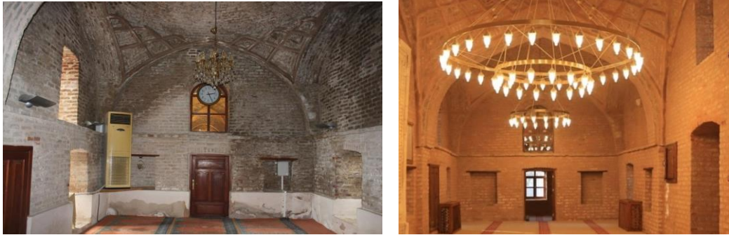
Şekil 4-65: Yapının mescit bölümünde yapılan klima sistem müdahaleleri(sol), Mescit bölümü VRF sistem kurulum sonrası(sağ) (HS-A, 2022)
