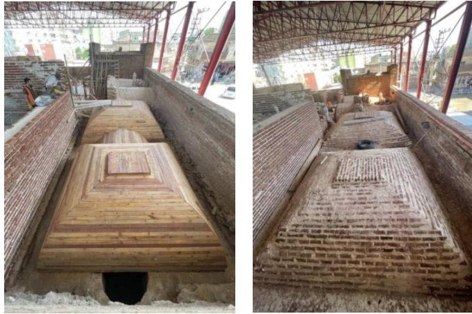
Şekil 4-35: Aynalı tonoz kalıbının kurulması(sol), Aynalı tonozun örülmesi(sağ) (HS-A, 2022)
