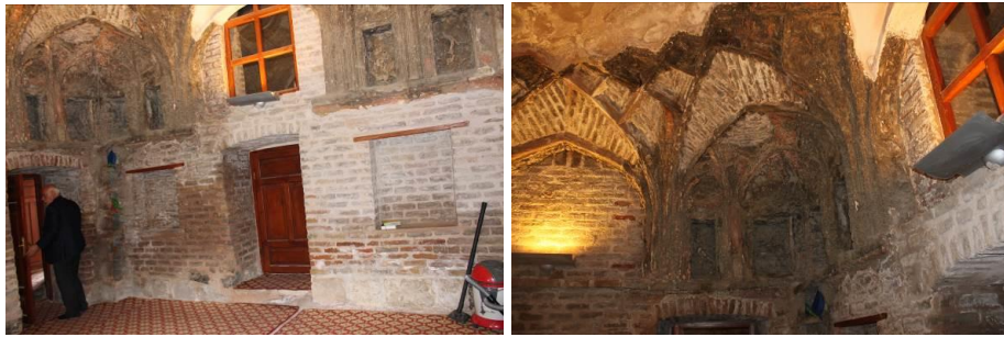
Şekil 3-13: İbrahim Es- Sori Türbesinin iç mekan görünüşleri 2019 (AVGM-A, 2021)
