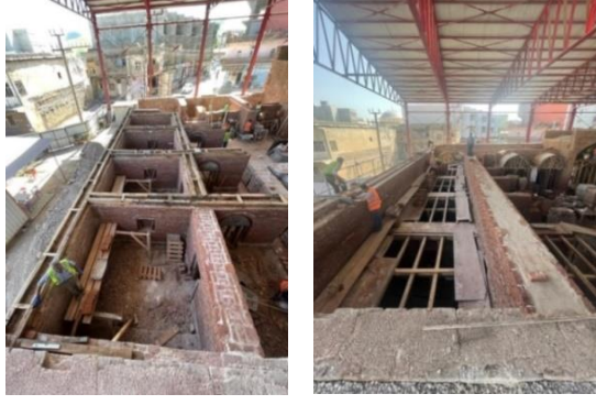
Şekil 4-25: Kuzey doğu bölümde eski ve yeni duvar arası lento bağlantıları(sol), tonoz sırtlarındaki duvarların örülmesi(sağ) (HS-A, 2022)
