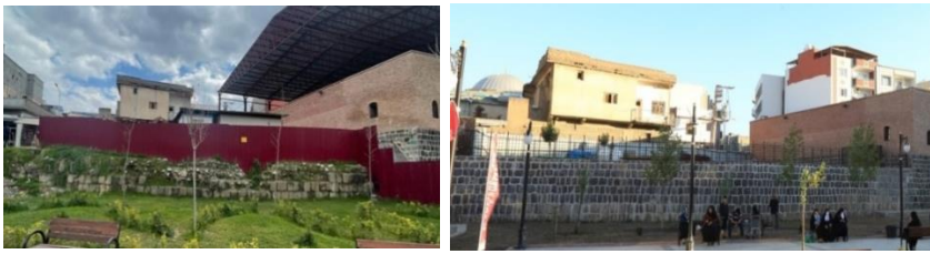
Şekil 4-73: Medrese Kuzey Batısında bulunan sur duvarının müdahale öncesi durumu(sol), ve müdahale sonrası durumu(sağ) (HS-A, 2022)
