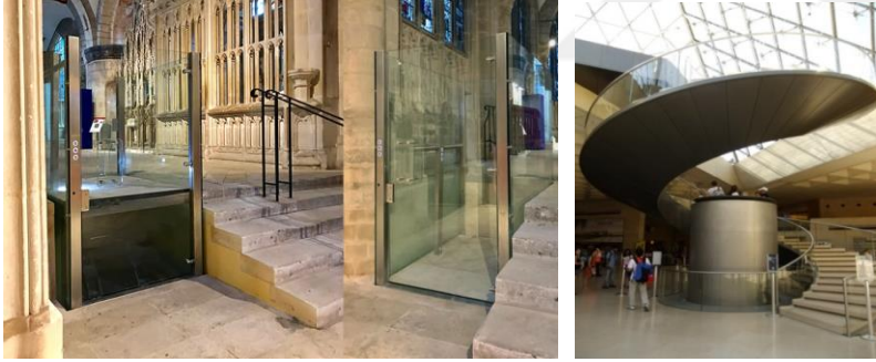
Şekil 2-40: Gloucester Katedrali'ne eklenen asansör sistemleri ve merdiven kenarlarında bulunan korkuluklar(sol), Louvre Sanat Müzesi tüp asansör sistemi(sağ) (Url-4).
