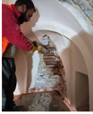
Şekil 4-13: Yatak derzlerinin doldurulması (HS-A, 2022)
