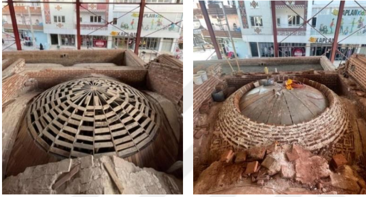
Şekil 4-32: Kubbe kalıbının kurulması(sol), kubbenin örülmesi(sağ),
