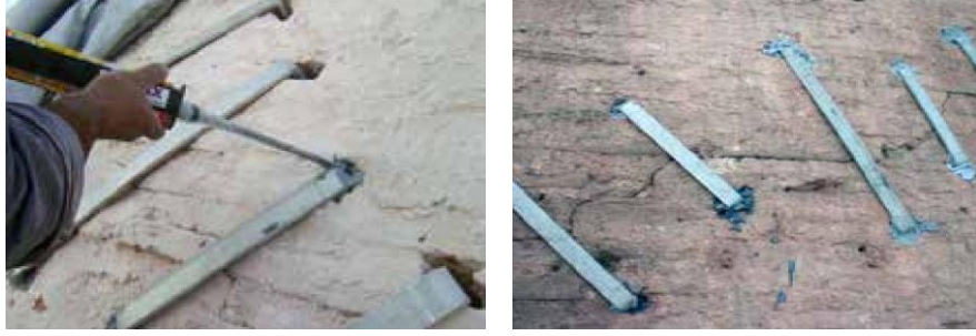
Şekil 2-3: Fatih Camii Kubbede Paslanmaz Çelik Kenet Uygulaması (Haluk Yıldız & 2013)
