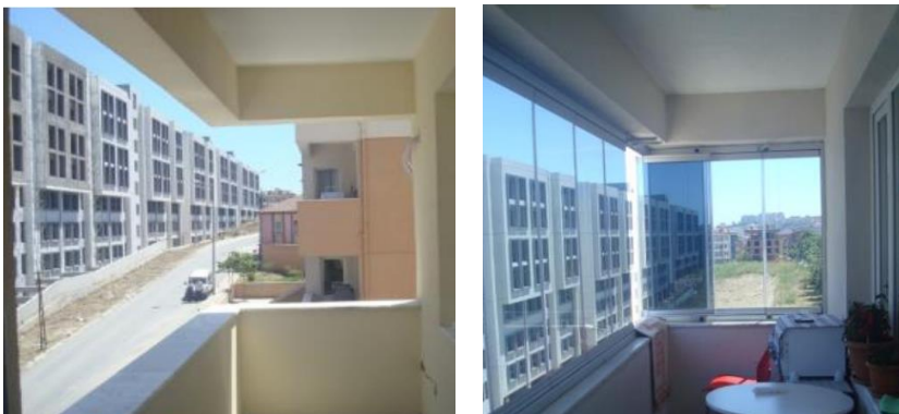
Şekil 2-41: Açık olan balkon cephesinin cam doğrama ile kapatılması
