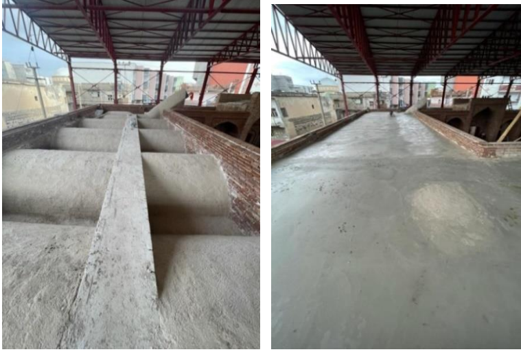
Şekil 4-38: Üst örtü elemanı olan tonoz yüzeylerine tamir harcı uygulanması(sol), Tonoz aralarına ponza taşı doldurularak şap yapılması(sağ) (HS-A, 2022)
