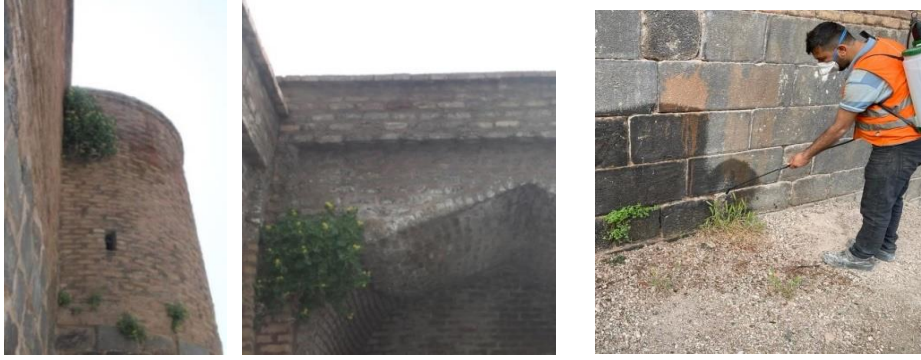
Şekil 4-21: Medrese cephelerinde otsu bitkiler(sol), Herbisit ilaç ile bitki temizliği yapılması(sağ) (HS-A, 2022)
