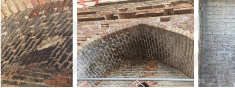
Şekil 4-49: Tuğla yüzeyindeki kararmaların temizlenmesi için kağıt hamuru ve AB57 denenmesi (HS-A, 2022)
