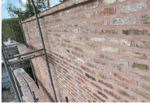
Şekil 4-20: Çürütme müdahalelerinden sonra tuğla duvar yüzeyi (HS-A, 2022)
