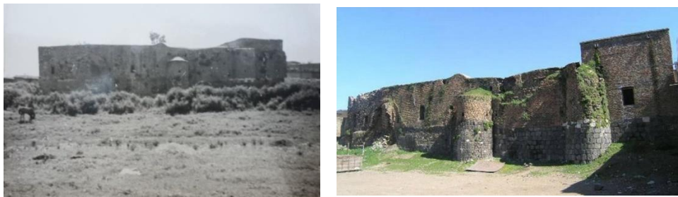
Şekil 3-32: Kırmızı Medrese Kuzeybatı Cephesi 1972 (sol) (DKTVKK-A, 2021), Kırmızı Medrese Batı Cephesi 2007(sağ) (TURES, 2017)
