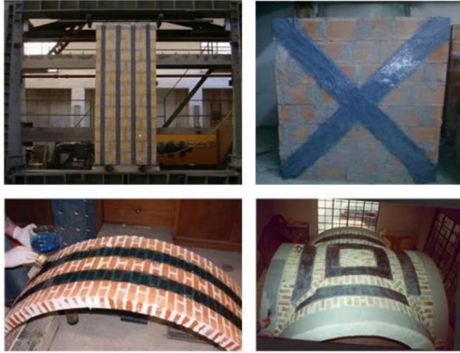
Şekil 2-9: Karbon şeritlerin farklı yapı elemanı güçlendirmesinde kullanılması (Değirmenci & Sarıbıyık, 2015)
