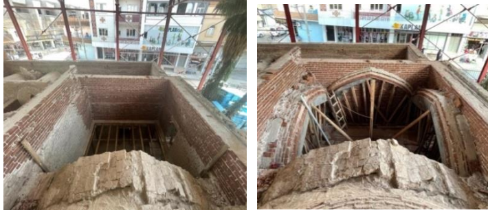
Şekil 4-31: Kubbe altı taşıyıcı duvarların örülmesi(sol), Kubbe altı kemerlerin örülmesi(sağ)
