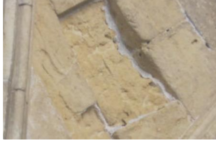
Şekil 2-23: Taş Yüzeyinde Yüzey Kaybı
