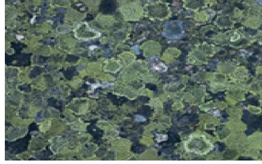
Şekil 2-30: Taş Yüzeyinde Liken Oluşumu
