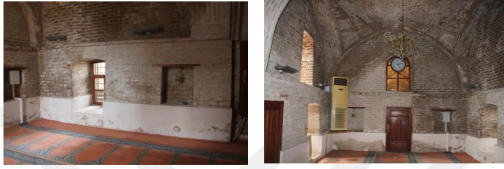
Şekil 3-46: Elektrik bağlantısı Kablo geçişleri için yapılan müdahaleler
