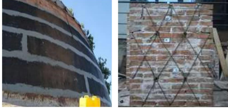
Şekil 2-10: FRP Kumaş İle Kubbe Kaplaması (Solda), FRP Halatla Duvar Güçlendirilmesi (Sağda) (Değirmenci & Sarıbyık, 2015)
