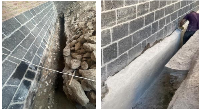
Şekil 4-6 Moloz taş olan temel yüzeyinin temizlenmesi (sol), moloz taş olan temel yüzeyinin sıvanması(sağ) (HS-A, 2022)
