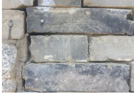
Şekil 2-27: Taş Yüzeyinde Renk Değişimi
