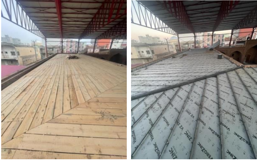
Şekil 4-40: Havalandırma merteklerinin döşenmesi(sol),Titanyum çinko kenet sistem çatı kaplamasının yapılması(sağ) (HS-A, 2022)
