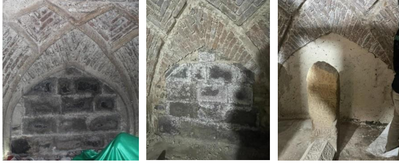
Şekil 4-44: Taş yüzeyinde sırasıyla tuzlanma, Mekanik temizlik yapılması, Kağıt hamuru ile temizlik yapılması fotoğrafları (HS-A, 2022)
