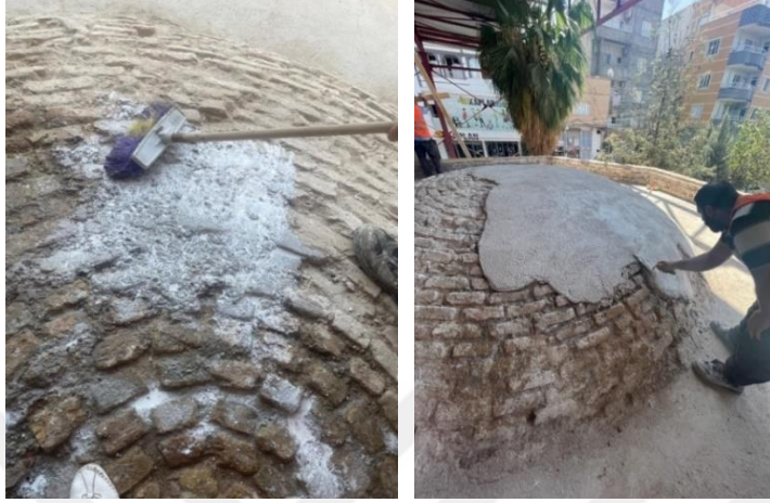
Şekil 4-36: Kubbe yüzeyine paroloid sürülmesi(sol), Kubbe yüzeyine tamir harcı uygulanması(sağ) (HS-A, 2022)
