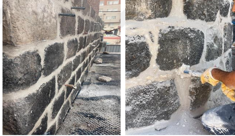
Şekil 4-17: Medrese beden duvarlarına açılan enjeksiyon delikleri (sol), Kompresör ile enjeksiyon yapılması (sağ) (HS-A, 2022)
