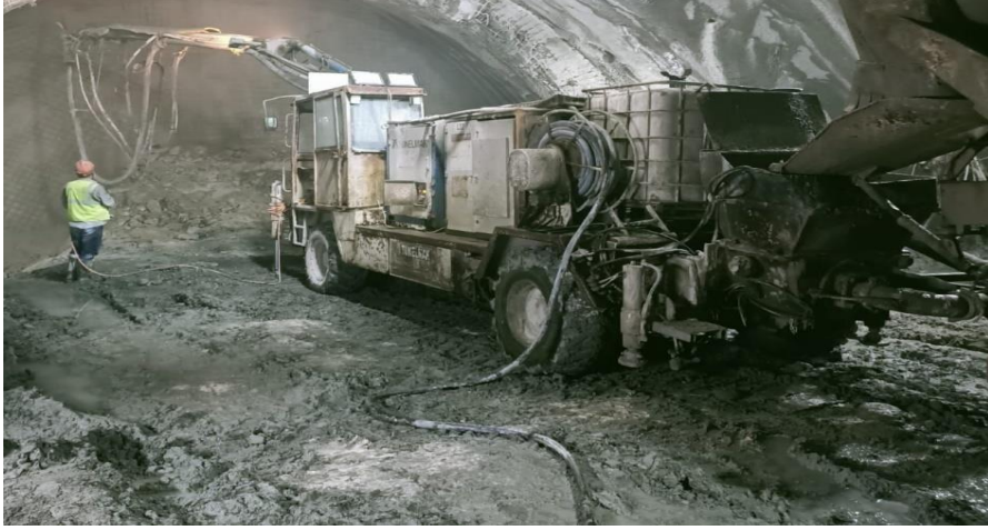
Şekil 6. Beton püskürtme makinesi
