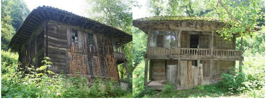
Şekil 5.23. Meyvalı Köyü Camisi restorasyon öncesi görünümü (KTB, t.y.a)
