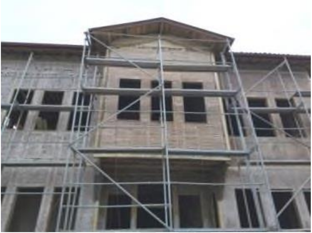
Şekil 5.58. Abbasoğlu Konağı'nın ahşap iskelet sisteminde kerpiç dolgusu ve çıkma yapan bölümde bağdadi çita uygulaması (Nurcan Karşlıoğlu, 2015 akt. Şahin vd., 2021)
