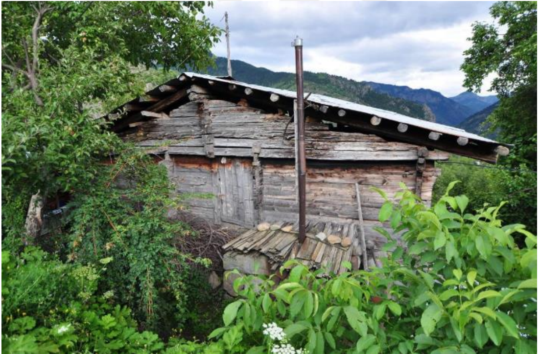
Şekil 5.95. Zurabet Evi kuzeybatı cephesi (Göçmen, 2010)
