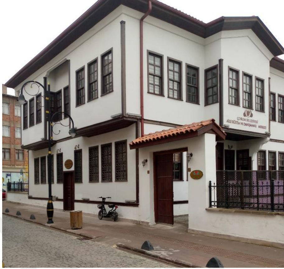
Şekil 5.63. Abbasoğlu Konağı'nın restorasyon sonrası güneybatı cephesi (Yazarın kendi arşivi, 2023)
