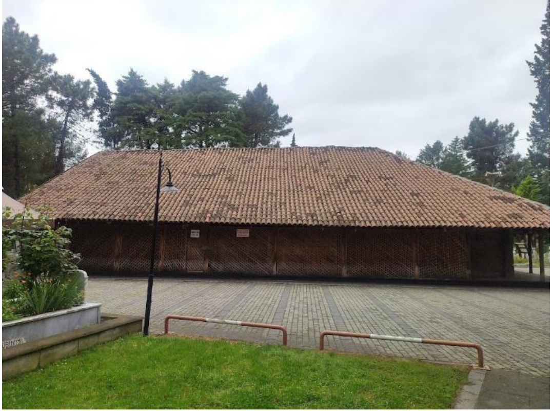
Şekil 5.18. Göğceli Camisi doğu cephesi (Yazarın kendi arşivi, 2023)
