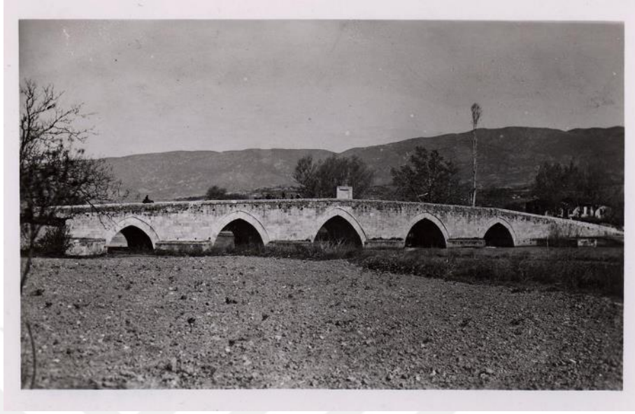
Şekil 5.77. Taş Köprü (Tokat Hıdırlık Köprüsü) (Salt Araştırma Arşivleri, t.y.)
