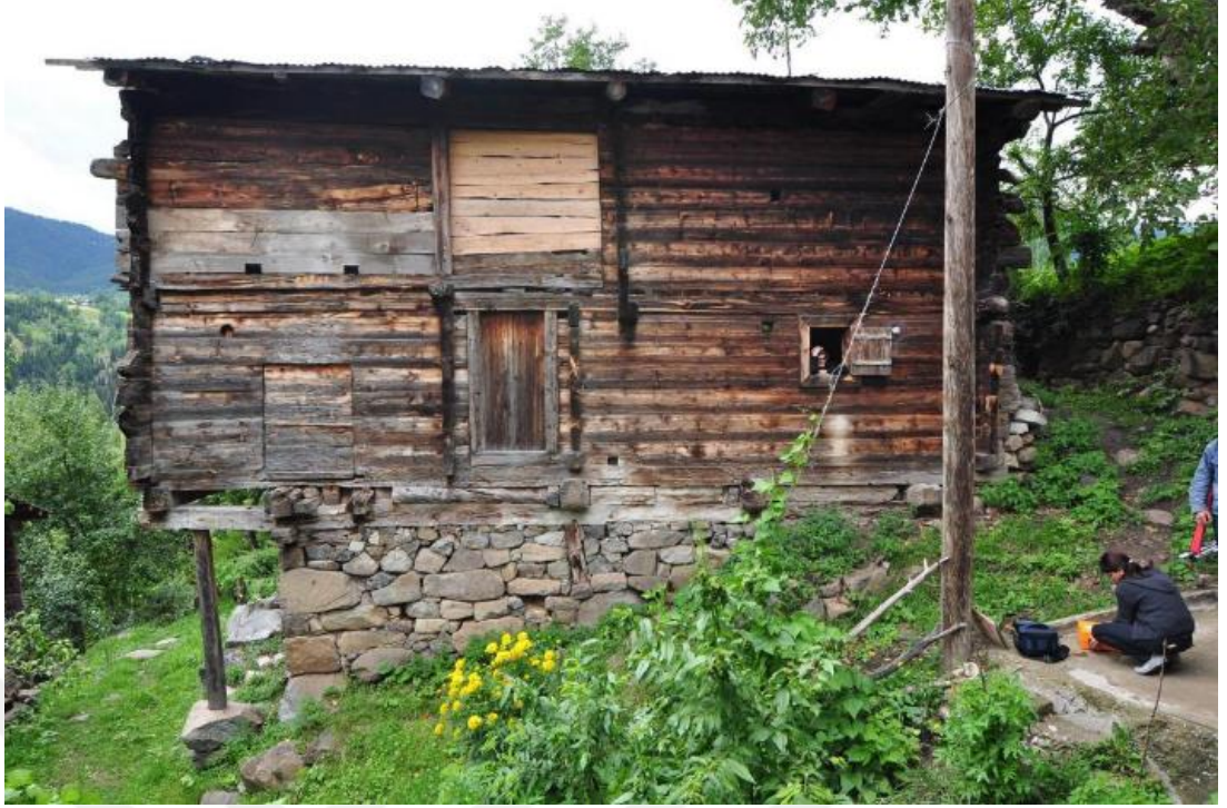
Şekil 5.94. Zurabet Evi kuzeydoğu cephesi (Göçmen, 2010)
