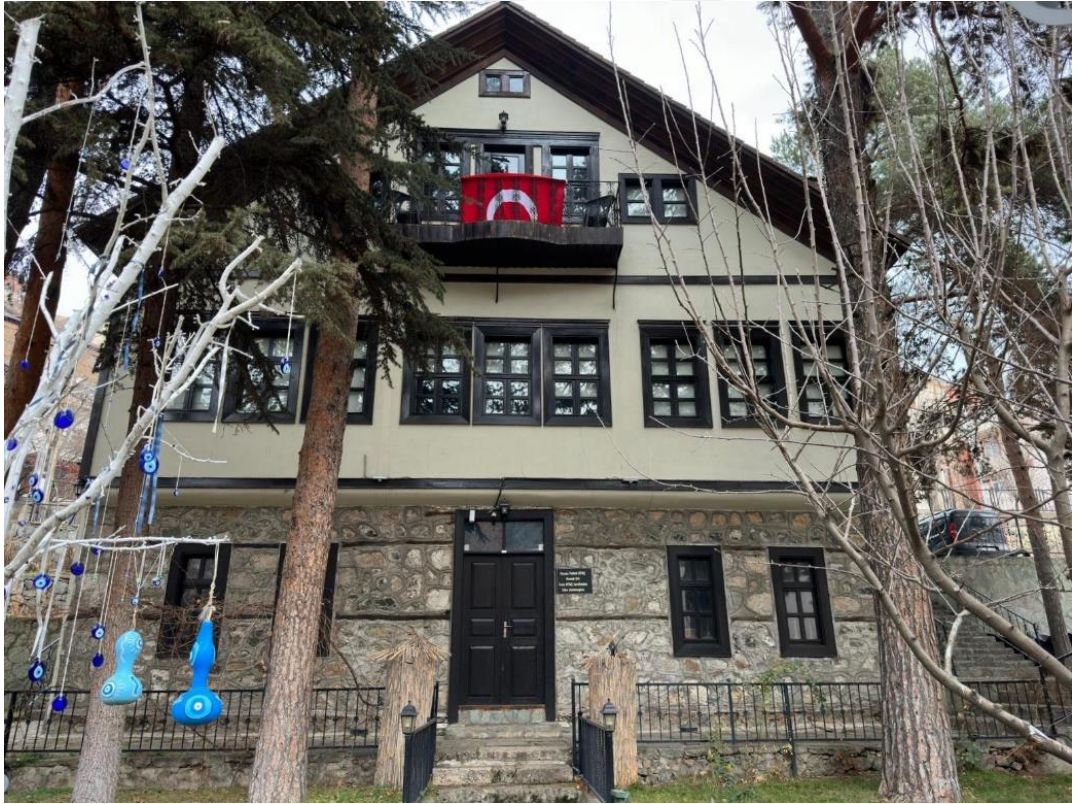
Şekil 5.84. Hasan Fehmi Ataç Konağı güneybatı görünüşü (Yazarın kendi arşivi, 2024)
