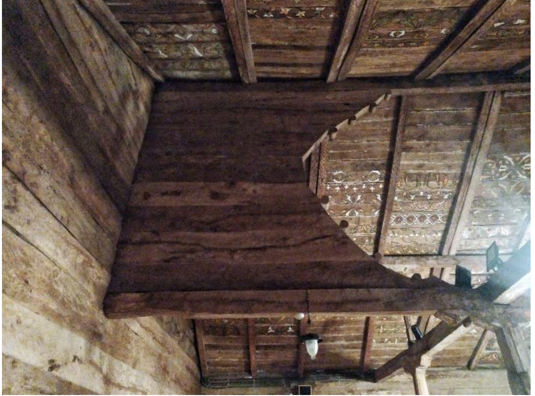
Şekil 5.13. Göğceli Camisi çatı sistemi (Yazarın kendi arşivi, 2023)
