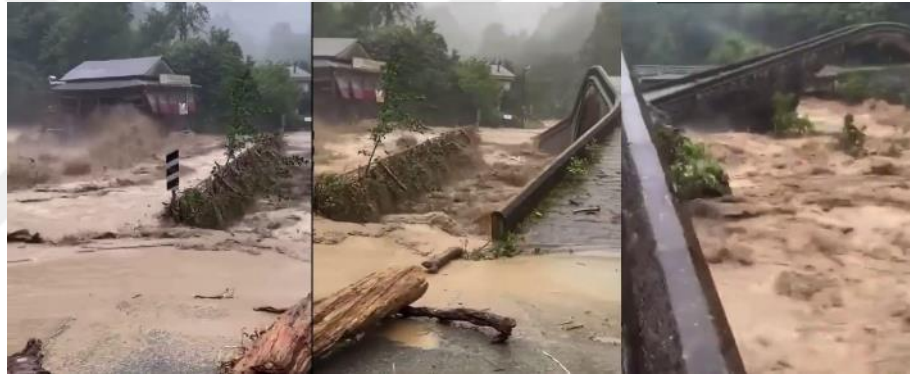
Şekil 5.49. Sel felaketinde yıkılan betonarme köprünün yanında ayakta kalan Çifteköprü (Ekşi, 2021)
