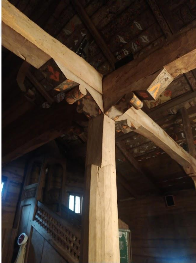
Şekil 5.15. Göğceli Camisi çatıyı taşıyan ahşap dikmeler (Yazarın kendi arşivi, 2023)
