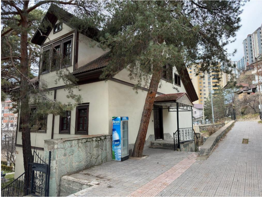
Şekil 5.82. Hasan Fehmi Ataç Konağı doğu görünüşü (Yazarın kendi arşivi, 2024)
