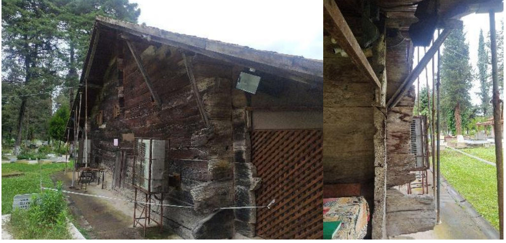
Şekil 5.12. Göğceli Camisi yapımında kullanılan yığma tekniği ve kurtboğazı geçme yöntemi (Yazarın kendi arşivi, 2023)
