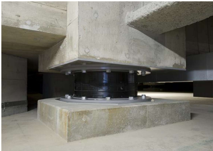
Şekil 2.3 : Montajı tamamlanmış kurşun çekirdekli elastomer tipi deprem yalıtım birimi (Tchamo ve Zhou, 2018).
