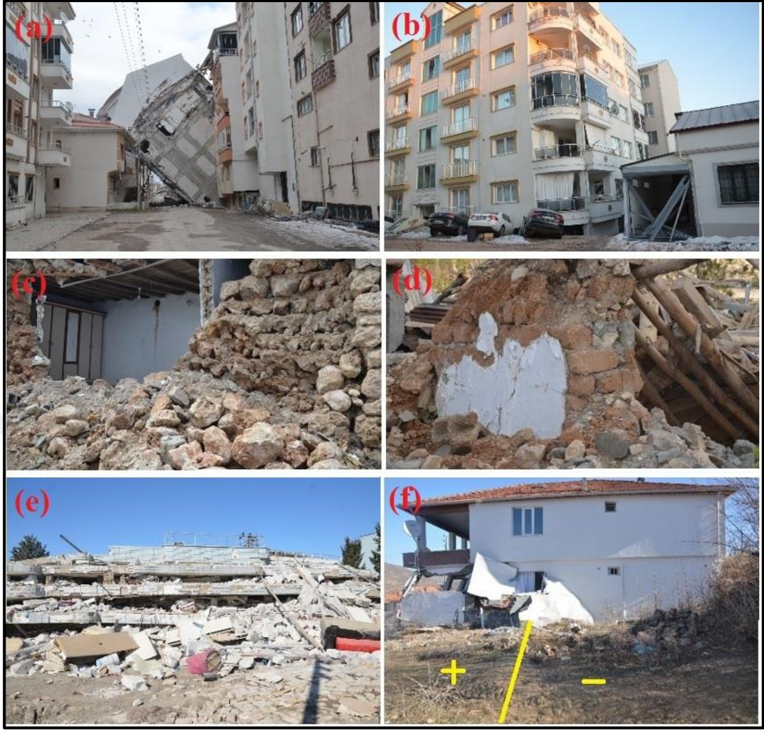
Şekil 3.120. Yerleşmelerde yıkılan ve hasar gören binalar
