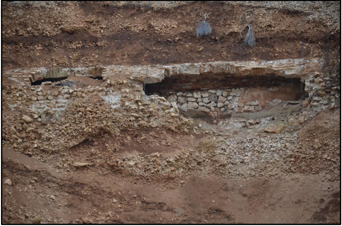
Şekil 4.6. Bozlar – Çağlayancerit yolu üzerindeki eski su kanalı
