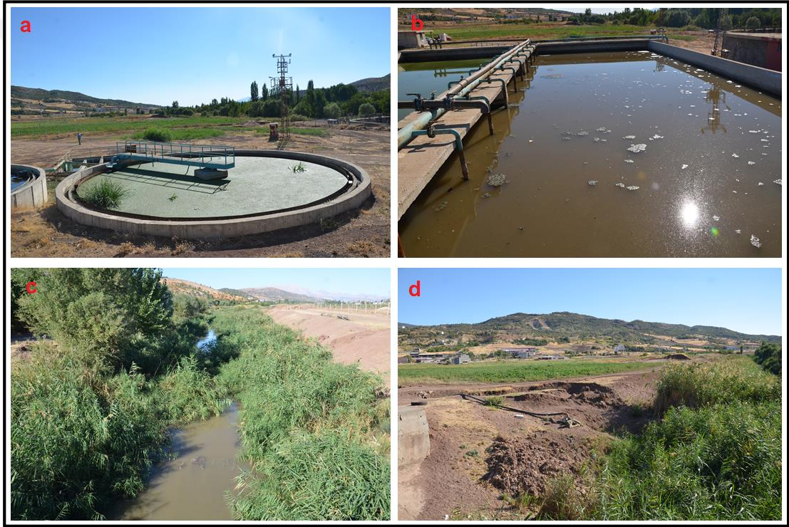
Şekil 4.56. Atık su arıtma tesisi ve çevresindeki su kanalı
