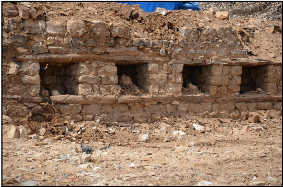
Şekil 3.106. Evlerin inşasında kullanılan juniperus sp. gövdeleri (2023 depremi sonrasında yıkılan evlerin temellerinde görülmektedir)
