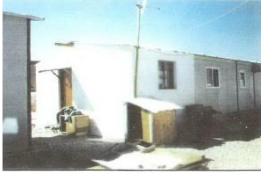
Şekil 6: 1999 Ağustos depremi sonrası yapılan eklemeler (Enginöz,2005)
