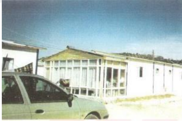
Şekil 8: 1999 Ağustos depremi sonrası yapılan eklemeler(Enginöz,2005)
