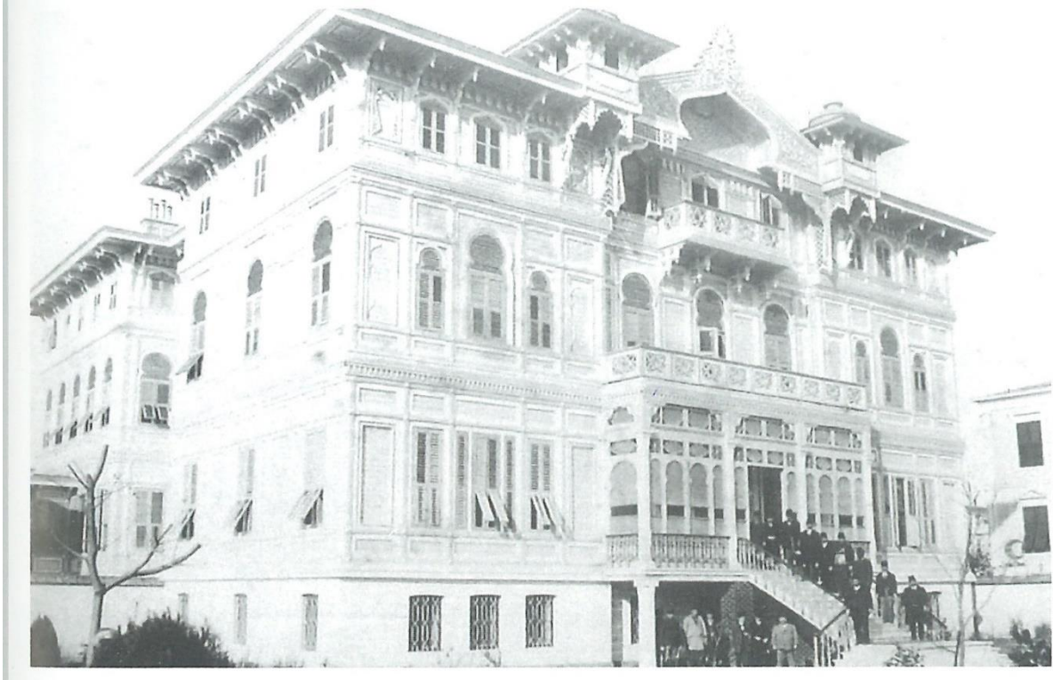
Fotoğraf 2: Sadrazam Halil Rifat Paşa Konağı
