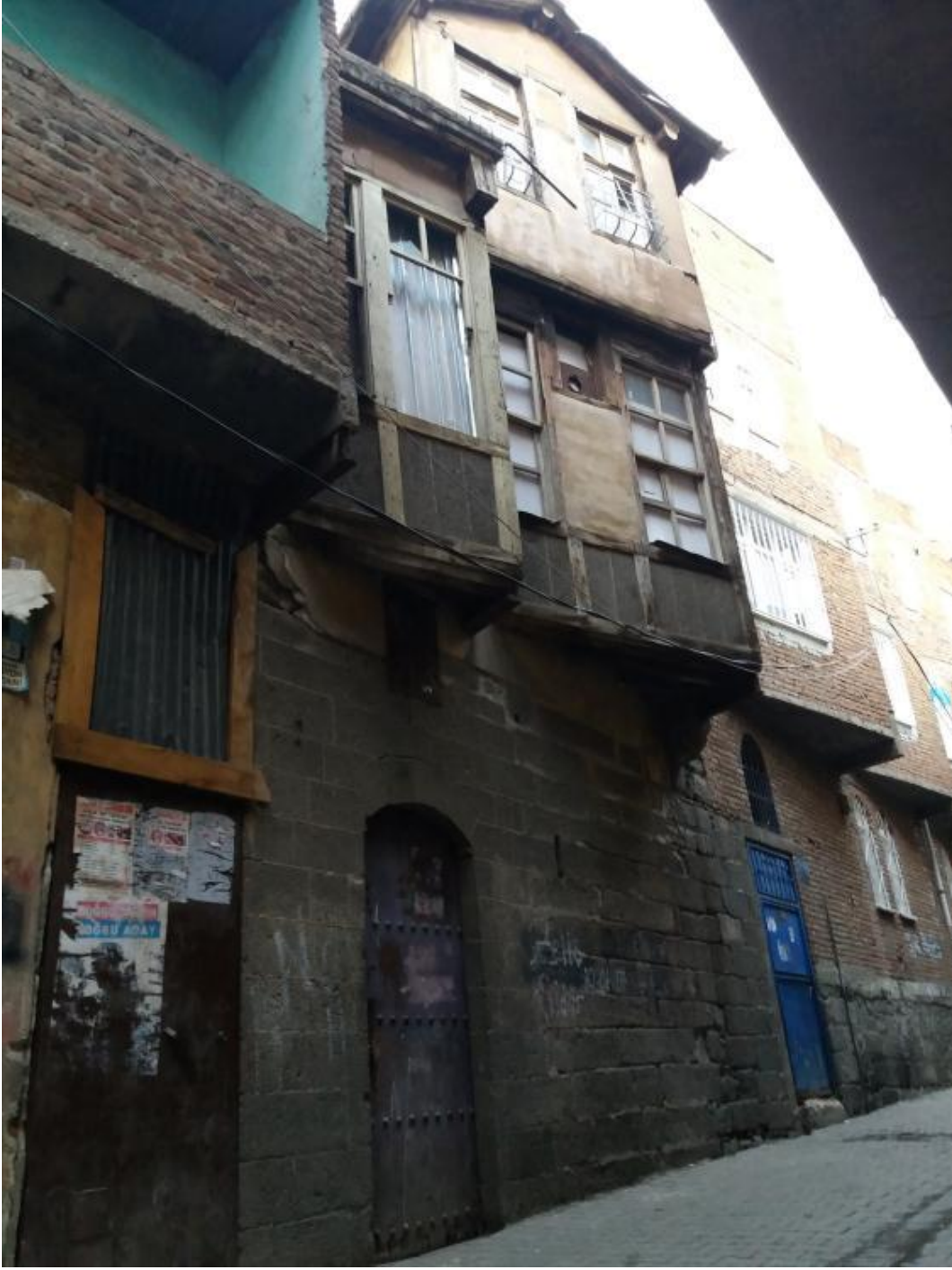
Foto 43: Sur'da ara sokakta semt sakinlerinin yaşadığı tarihi yapılar, üstü apartman, temel tarihi ev.
