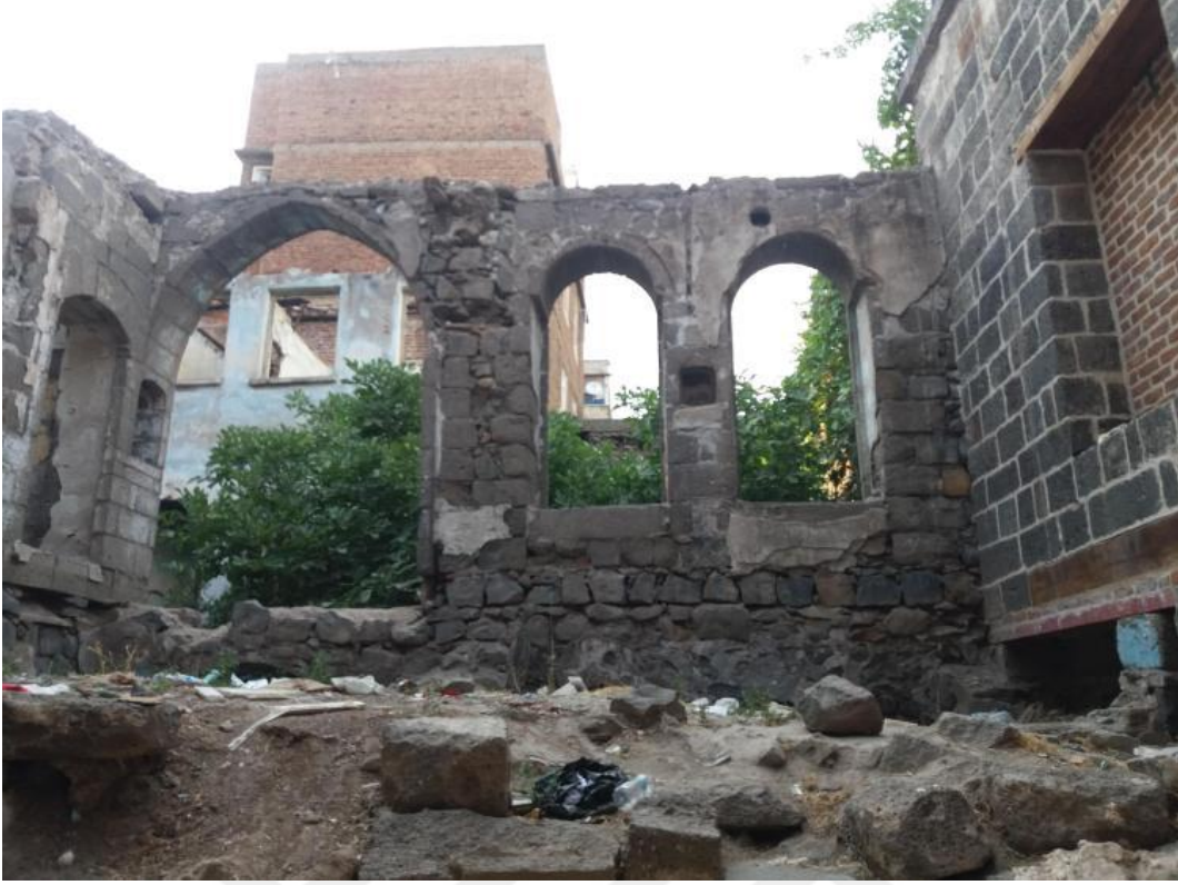
Foto 18: Sur'da ara sokakta bir metruk yapı.
