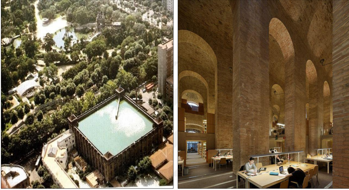
Resim 3.16. Su deposunun terasında depolanan suyun görünüşü (solda) ve iç mekan görünüşü (sağda) (Burrows, 2015)
