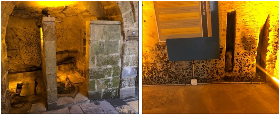
Resim 3.36. Pişirici Kasteli doğu yönündeki tuvalet bölümü (solda), mescit bölümü(sağda)
