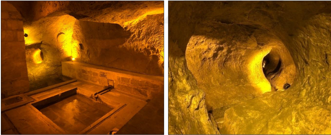
Resim 3.40. İhsan Bey Kasteli havuz bölümü (solda), kasteli besleyen livas sistemi (sağda)
