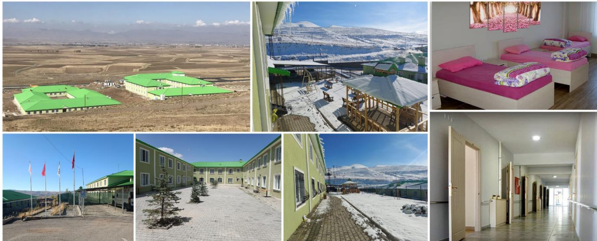
Şekil 23. Özel Güzide Bakım Merkezi binaları, çevresi ve içinden fotoğraflar
