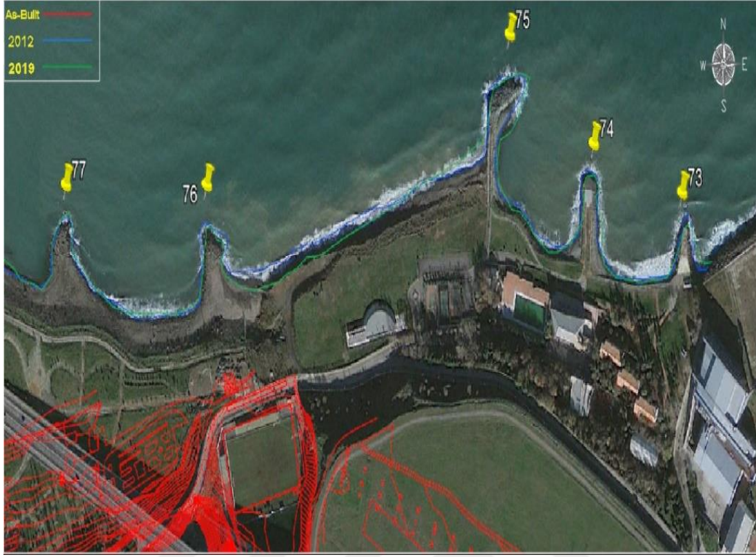
Şekil 28. Ortahisar (Merkez)'deki kıyı yapıları ve kıyı çizgisinin zamanla değişimi
