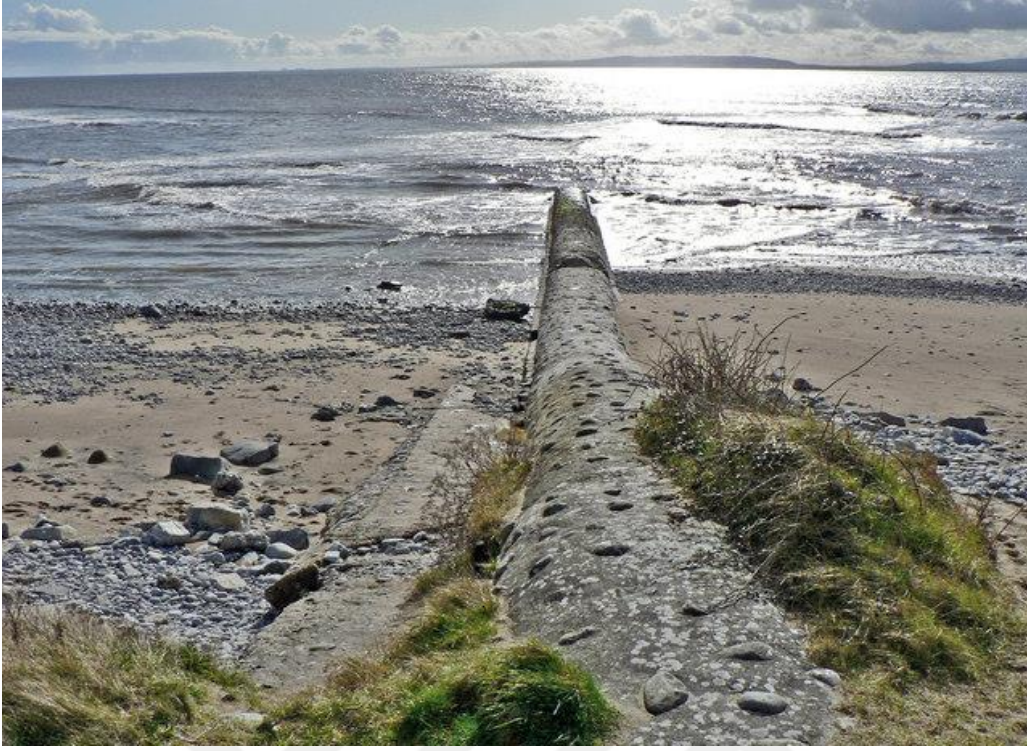
Şekil 4. Beton mahmuz
