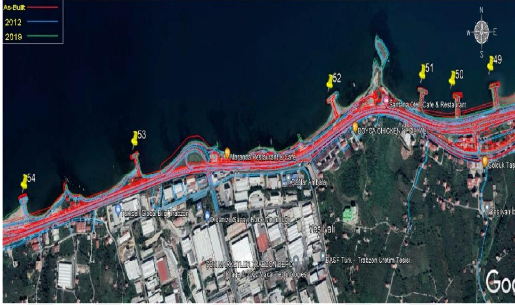
Şekil 26. Arsin'deki kıyı yapıları ve kıyı çizgisinin zamanla değişimi
