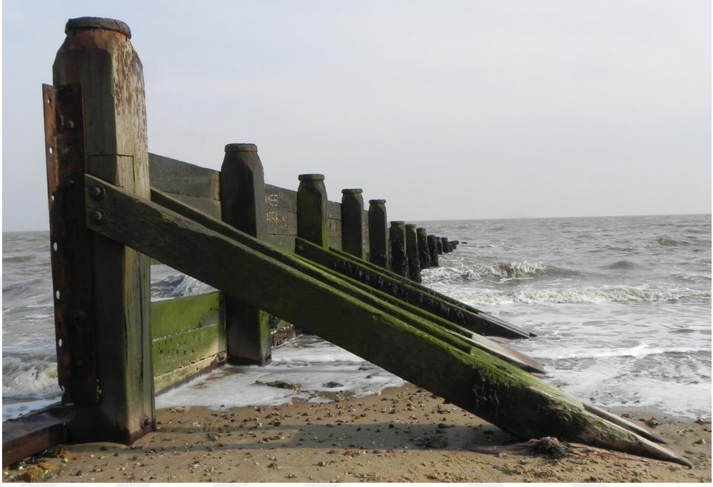
Şekil 6. Ahşap mahnuz
