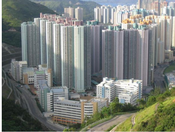
Şekil 2.4. Yüksek katlı Hong Kong yapıları ( https://tr.wikipedia.org/wiki/Sosyal_konut )
