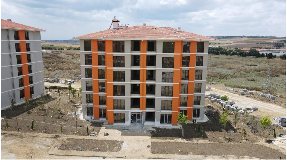
Şekil 3.18. Modellenen projenin mevcut yapı görünümü
