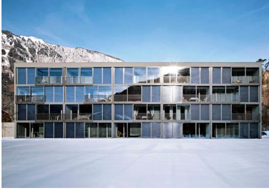
Şekil 57. Örnekte FDM pencerelerde iki cam panel arasında kullanılmaktadır. Faz değişimi ile camlar arasında kullanılan polikarbonat ayırıcılar, pencerelere jaluzi görünümü vermektedir (Ritter, 2007).
