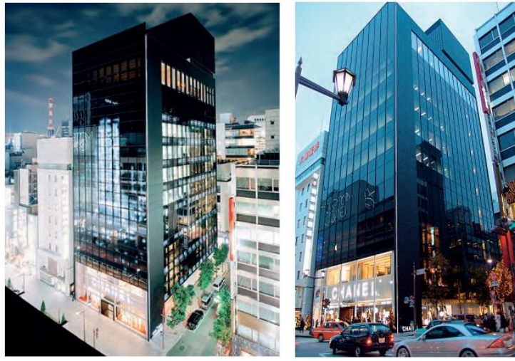
Şekil 27. Chanel'in 2004 yılında Tokyo'nda yapımı tamamlanan bina cephesinde elektrokromik cam kullanılmıştır (Ritter, 2007).
