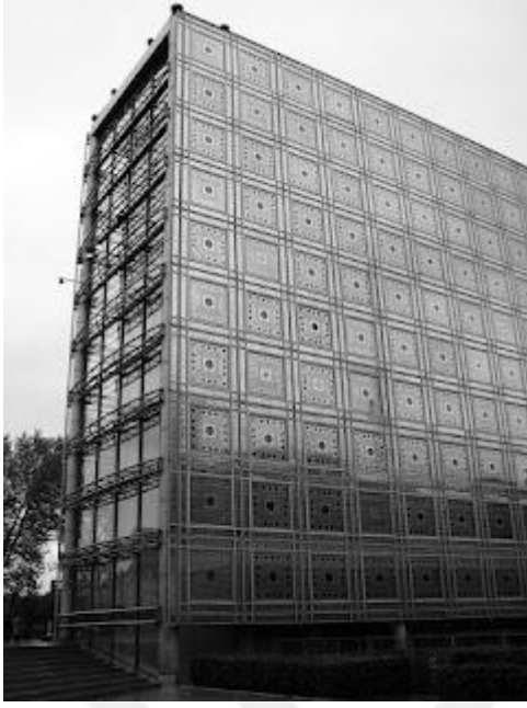
Şekil 1. Jean Nouvel'in Institut du Monde Arabe Bina Cephesi ve Mekanik Diyafram Detayı (arch365bilgi.blogspot.com)
