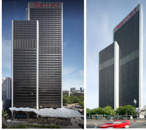
Şekil 49. Yenileme sonrası bina cephesine yerleştirilen PV paneller ( www.archdaily.com -h)
