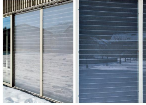
Şekil 57. Örnekte FDM pencerelerde iki cam panel arasında kullanılmaktadır. Faz değişimi ile camlar arasında kullanılan polikarbonat ayırıcılar, pencerelere jaluzi görünümü vermektedir (Ritter, 2007).
