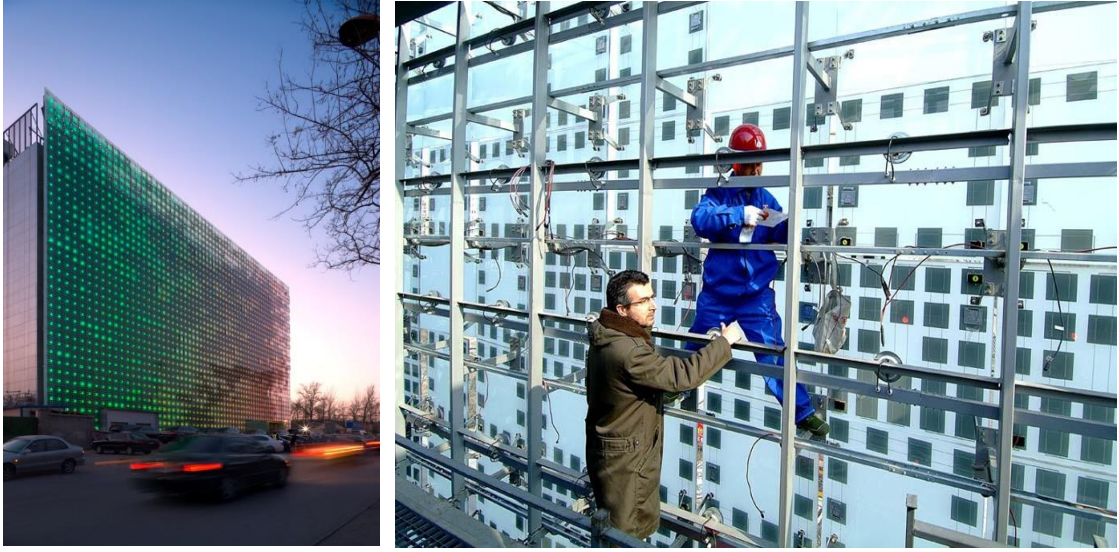
Şekil 44. Green Pix medya duvarı PV ve LED' in birlikte kullanımı ile oluşturulan cephe (www.archdaily.com –g).
