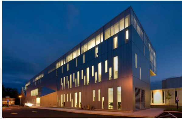
Şekil 37. Fotokatalitik alüminyum panel cepheli Bertram ve Judith Kohl Binası ( www.archdaily.com -f)
