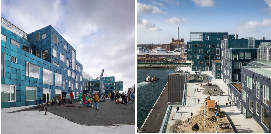
Şekil 51. Kopenhag Uluslararası Okulu Cephede yer alan PV paneller (architizer.com).
