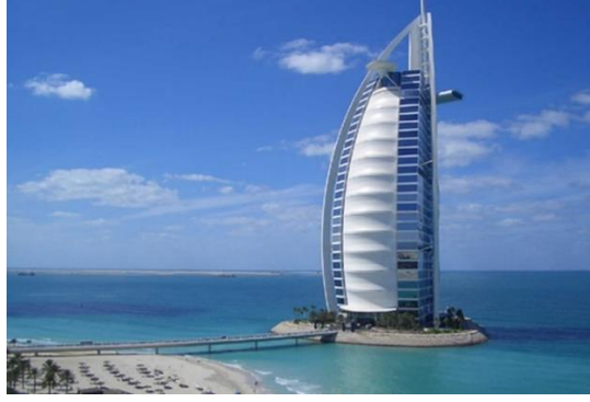
Şekil 35. Burj Al Arab PTFE (Politetrafloroetilen) kaplı cam elyaf kumaş membran uygulaması (ww.stylepark.com)
