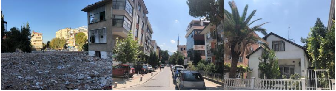
Fotoğraf 3.19. Sırapapılar Mahallesi’nde 1583 Sokak
