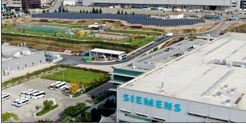
Şekil 3.5. Siemens Gebze Fabrikası
