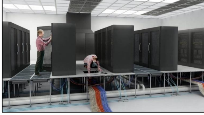
Şekil 3.11: Tipik bir yükseltilmiş döşeme sistemi.
