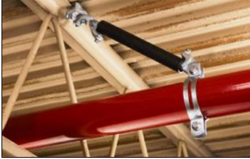
Şekil 3.6: Mekanik tesisat sismik askılama sistemi.
