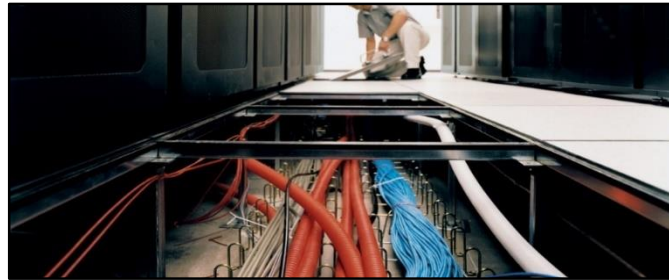
Şekil 3.10: Tipik bir yükseltilmiş döşeme sistemi.
