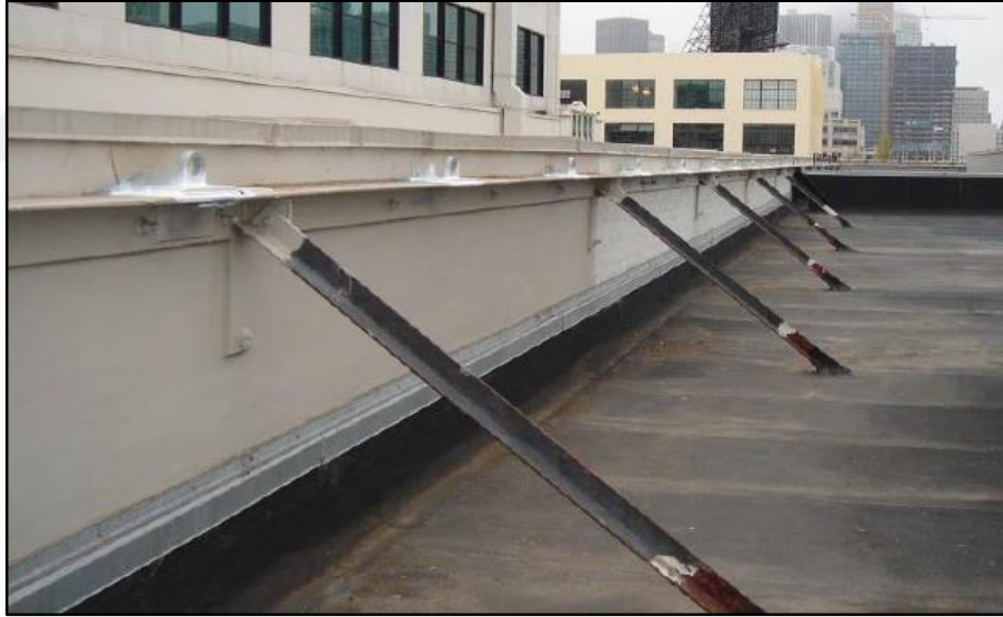
Şekil 3.7: Çatı parapet duvarı destek elemanı.
