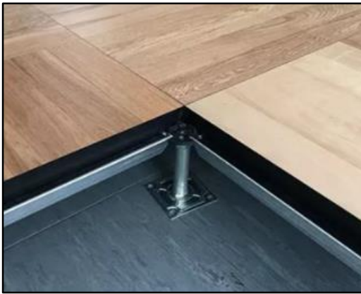
Şekil 3.12: Lamine kaplı yükseltilmiş döşeme sistem.
