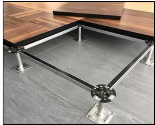
Şekil 3.12: Lamine kaplı yükseltilmiş döşeme sistem.
