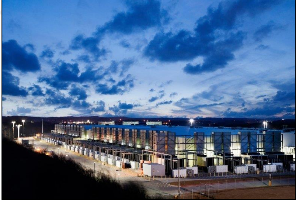
Şekil 2.1: Douglas County, Ga'daki Google veri merkezi yapısı.
