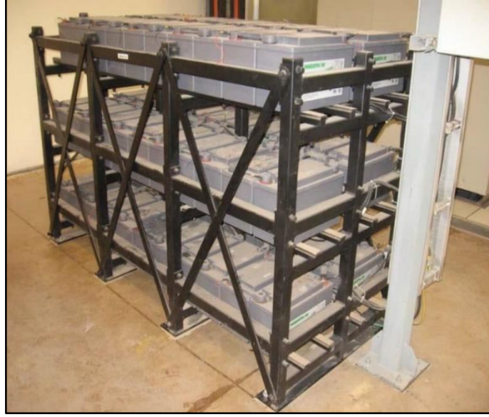
Şekil 3.8: Yanal ötelenmesi sınırlandırılmış raf sistemi.
