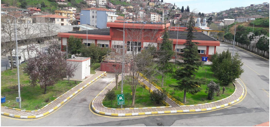
Şekil 3.1 : Küçüküsu atıksu ön arıtma tesisi.
