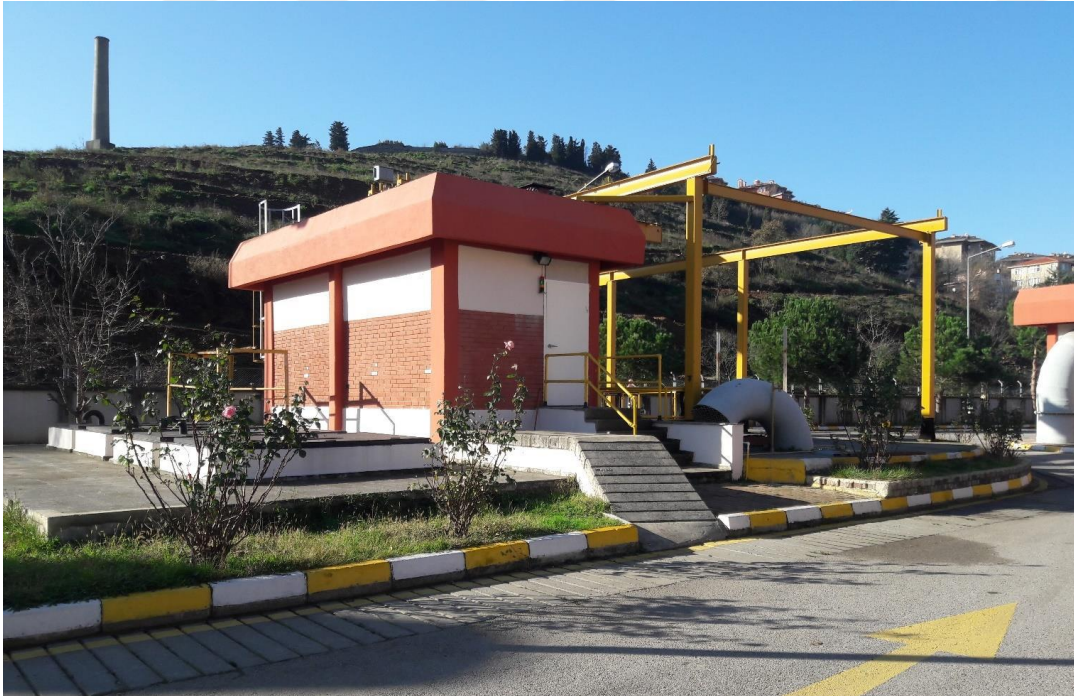
Şekil 3.6 : Giriş terfi merkezi.
