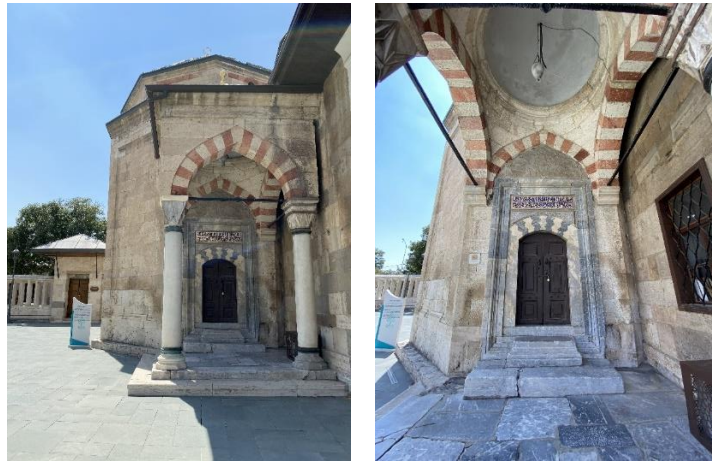
Şekil 36. Hürrem Paşa Türbesi
