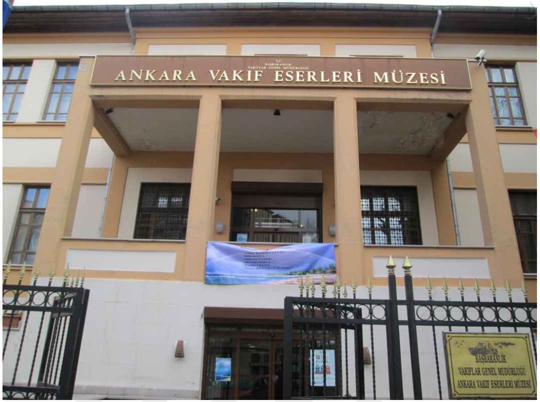
Görsel 111: Müze Binasının Balkon ve Giriş Kısmı (Pandemi Öncesi)
