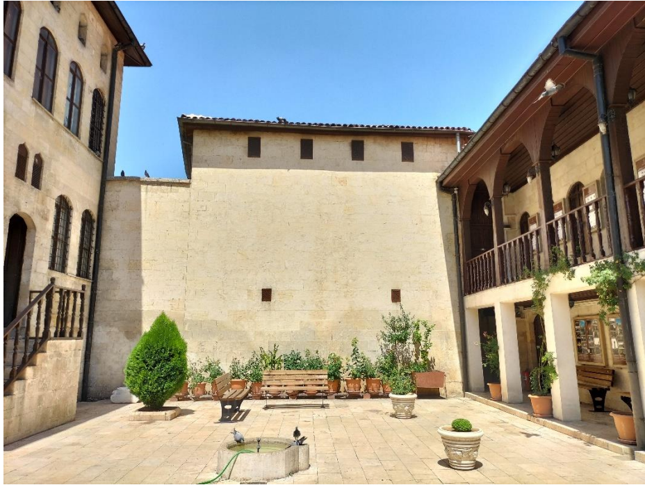
Görsel 202: Müzenin Aynı Avlu İçerisinden İki Farklı Binası
