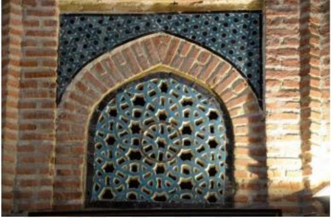
Görsel 89: Müze Binasının Kuzeybatı Penceresinden Bir Görünüm
