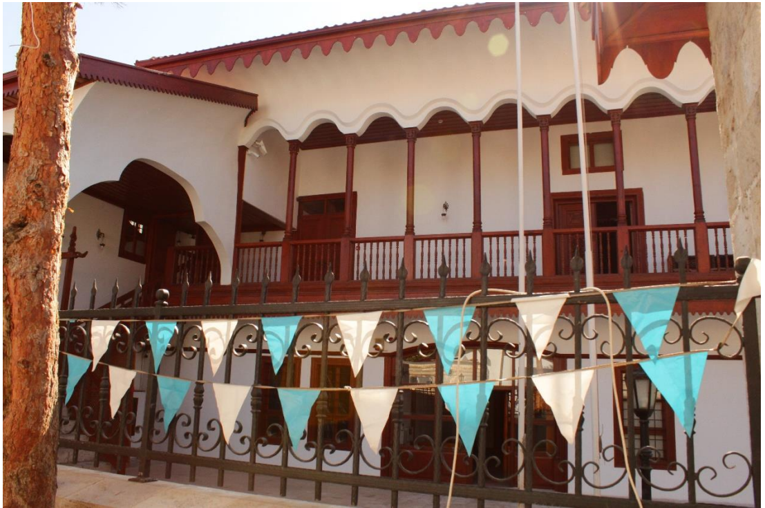
Görsel 52: İki Katlı Müze Binası Giriş Cephesi
