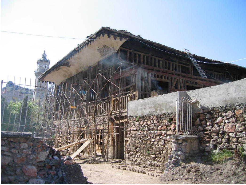
Görsel 48: Mevlevihane Binasının Restore Halindeki Görüntüleri (VBM Arşivinden)
