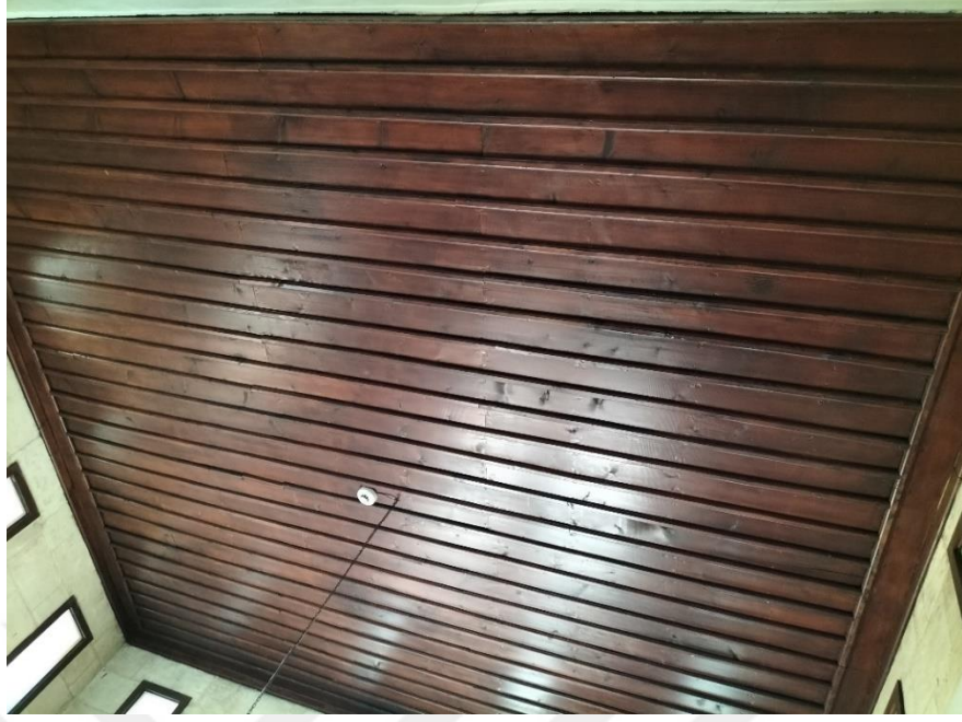
Görsel 209: Müzenin Üç Katlı Selamlık Binasından Ahşap Tavan
