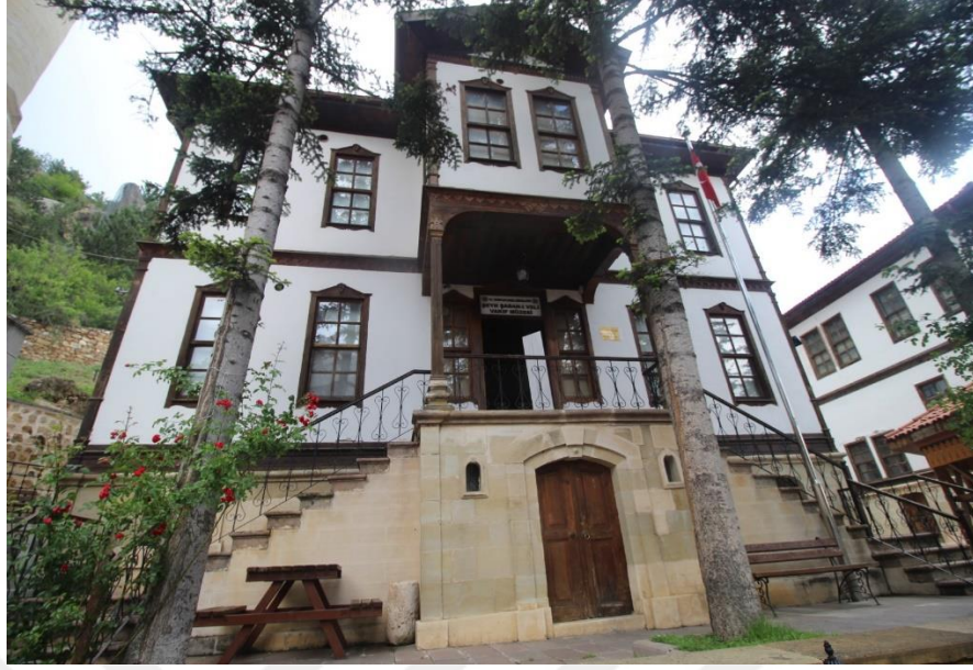
Görsel 148: Müze Binasının Dış Cephesinden Bir Görünüm
