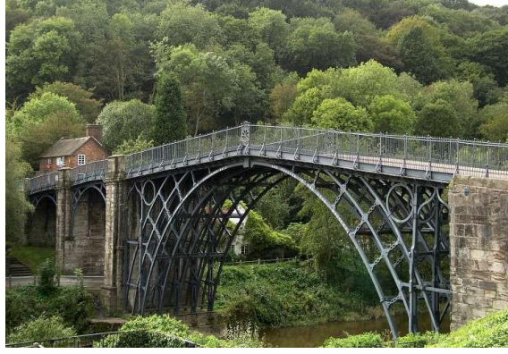
Şekil 2.5 Demirin Köprülerde Kullanılması; Coalbrookdale Köprüsü [7]
