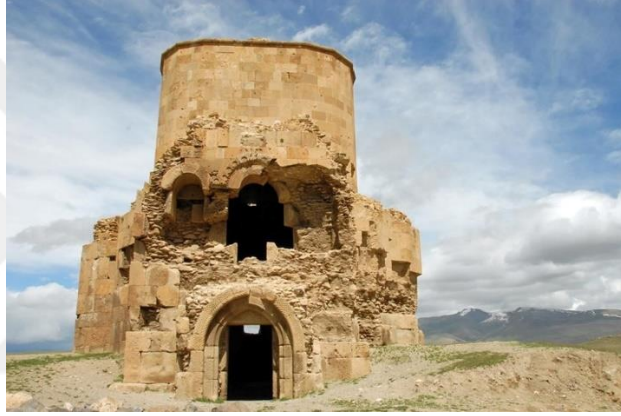
Şekil 3.15 Van'daki Depremler Sonucu Zoradir Surp Eçmiadzin Ermeni Kilisesi'nin Hasar Görmesi [38]
