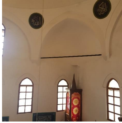
Şekil 2.7 Demirin Gergi Sistemi, Kazdağlıoğlu Camii, Safranbolu
