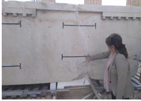
Şekil 6.11 Parthenon'da Demir Kenetler Kaldırılarak Yerine Titanyum Kenetler Kullanılması [82].
