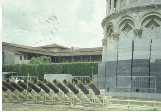
Şekil 6.27 Pisa Kulesi Zemin Boşaltma Yöntemi [102]
