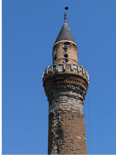
Şekil 3.22 Sivas Ulu Camii Parça Kopması [34]
