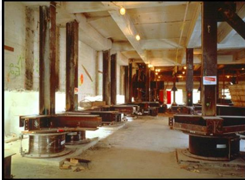
Şekil 5.23 :San Francisco Sanat Müzesi Sismik Yalıtım Uygulaması [77]
