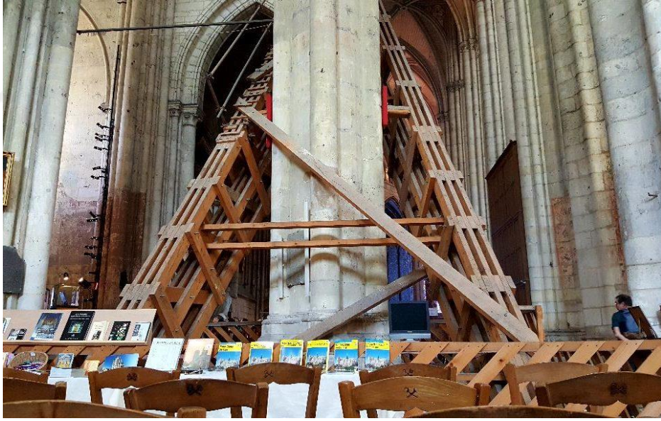
Şekil 6.112 Beauvais Katedrali'nde Sütunlarda Alınan Önlemler [174]
