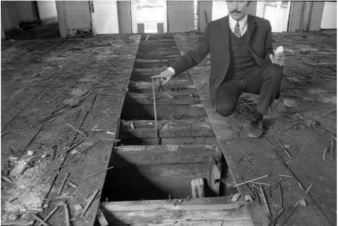
Şekil 6.135 Mimar Sinan Mimarlık Fakültesi’nin Ahşap Kirişli Döşemelerinin Betonarme Döşemeye Çevrilmeden Önceki Hali [182]
