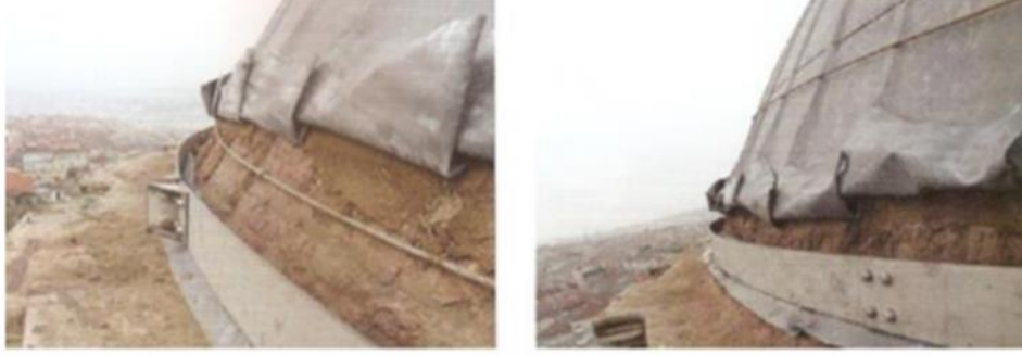
Şekil 5.15 Mihrimah Sultan Camii 'nde Kullanılan Çekme Çemberi [65]
