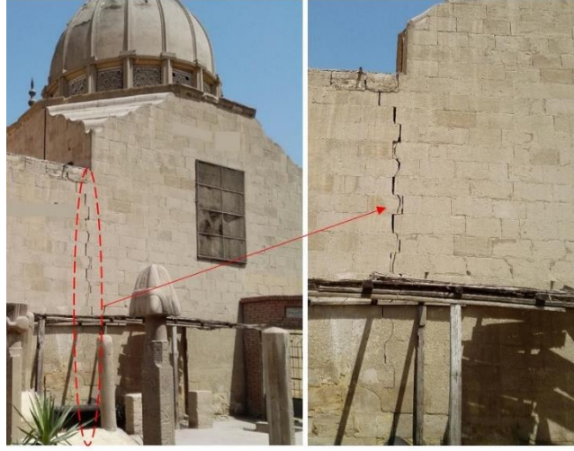
Şekil 3.8 Tarihi Yapılarda Ayrılma, Hosh al-Basha, Mısır [35]
