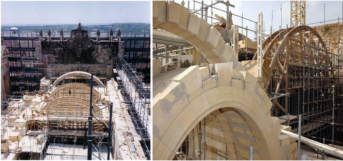
Şekil 6.49 Noto Katedrali'nde Kemerlerin Yapım Aşaması [125]
