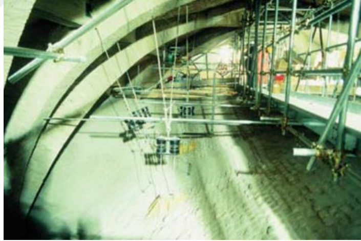
Şekil 6.121 St. Francis Bazilikası'nda Tonozu Çatıya Asmak İçin Geçici Yay Sistemi [66]
