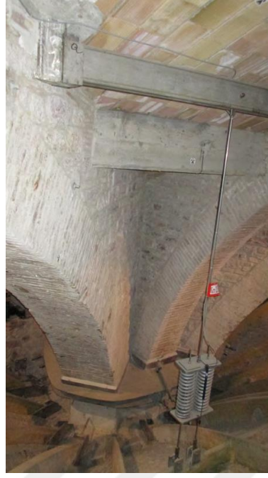
Şekil 6.131 St Francis Assisi Bazilikası'nda Tonoz Stabilizasyon Sisteminin Bir Parçası Olarak, Yay ve Amortisör Sistemi [181]
