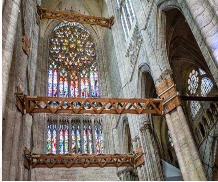
Şekil 6.113 Beauvais Katedrali'nde Kullanılan Geçici Ahşap Kafes Kiriş Sistemi [174].
