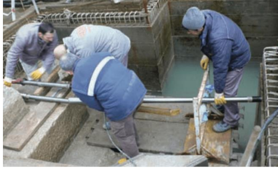
Şekil 6.102 San Marco Çan Kulesi'nin Temeline Titanyum Çubukların Montajı [161].
