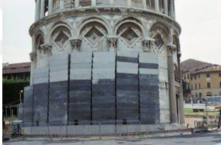
Şekil 6.26 Pisa Kulesi' nde Kullanılan Geçici Kurşun Ağırlıklar [101]
