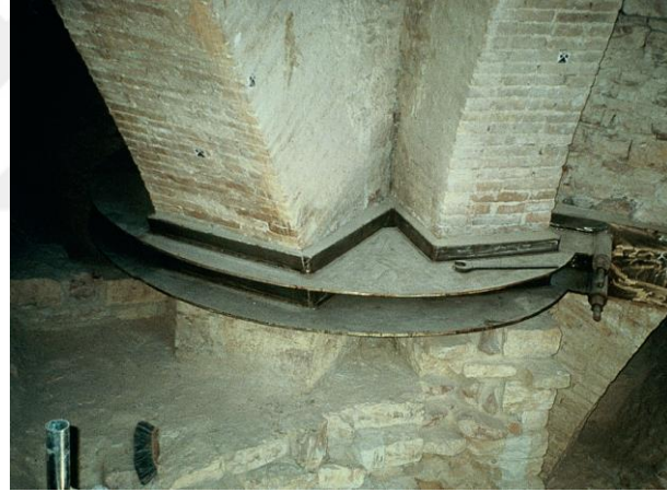
Şekil 6.130 St Francis Assisi Bazilikası'nda Ana Kemerlerde Uygulanan Takviye [179]
