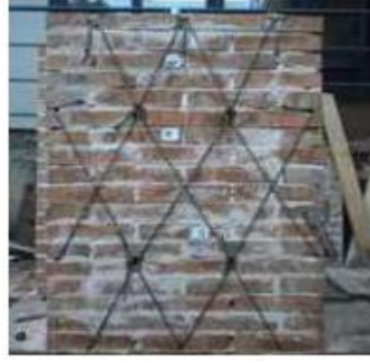
Şekil 5.13 FRP Halat Yöntemi [62]
