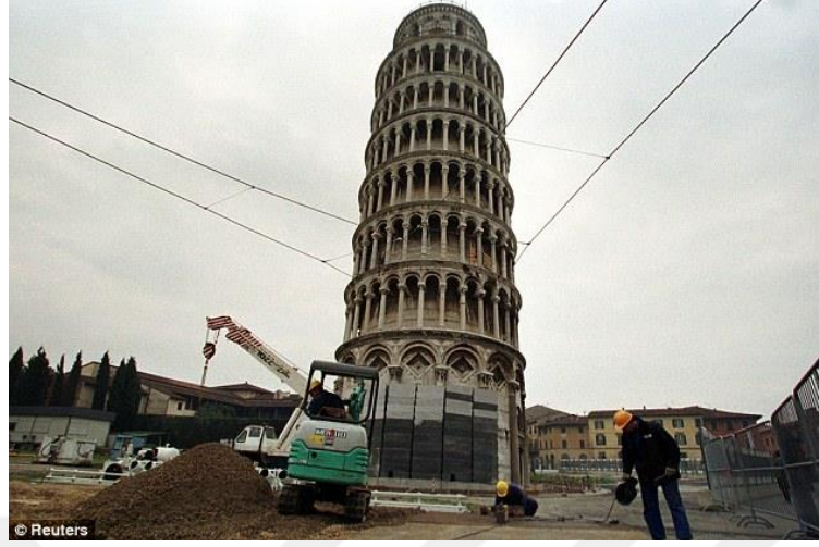
Şekil 6.25 Pisa Kulesi Çelik Kablo Uygulaması [101]
