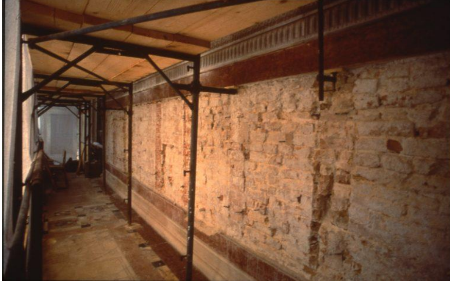
Şekil 6.63 Tuzdan Arındırma İçin Mermer Levhalar Kaldırıldıktan Sonra Miracoli Duvarı [134]
