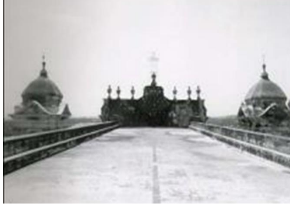
Şekil 6.44 1950 'li Yıllarda Noto Katedrali'nde Düz Betonarme Döşemeli Çatı Uygulaması [120].
