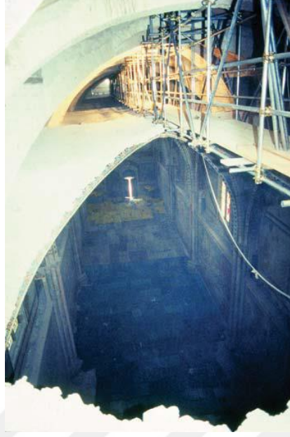
řekil 6.122 St. Francis Bazilikası'nda elik Asma Kprü Uygulaması [178].
