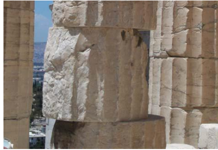
Şekil 3.14 Sütunlarda Kayma [33]
