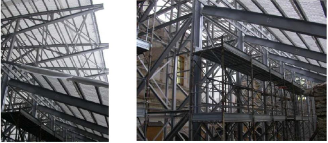
Şekil 6.78 Santa Maria Paganica Kilisesi Yapı 3 Bölümü Montaj Aşaması [145]
