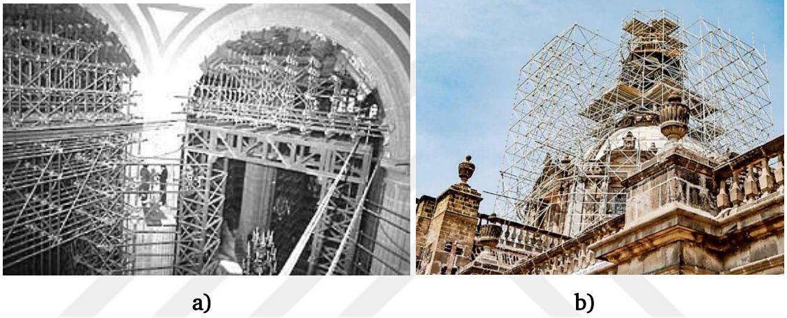
Şekil 6.34 a) Metropolitan Katedrali Kurulan İç İskele ve Yapısal Destekler, b) Dış İskele ve Yapısal Destek [108].
