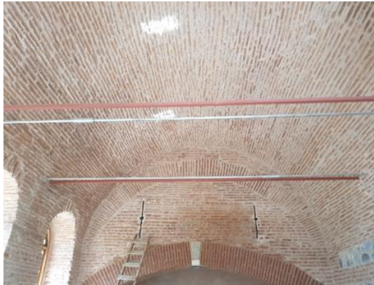
Şekil 5.5 Kağıthane Tarihi Çamaşırhane Binası Gergi Uygulaması
