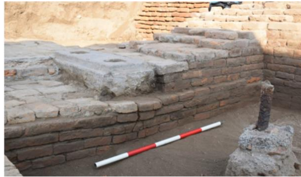
Şekil 6.90 Kasthamandap'ın Temellerinde Tespit Edilen Dikey Çatlaklar [149].
