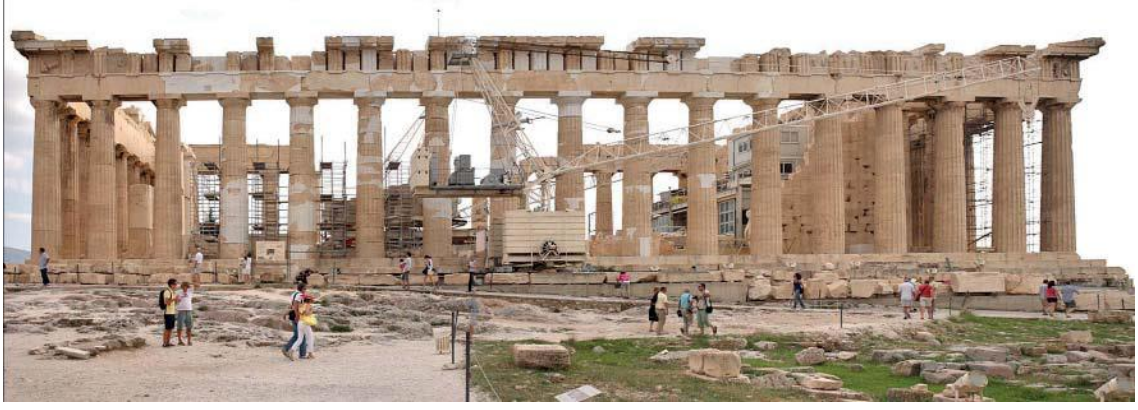
Şekil 6.13 2010 yılına ait Parthenon'nun Kuzey Cephesindeki Çalışma [89]
