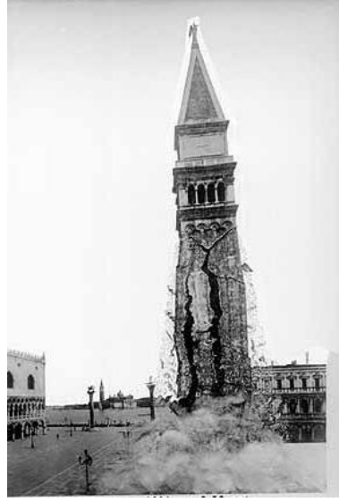
Şekil 3.10 San Marco Çan Kulesi'nin 1902'de Yıkılması, Yetersiz Temel Boyutlandırma [37]
