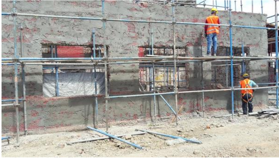
Şekil 5.10 Hasnapaşa Gazhane Binası'nda Uygulanan FRP Izgara Sistemi
