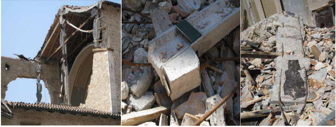
Şekil 6.70 Santa Maria Paganica Kilisesi'nin Çatısında Kullanılan Betonarme Döşeme Parçaları [140]
