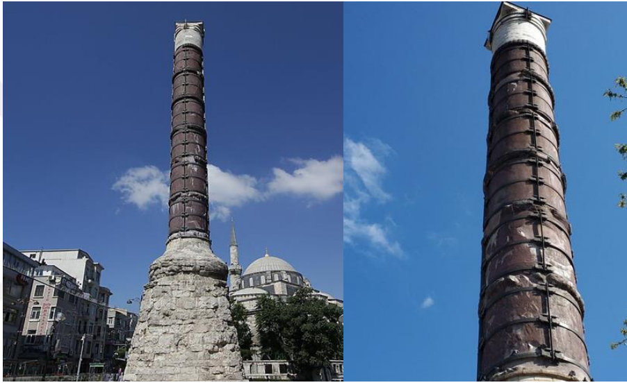
Şekil 5.6 Çemberlitaş Çemberleme Yöntemi [59]
