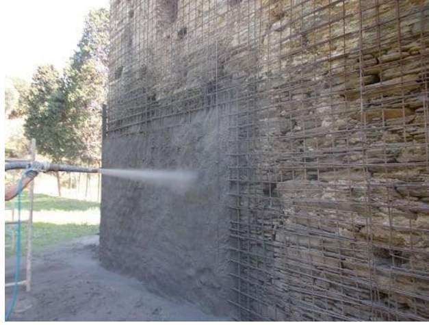
Şekil 5.7 Çelik Hasır ile Güçlendirme [41]
