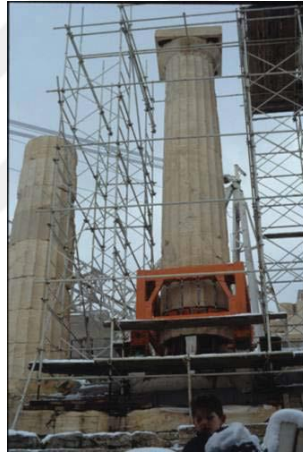
Şekil 6.6 Manolis Korres Tarafından Sütunlar İçin Tasarlanan Cihaz [81]
