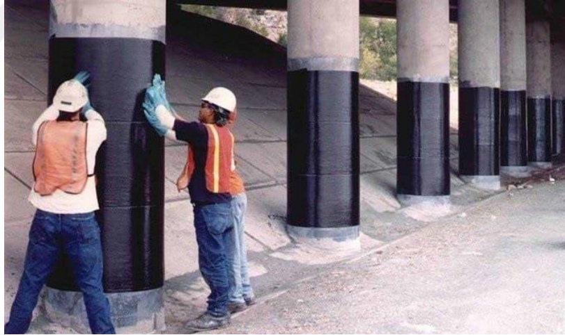
5.12 FRP Kumaş ile Güçlendirilmesi [64]
