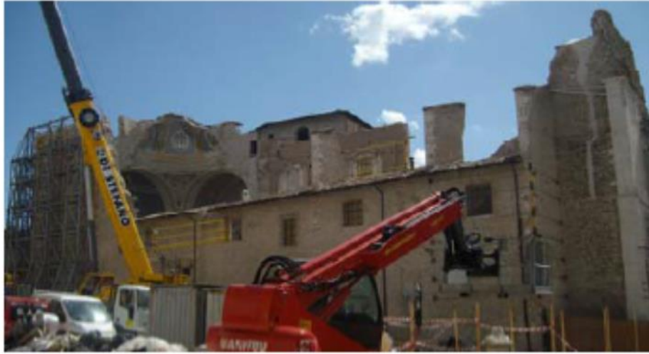
Şekil 6.71 FRP Sisteminin Yapıda Uygulanması [145]
