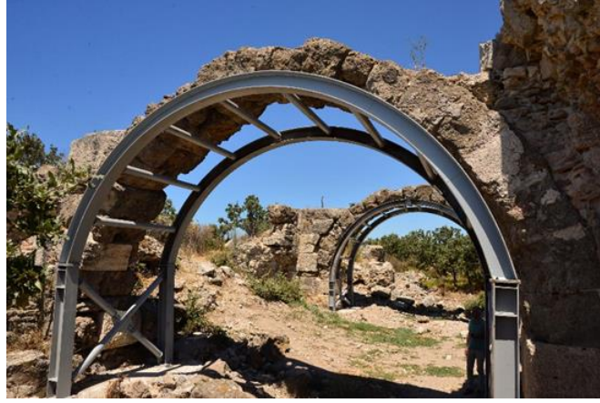
Şekil 5.22 Çanakkale Herodes Atticus Hamamı Kemerleri' nin Çelik Konstrüksiyon ile Desteklenmesi [76]
