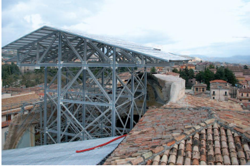
Şekil 6.76 Santa Maria Paganica Kilisesi Yapı 1 bölümü (Nef bölümünden) montaj Aşaması [147]
