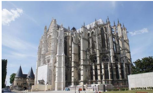
Şekil 6.105 Beauvais Katedrali Görünüş [163].
