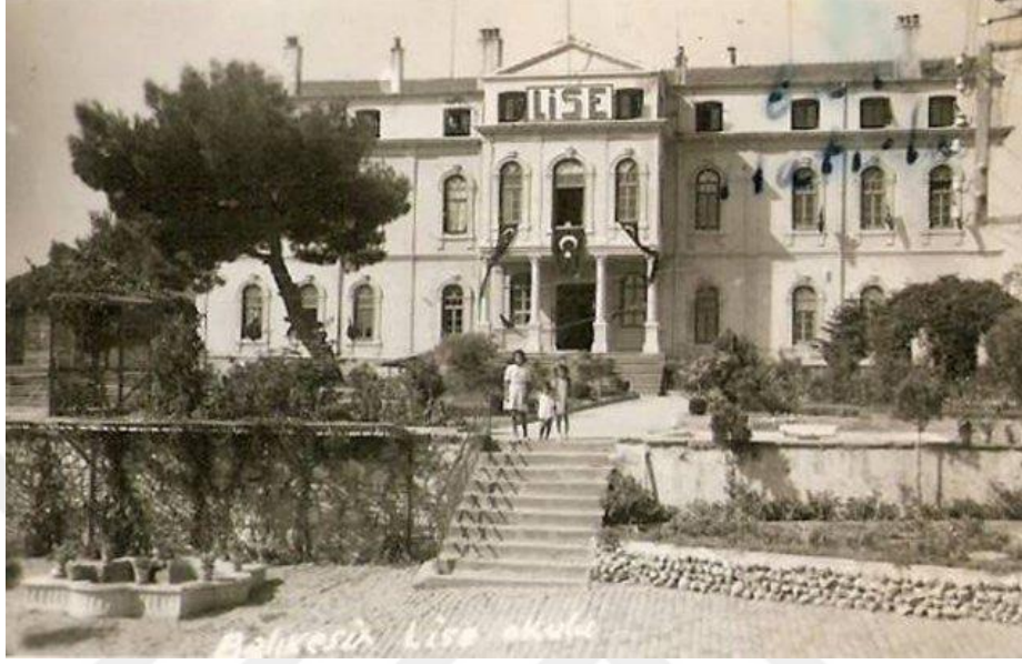
Şekil 4.8: Bahçeden Günümüz Hacılbey M.T.A. Lisesi Arsasına Geçiş Merdiveni
