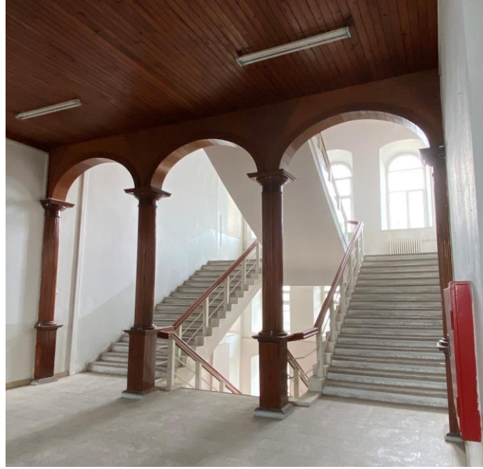
Şekil 4.15: Zemin Kat Merdiven Holü
