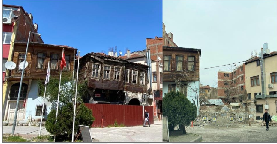
Şekil 3.32: Bölgede Tez Sürecinde BBB Tarafından Yıkılan Konut
