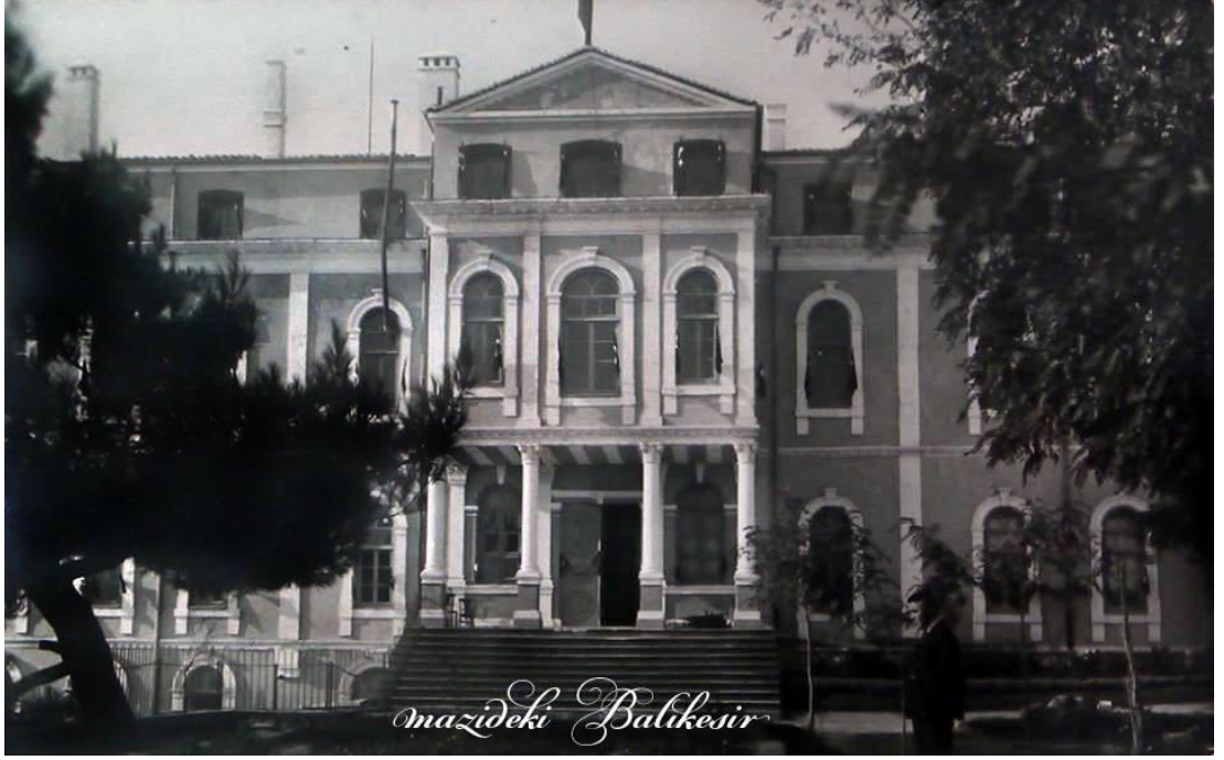
Şekil 4.33: Karesi İdadisi Kuzeydoğu Cephesi
