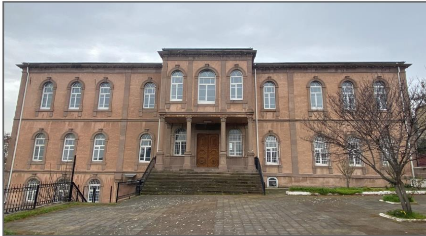
Şekil 4.32: Karesi İdadisi Kuzeydoğu Cephesi 2022
