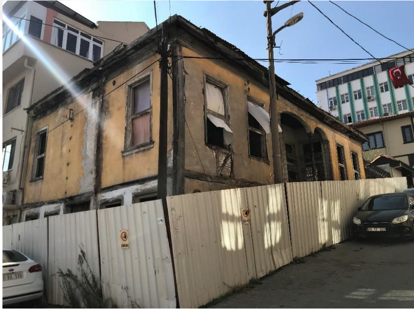
Şekil 3.36: Türk Ocağı Restorasyon Öncesi Fotoğrafı, 2020
