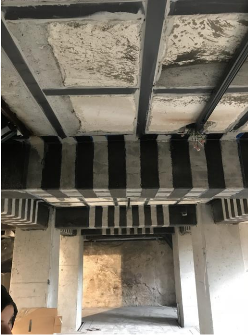
Şekil 2.3 Karbon Elyaf Güçlendirme 2019
