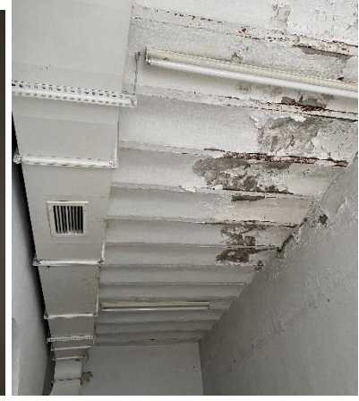
Şekil 4.27: Volta Döşemeli Bölüm
