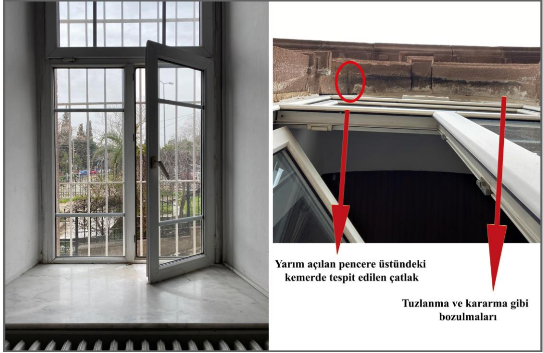
Şekil 5.13: Karesi İdadisi Yarım Açılan Pencere Örneği ile Hasarlı Kemer
