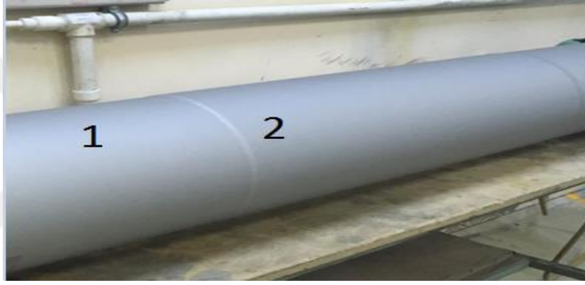
Şekil 4.6: Sıvama Sonrası Boruya Ait Görsel
