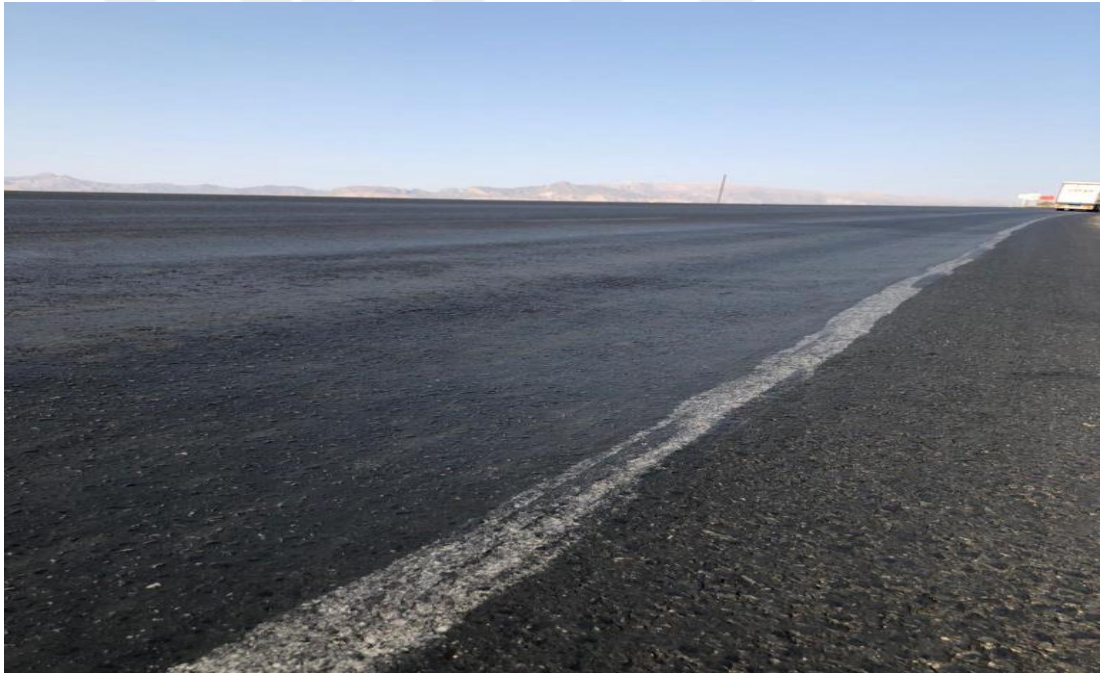
Şekil 1.11. Silopi-Cizre Karayolu Yolu Yeni Yapılan Kısımındaki Hafif Ondülasyonlar (2022)
