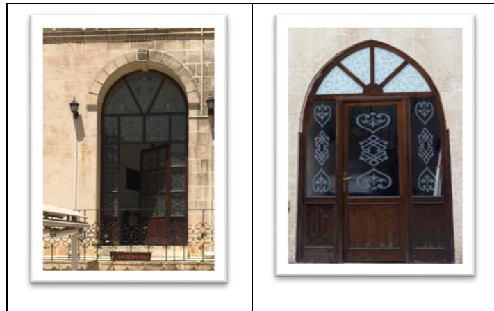
Şekil 3.41 Camekanla kapatılmış eyvan örnekleri (2022)
