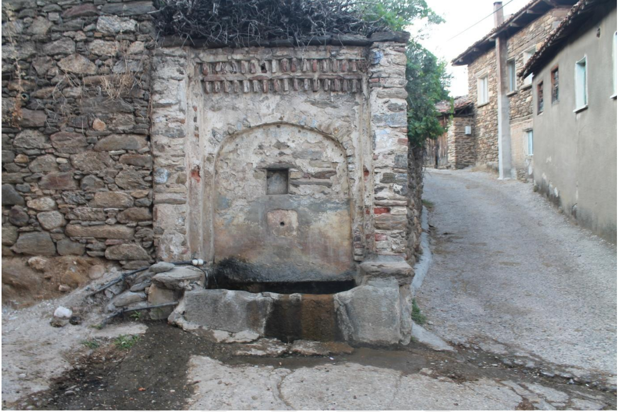
Fotoğraf 9: Pınarlı Köyü Çeşmesi (Katalog No 5) Ön Cephe.
