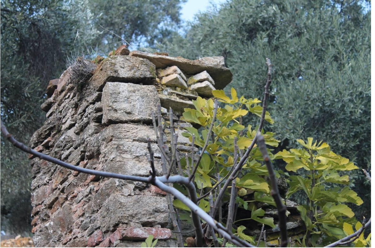
Fotoğraf 161: Dalama Beldesi Çeşmesi (Katalog No 56) Kirpi Saçak.
