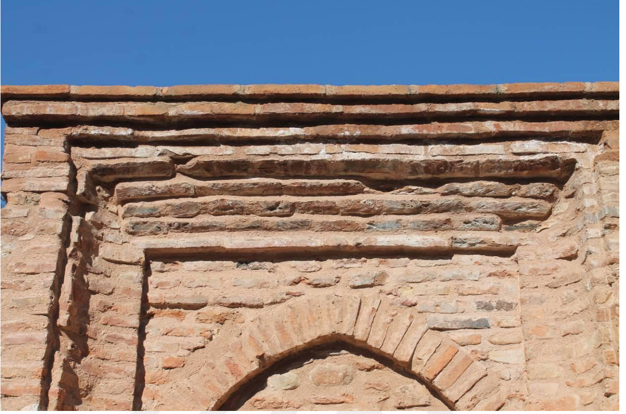
Fotoğraf 148: Cihanoğlu Mustafa Ağa Hanı Çeşmesi (Katalog No 52) Saçak.
