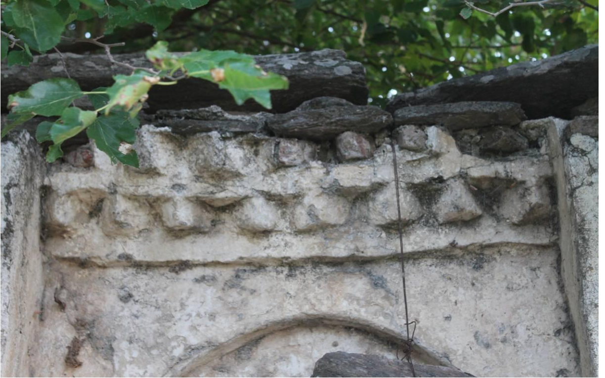
Fotoğraf 41: Camızağılı Mahallesi Çeşmesi (Katalog No 16) Kirpi Saçak.
