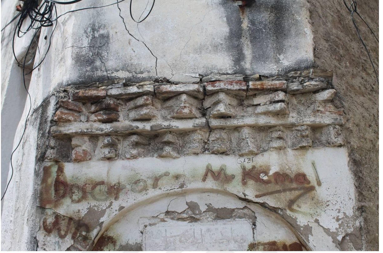
Fotoğraf 98: Cezayirli Mustafa Paşa Çeşmesi (Katalog No 37) Kirpi Saçak.
