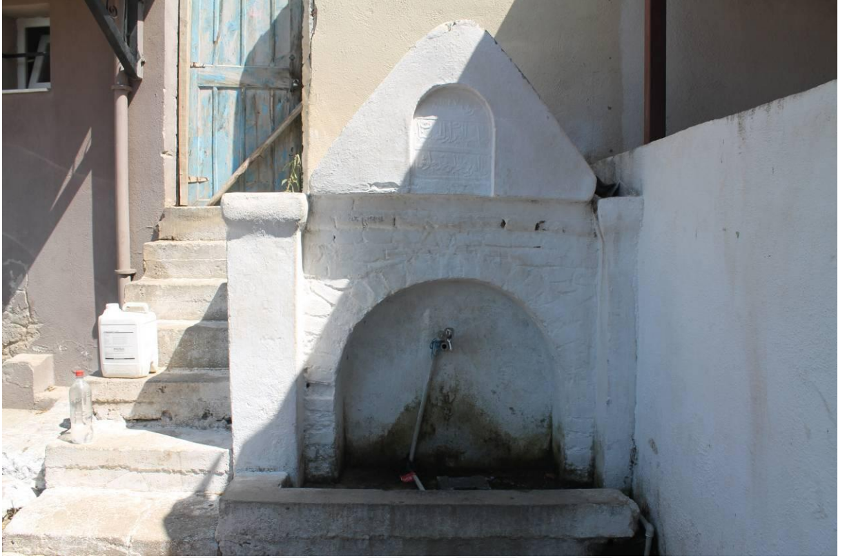
Fotoğraf 205: Hacı Muhammed Çavuş Çeşmesi (Katalog No 73) Genel Görünüm.
