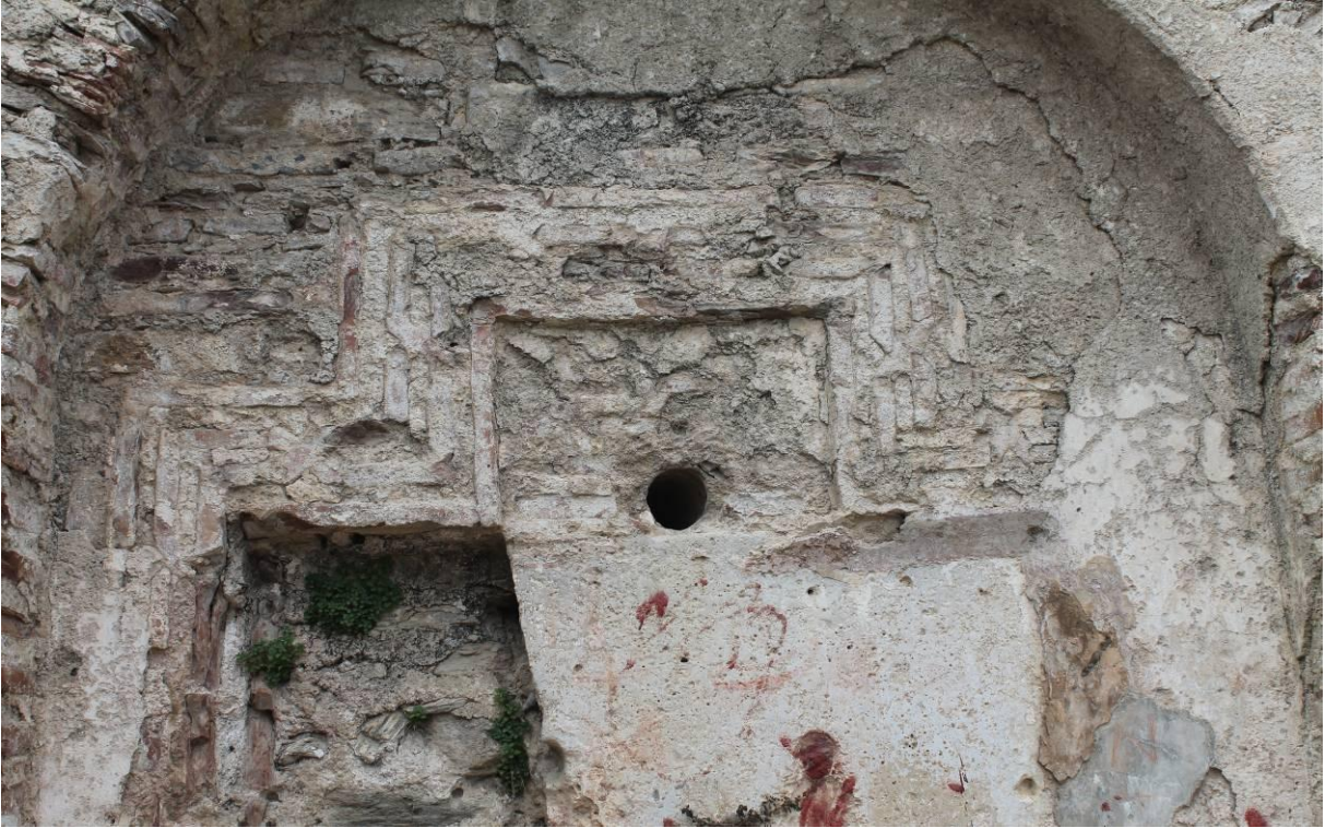
Fotoğraf 86: Çerkez Köyü Çeşmesi (Katalog No 32) Ön Cephe Detay.
