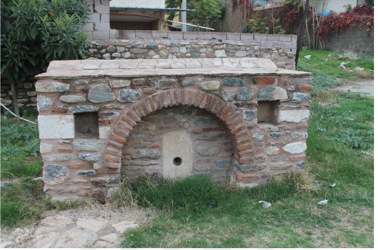
Fotoğraf 156: Nasuh Paşa Çeşmesi (Katalog No 54) Güney Cephe.
