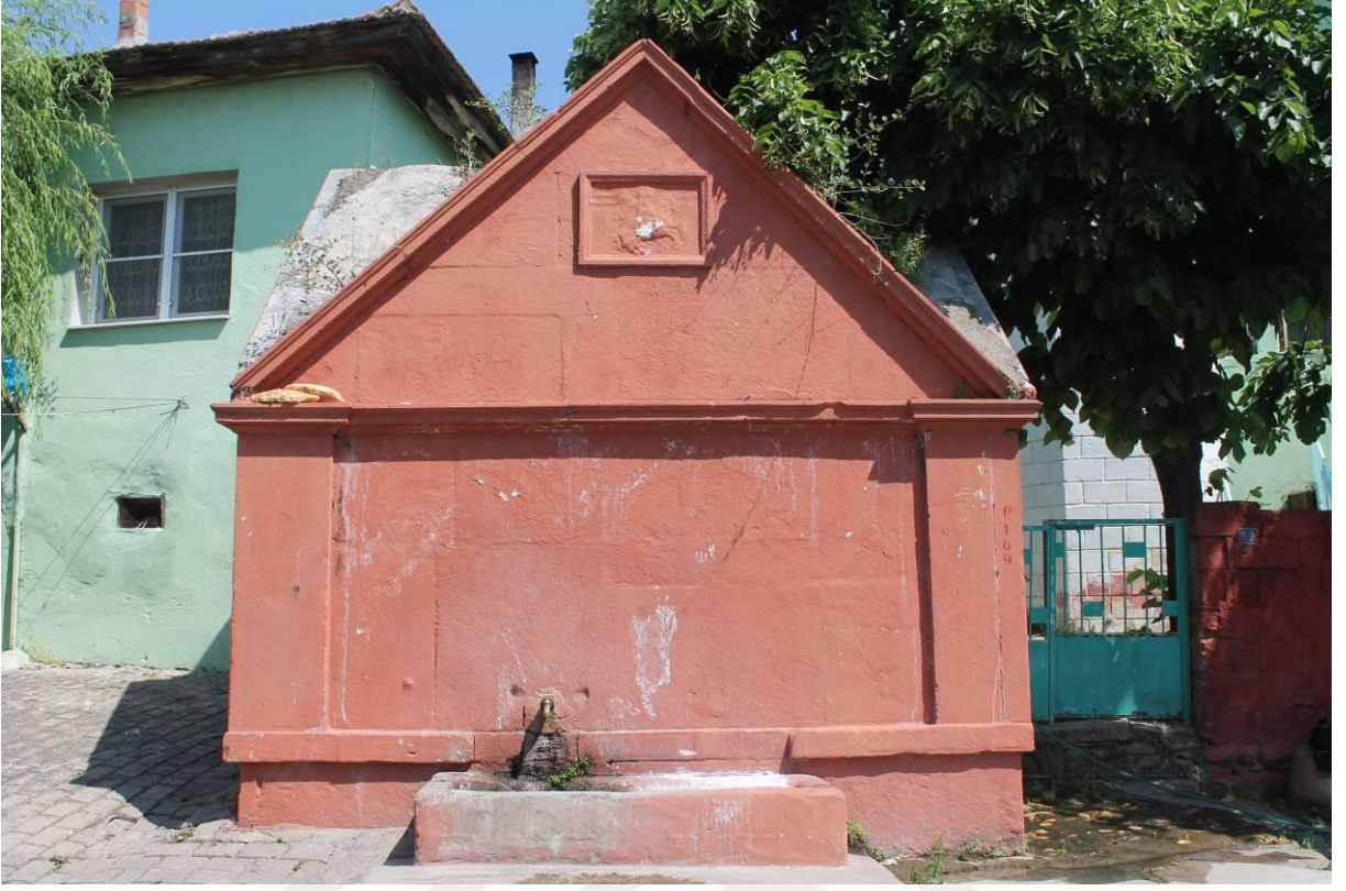
Fotoğraf 187: Kemalpaşa Cami Çeşmesi (Katalog No 66) Batı Cephe.
