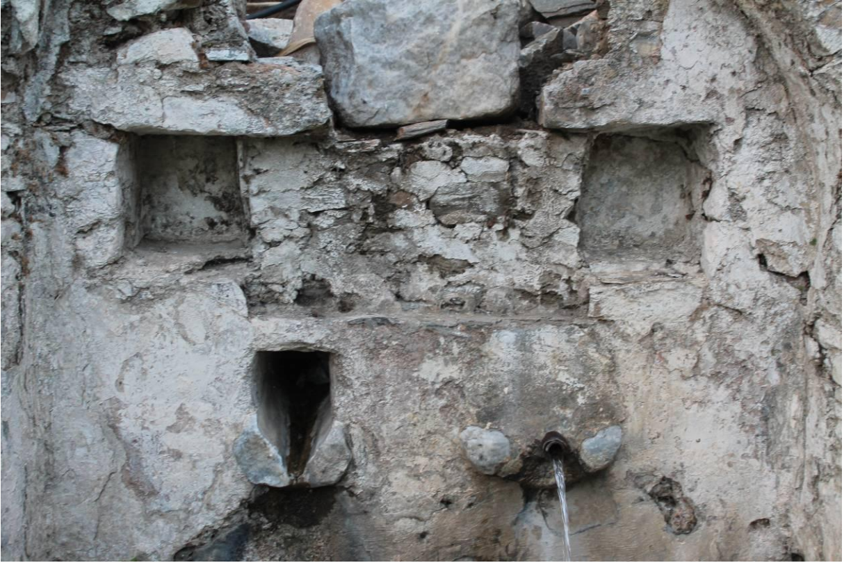
Fotoğraf 204: Güllübahçe Çeşmesi (Katalog No 72) Ön Cephe Detay.
