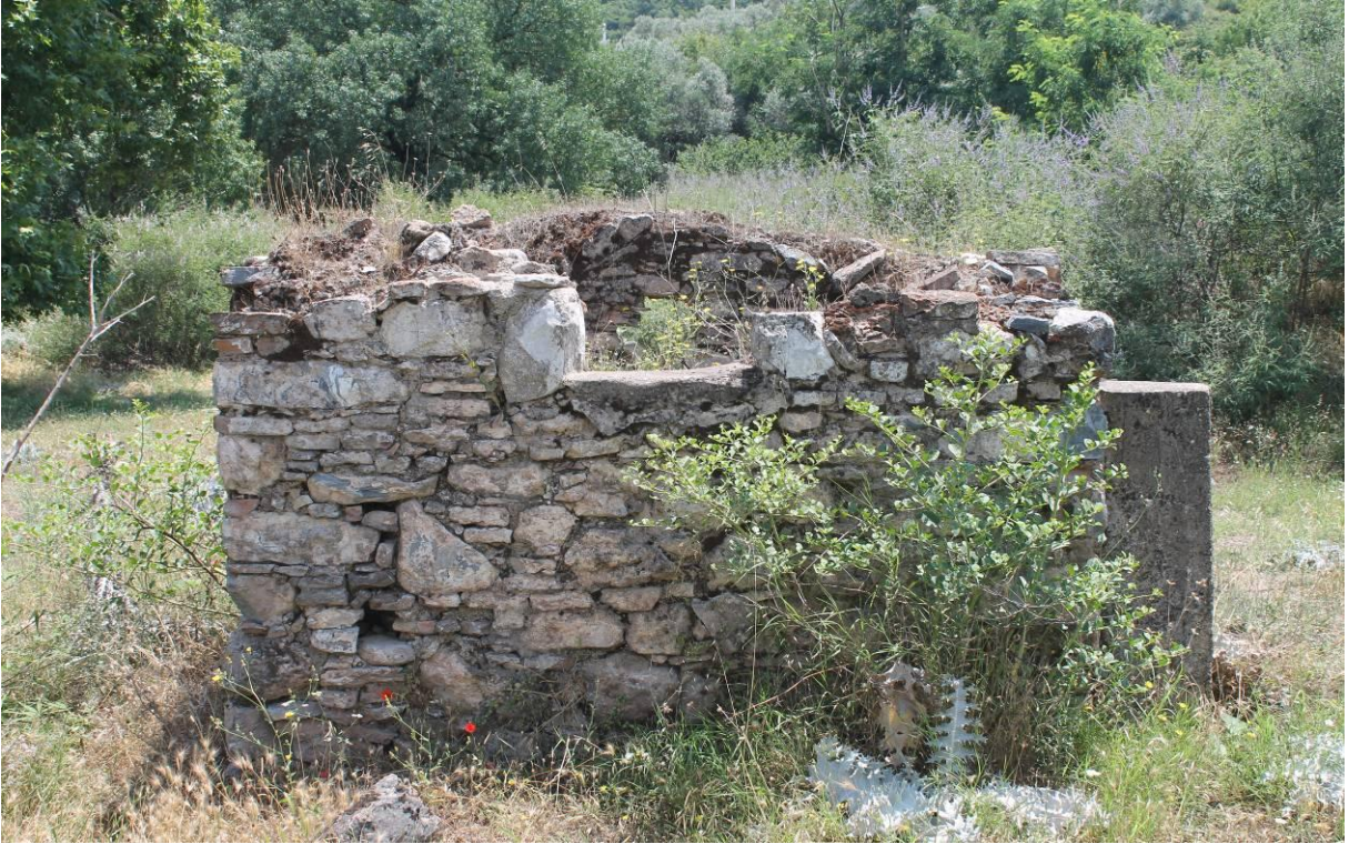
Fotoğraf 45: Gümüşköy 1 No'lu Çeşme (Katalog No 17) Arka Cephe.
